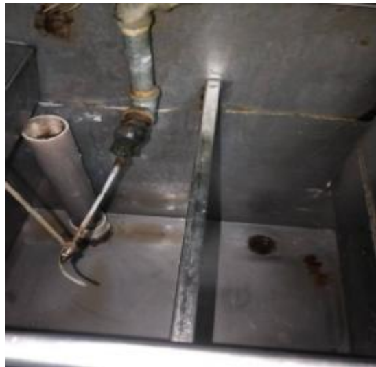
运水控制箱清洗后
