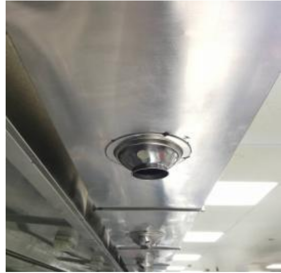
新风管道清洗后
