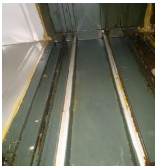
净化器内部清洗后
