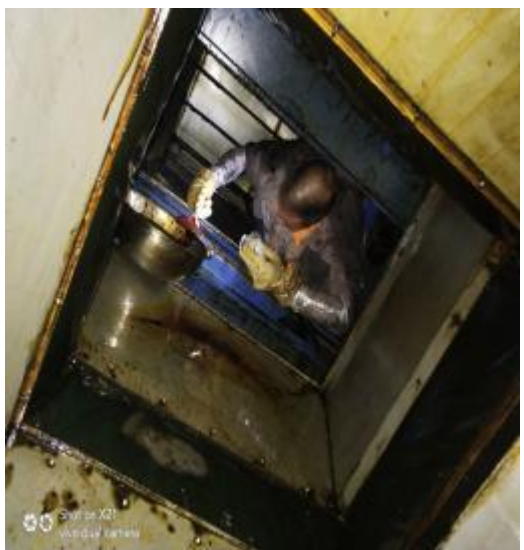
净化器内部施工
