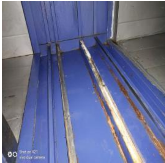
净化器内部清洗后
