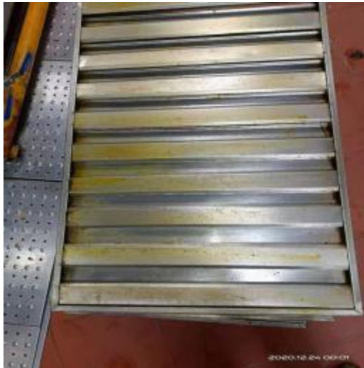
防火板清洗前
