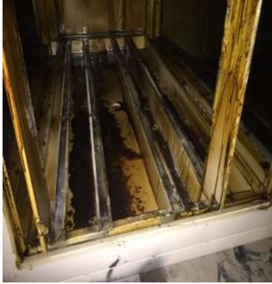
西厨房净化器内部清洗前
