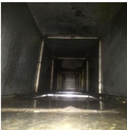
员工厨房管道清洗后
