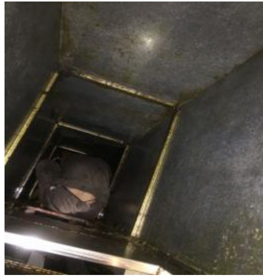
西厨房管道施工
