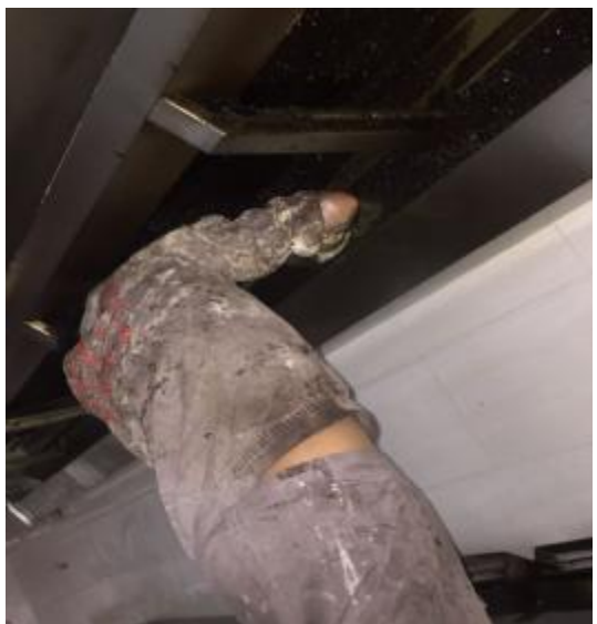
中厨房烟罩施工
