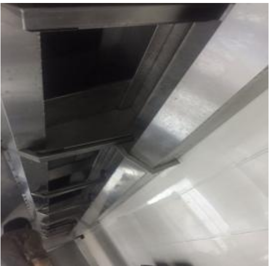
西厨房烟罩清洗后
