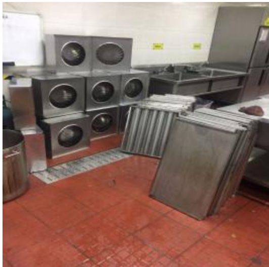
中厨房风扇清洗后
