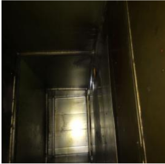
明档管道清洗前
