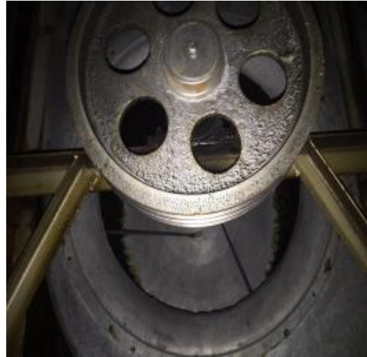
中厨房风机清洗后
