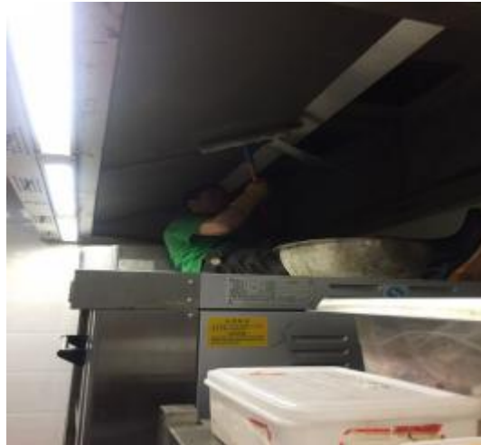
面点房烟罩施工
