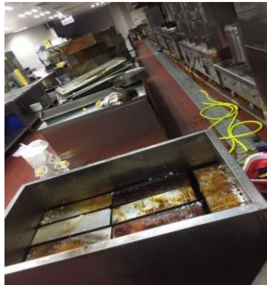
中厨房风扇清洗中
