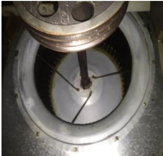
员工厨房风机清洗后
