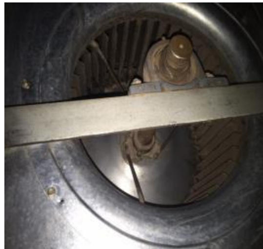
西厨房风机清洗后
