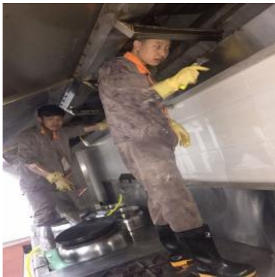
西厨房烟罩施工
