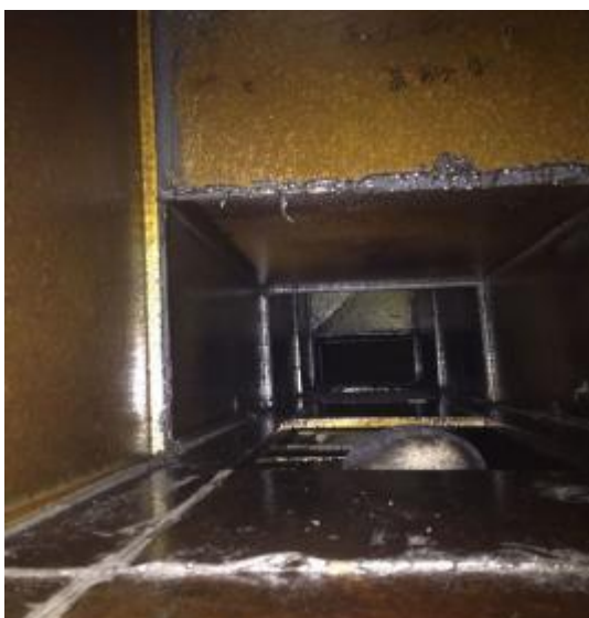
员工厨房管道清洗前
