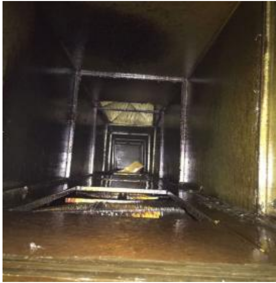
中厨房管道清洗前
