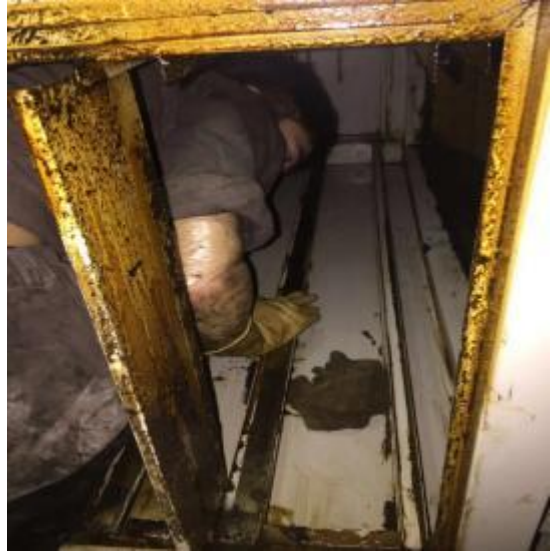
西厨房净化器施工
