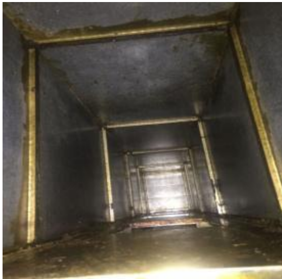
西厨房管道清洗后
