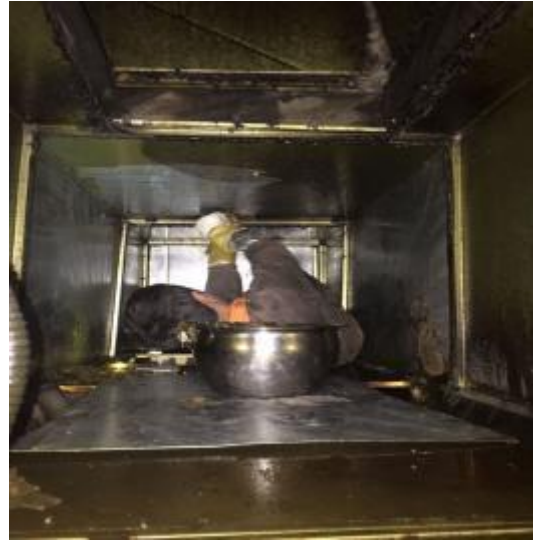
明档管道施工
