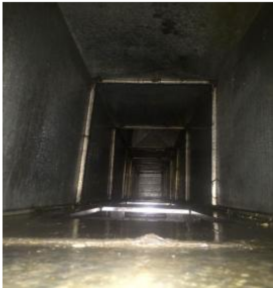
中厨房管道清洗后
