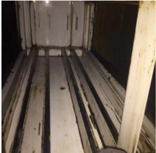
西厨房净化器内部清洗后
