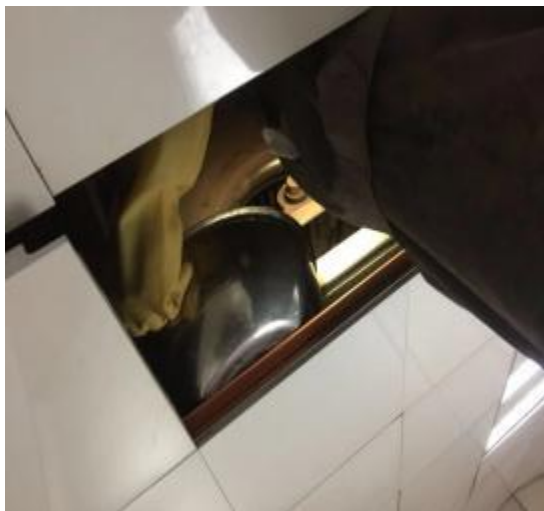
西厨房风机施工
