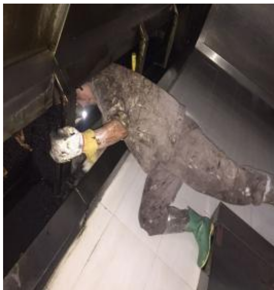
员工厨房烟罩施工中
