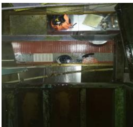
净化器机箱施工中
