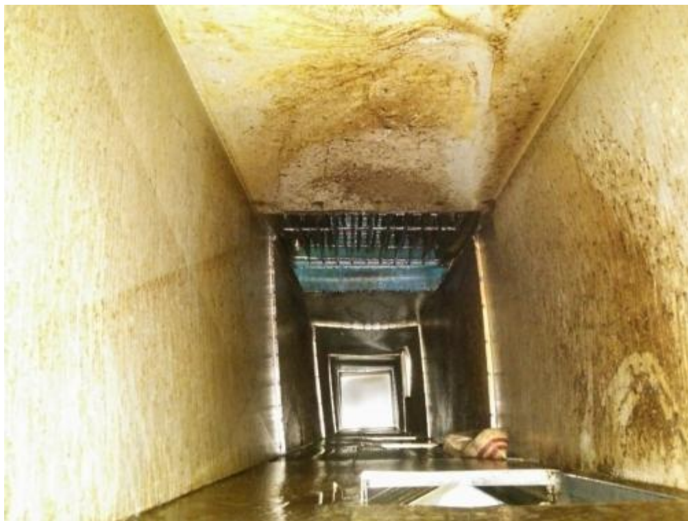
油烟内部管道清洗前
