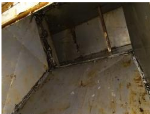
彭厨管道清洗后
