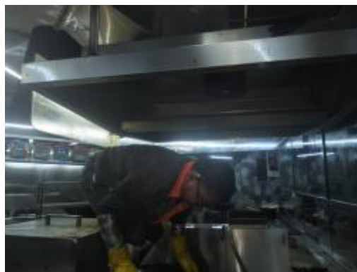
彭厨烟罩施工中
