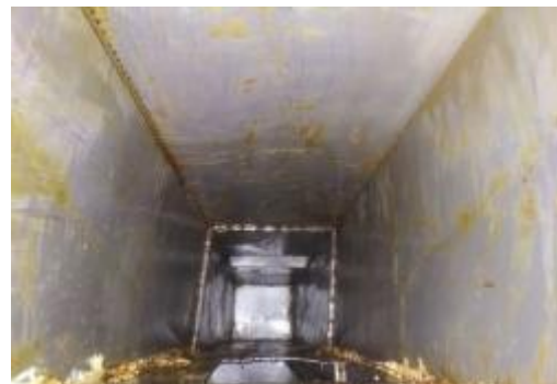
加州一号管道清洗后
