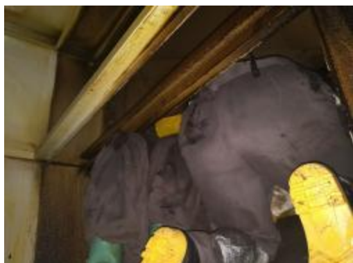
彭厨管道施工中
