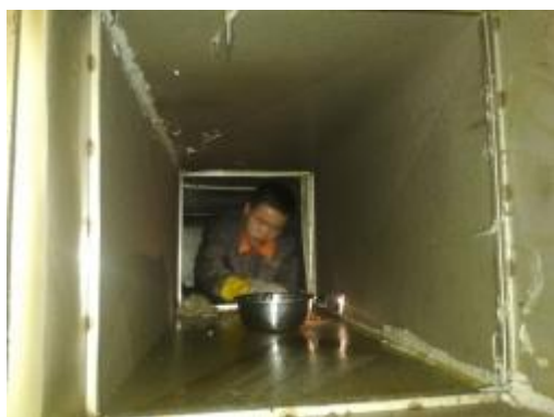
爱衣管道施工中
