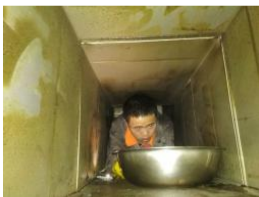
鼎云轩管道施工中
