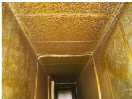
玛法小镇管道清洗前
