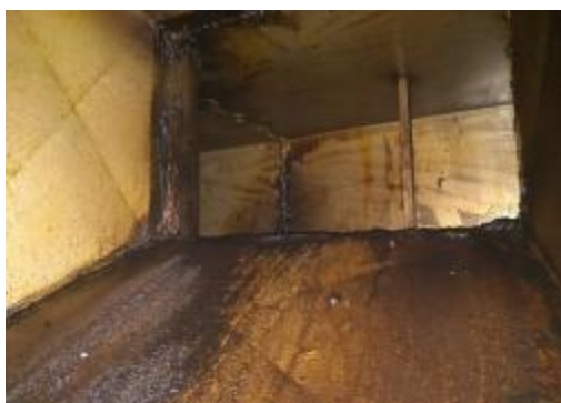
彭厨管道清洗前
