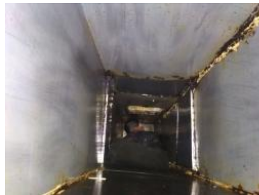
烤鸭管道清洗后
