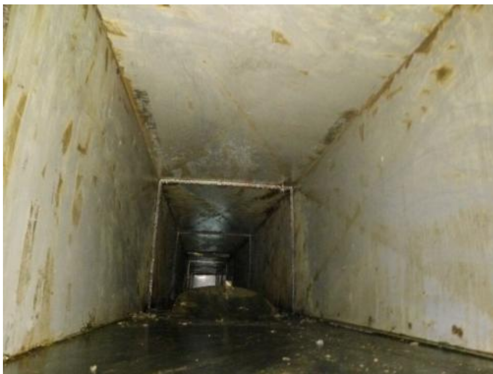
油烟内部管道清洗后
