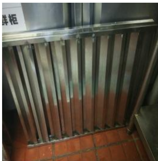
一品焖锅挡板清洗后
