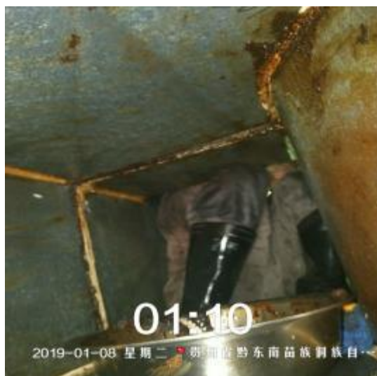
纯时光管道施工
