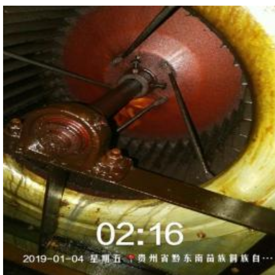
快活林风机清洗前
