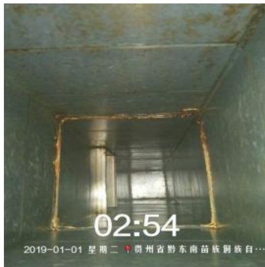
玛法小镇管道清洗后
