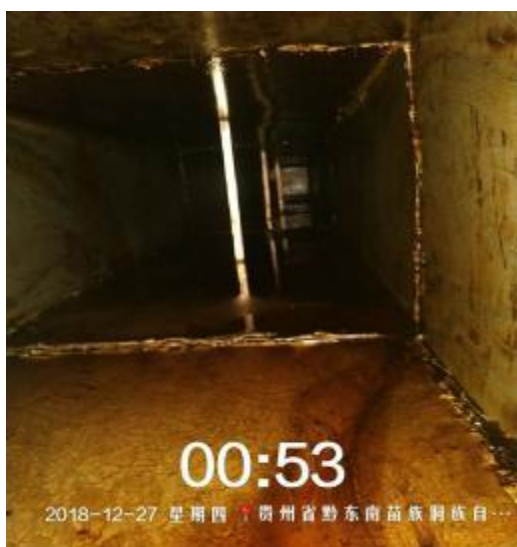
彭厨管道清洗前
