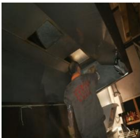
纯时光咖啡烟罩施工
