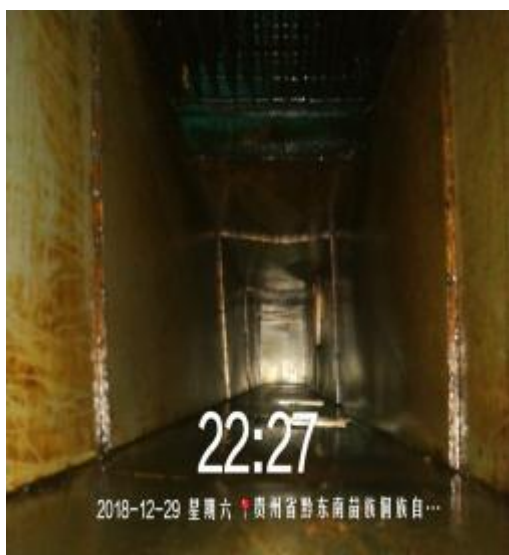
阿杜炒蟹管道清洗前
