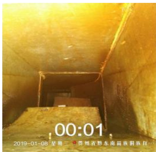
纯时光咖啡管道清洗前
