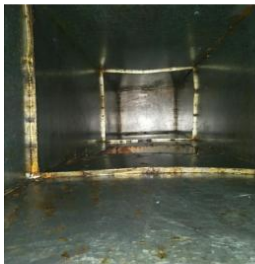
一品焖锅管道清洗后
