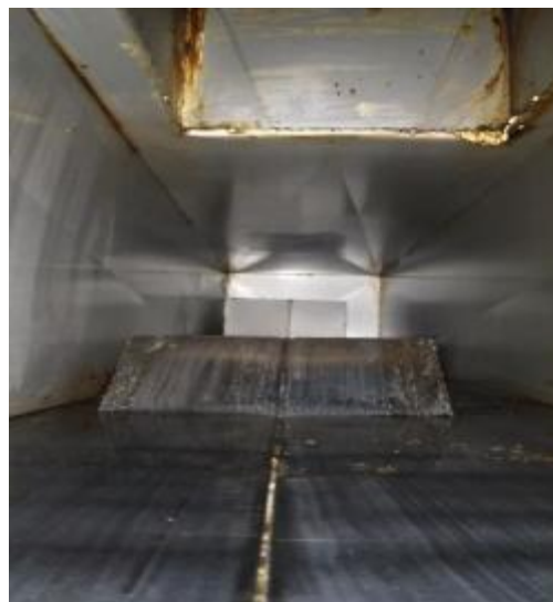
三线黔味管道清洗后
