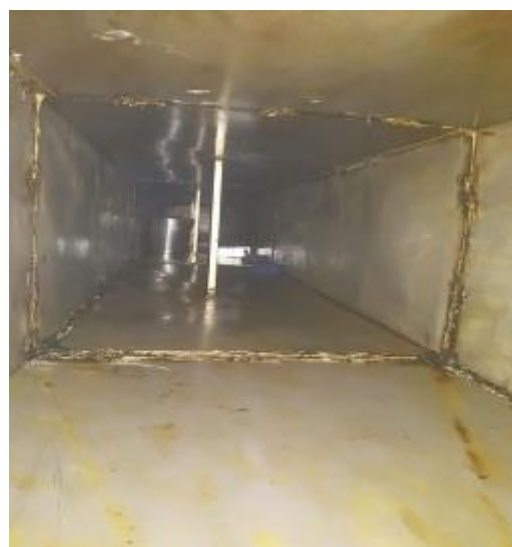
彭厨管道清洗后
