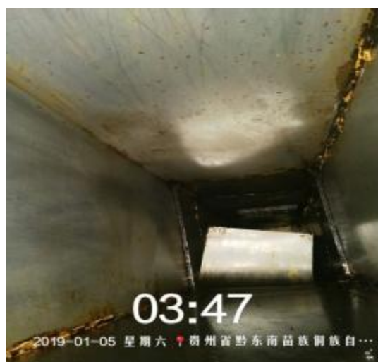
沅鼎阁管道清洗后
