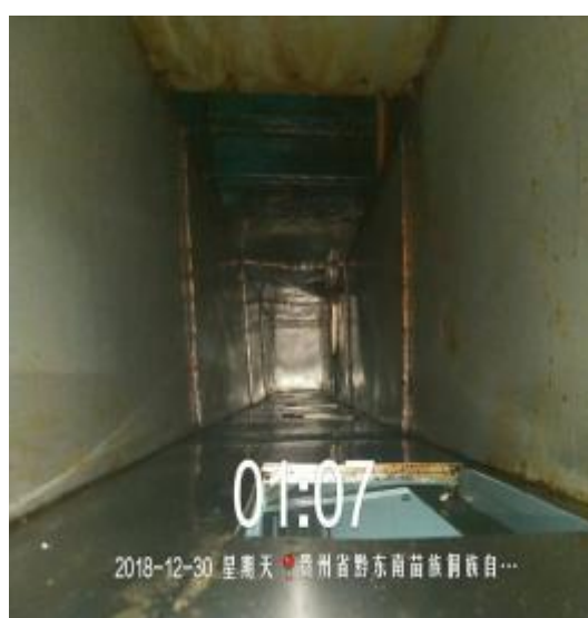
阿杜炒蟹管道清洗后
