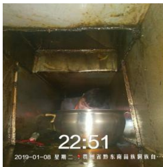
鸡本煮意管道施工
