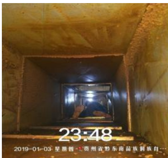
快活林管道清洗前
