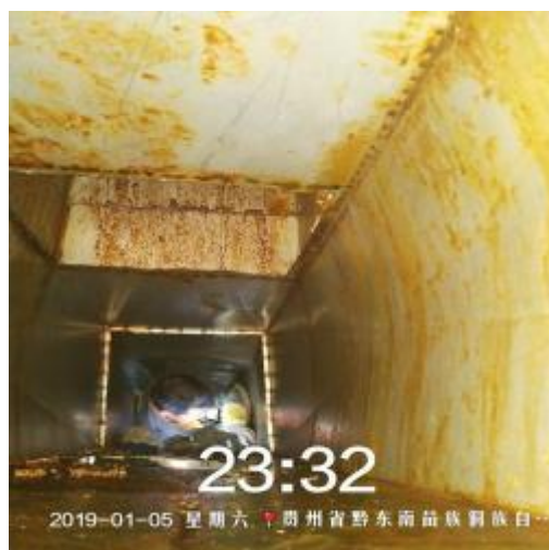
加州一号管道施工中
