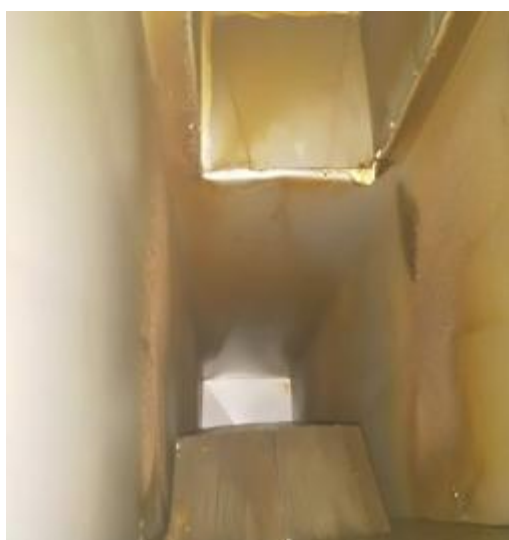
三线黔味管道清洗前
