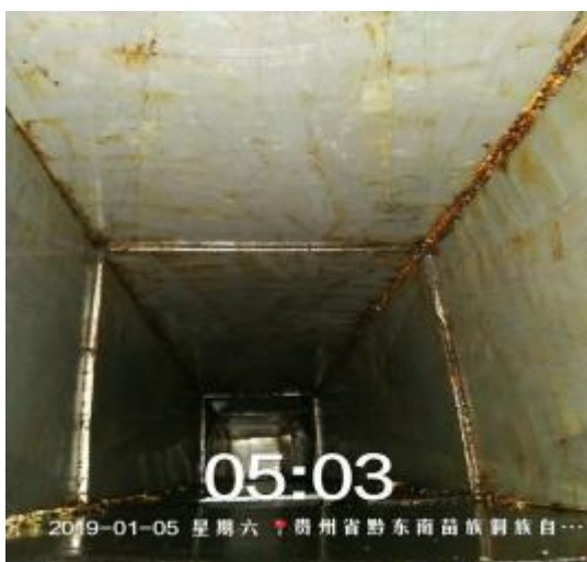
熊猫烤鱼管道清洗后
