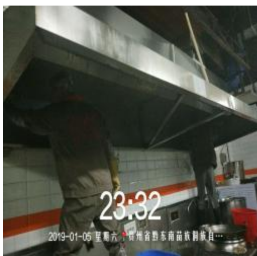
加州一号烟罩施工中
