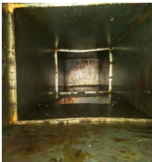
一品焖锅管道清洗前
