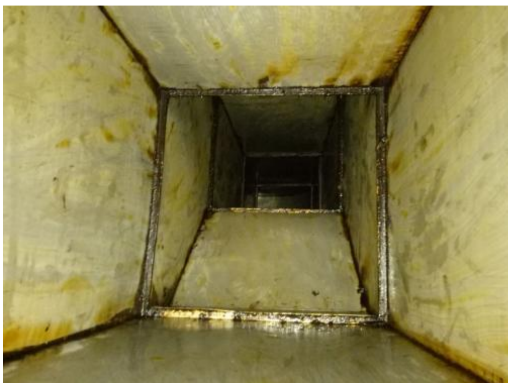
油烟内部管道清洗后
