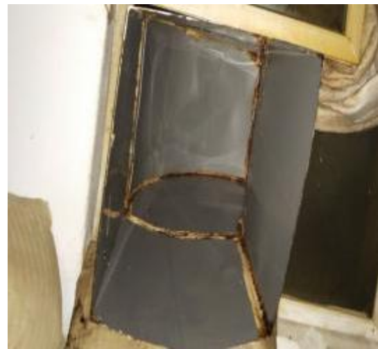
出风口管道清洗后 2
