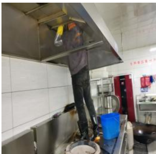
烟罩施工风中
