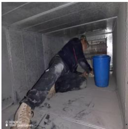
洗衣房管道清洗中
