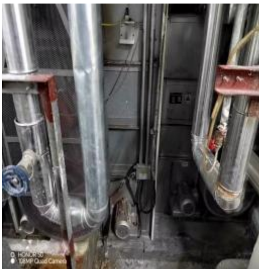
洗衣房管道外观清洗后
