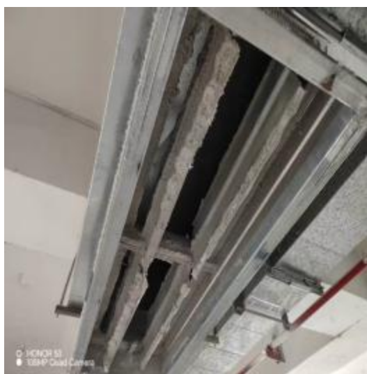
洗衣房管道清洗中
