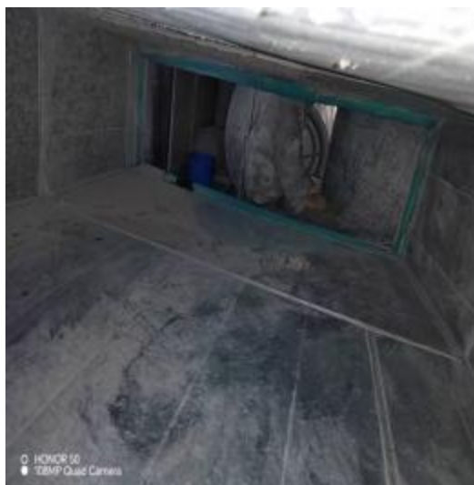
洗衣房风机清洗中
