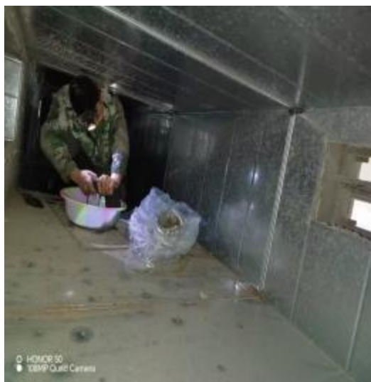
洗衣房管道清洗中
