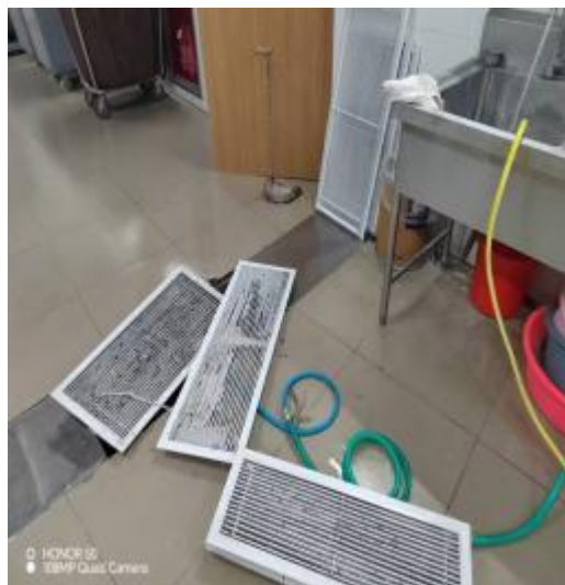
管道出风口清洗后
