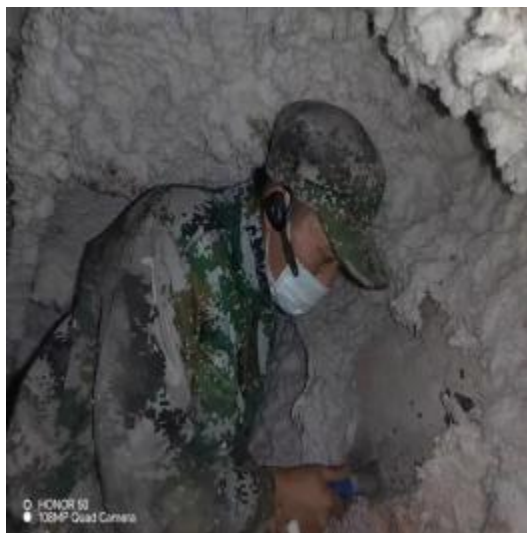
洗衣房管道清洗中
