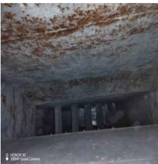
洗衣房管道清洗后
