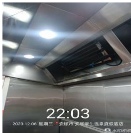
烧腊厨房管道清洗后
