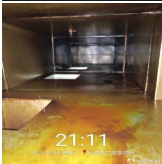
员工厨房管道清洗前
