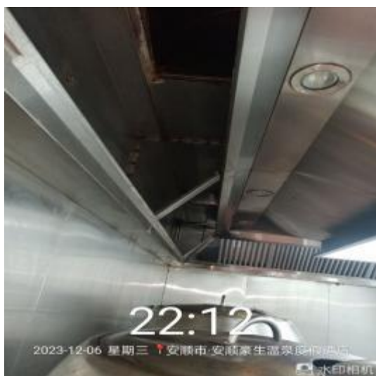
烧腊房管道清洗前
