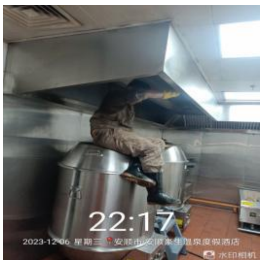
烧腊厨房烟罩清洗中
