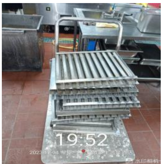
员工厨房防火板清洗前
