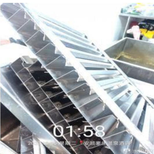
员工厨房防火板清洗后
