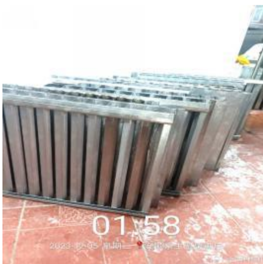
员工厨房防火板清洗后
