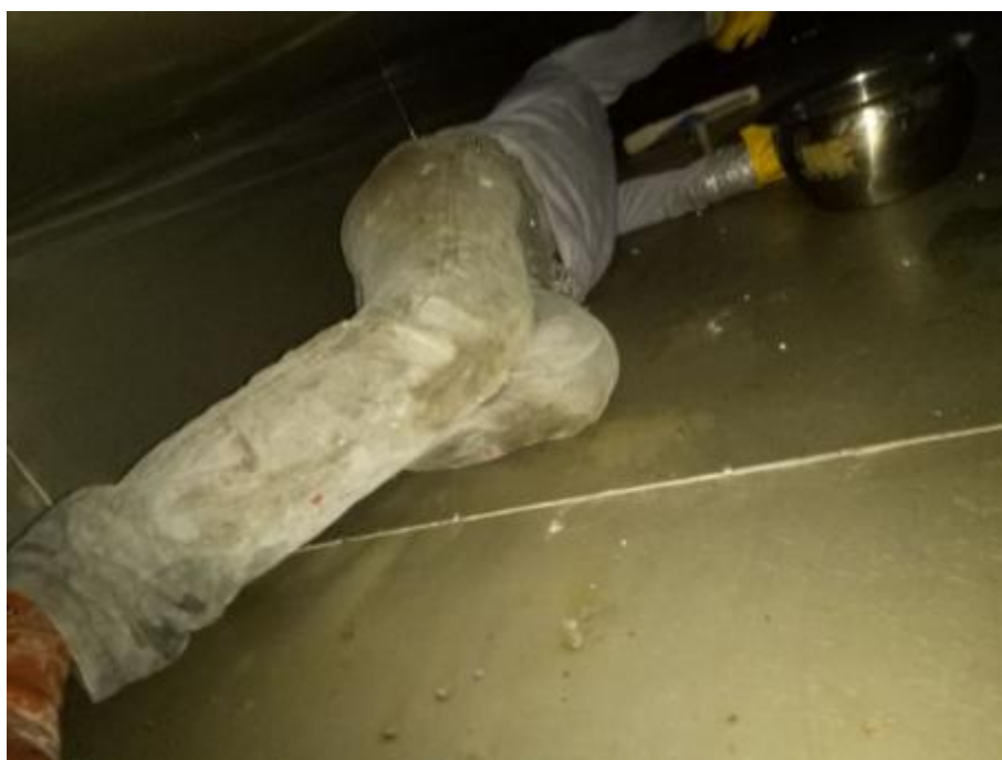
员工厨房出风口施工中
