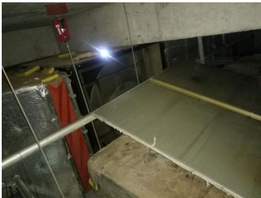
员工厨房风机施工中
