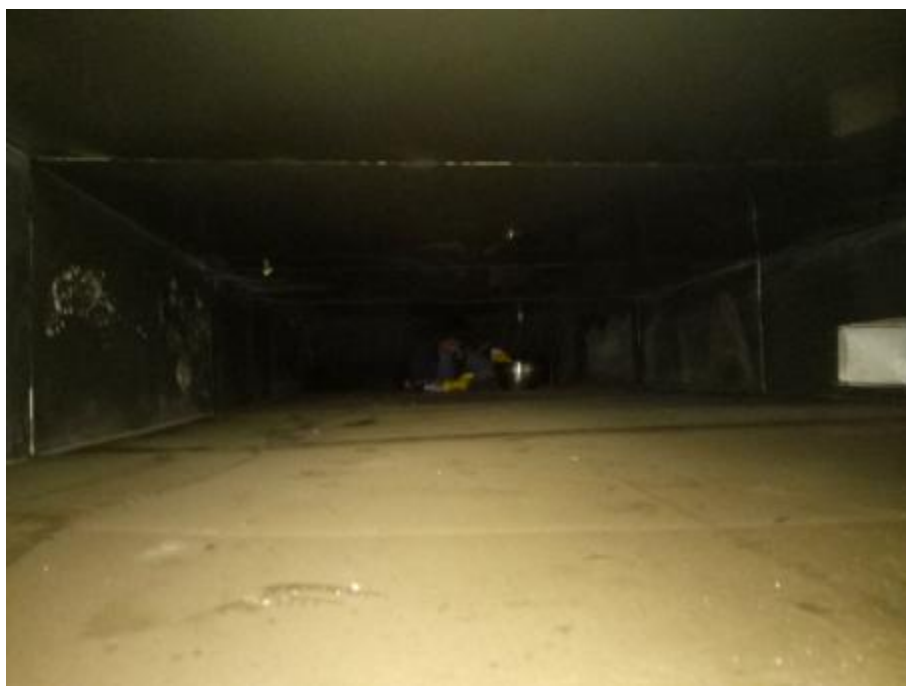
烧烤房主管道清洗前
