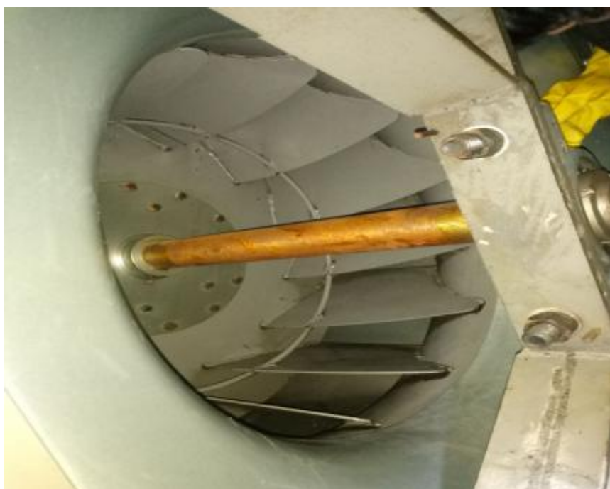
抽风机清洗后
