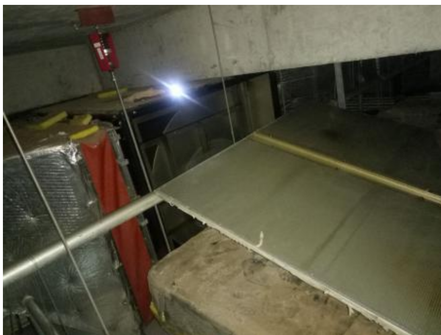
员工厨房风机施工中
