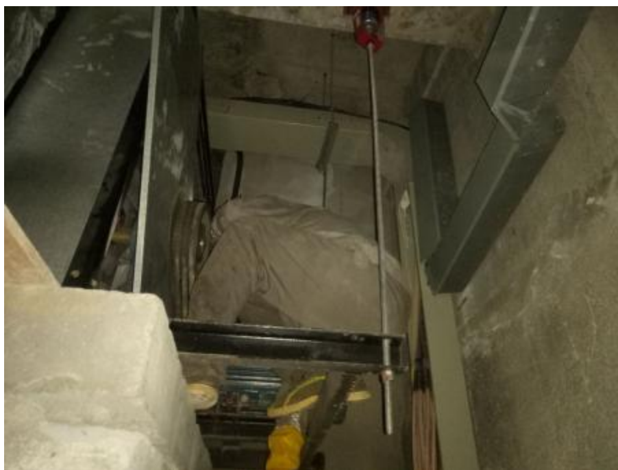
明档风机施工中 3
