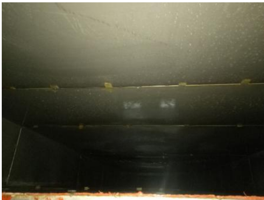
烧烤房主管道清洗后
