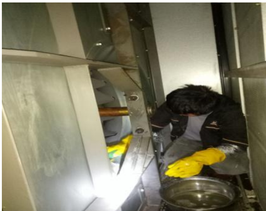
西厨房风机施工中
