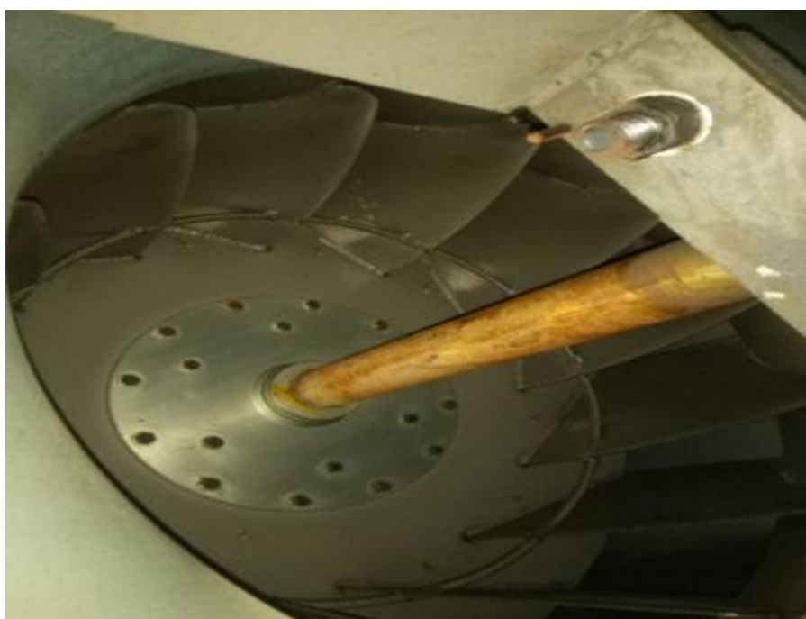
西厨房风机清洗前
