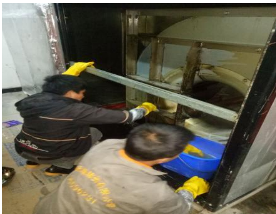
中厨房风机施工中
