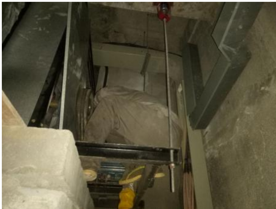
明档风机施工中
