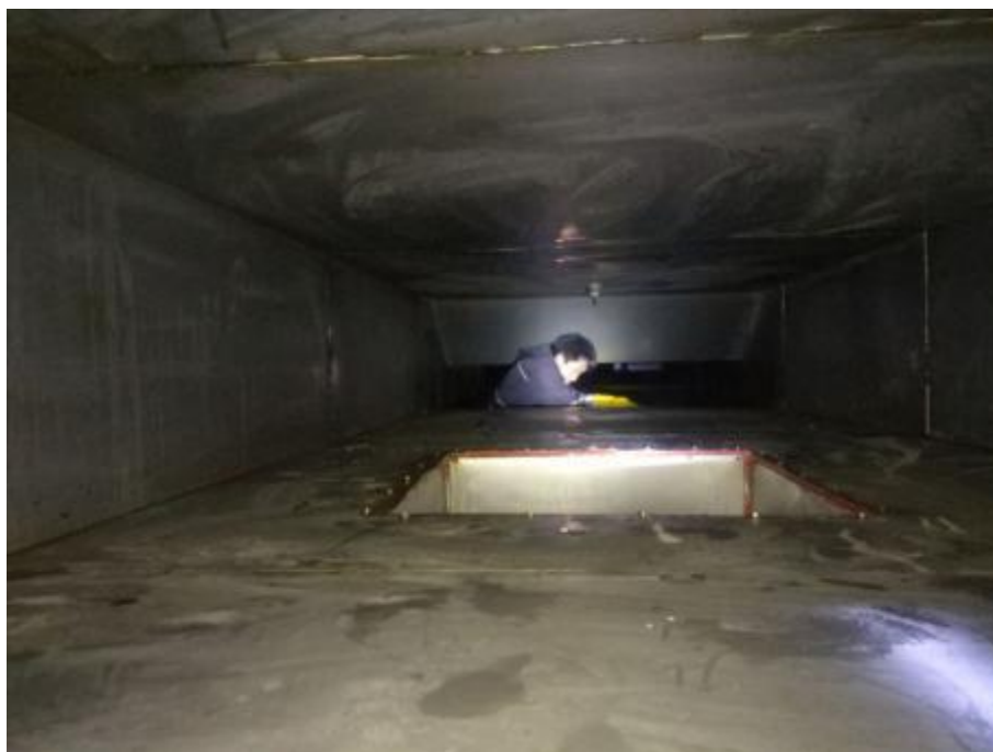
西厨房主管道清洗后
