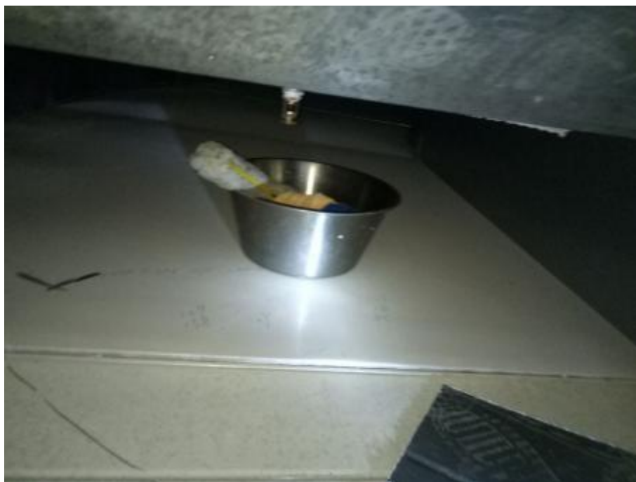
烧腊房出风口清洗后
