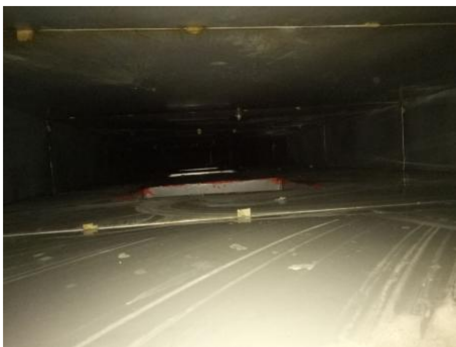
中厨房主管道清洗后
