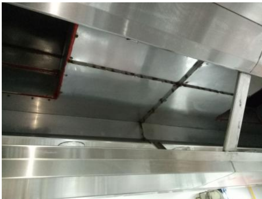
西厨房烟罩清洗后
