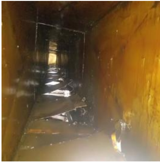
一楼管道清洗前 1
