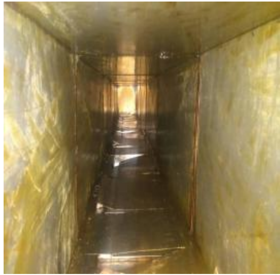
一楼管道清洗后
