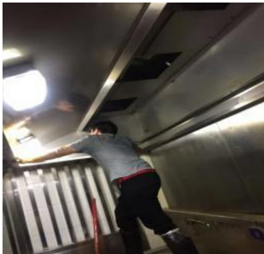
二楼烟罩施工
