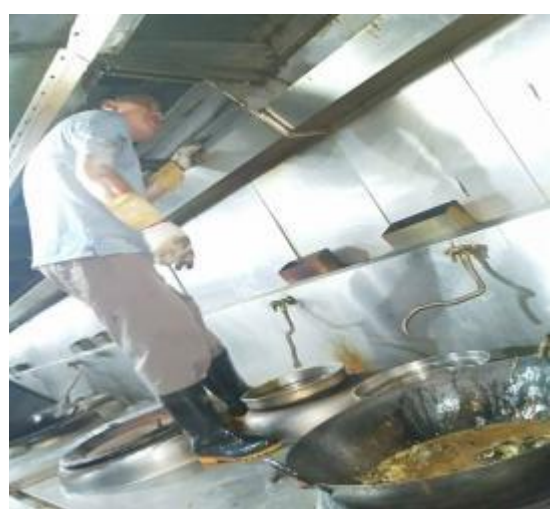
一楼烟罩施工 2
