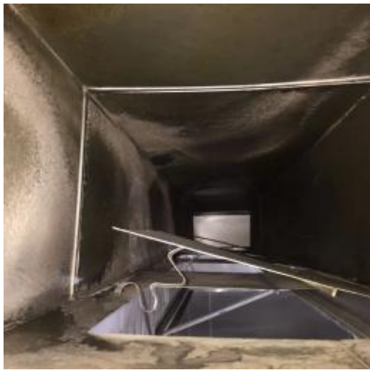
二楼管道清洗前
