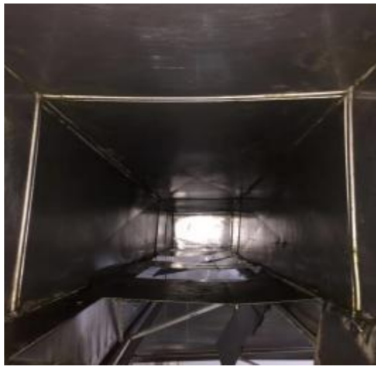
二楼管道清洗后
