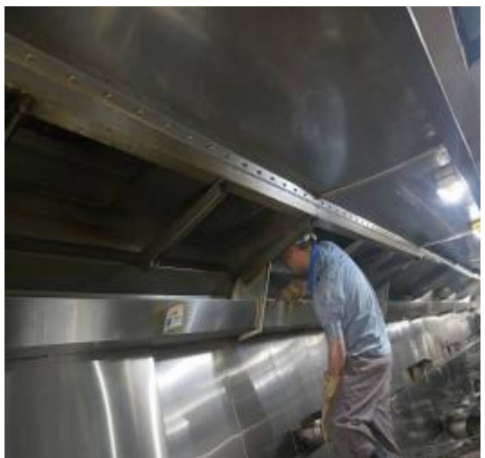
一楼烟罩施工 1
