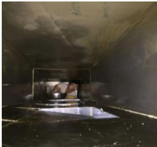
二楼管道施工
