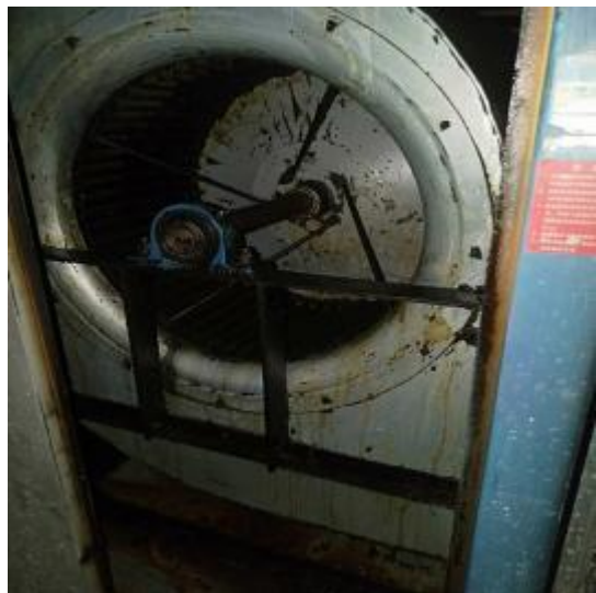
一楼风机清洗后 1
