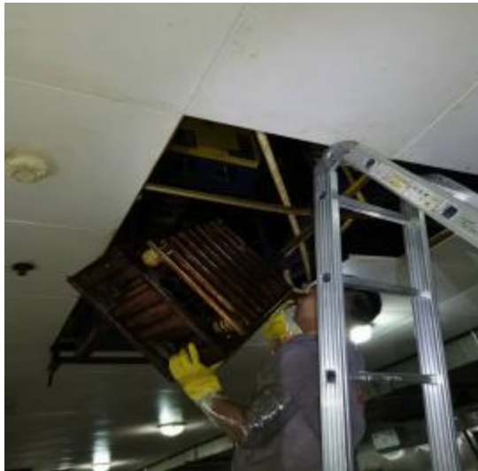
净化器施工中
