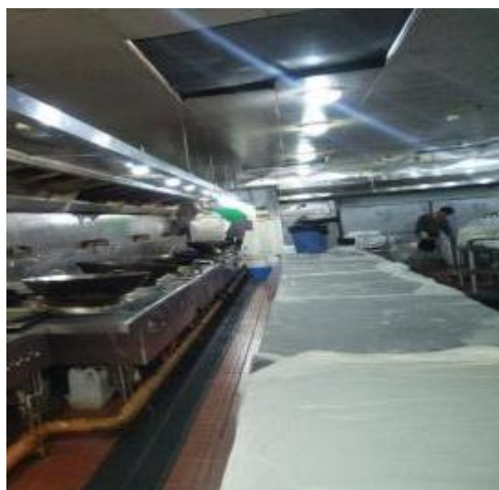
一楼烟罩施工中 2
