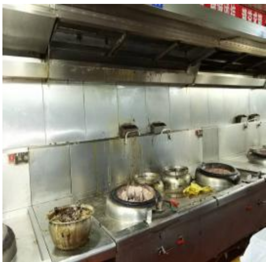
一楼烟罩施工中 1
