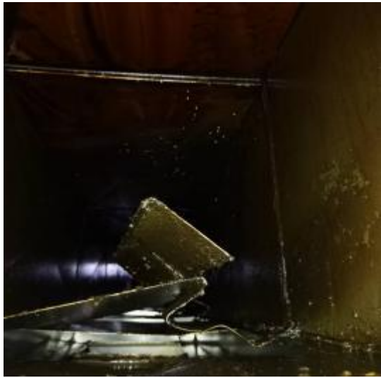
一楼管道清洗前
