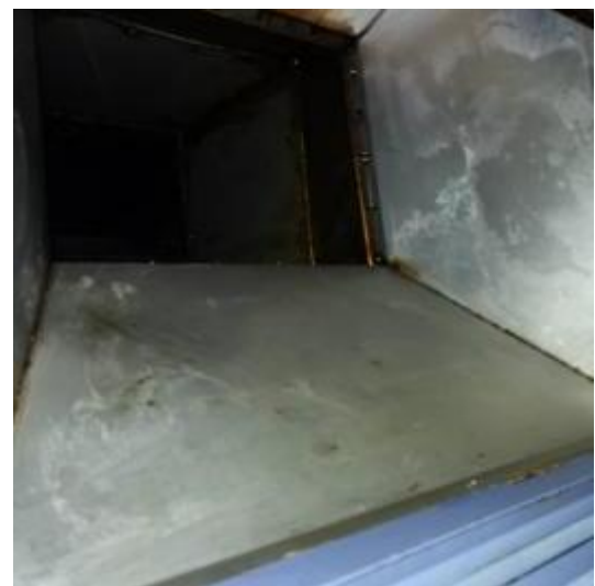
管道风机清洗后
