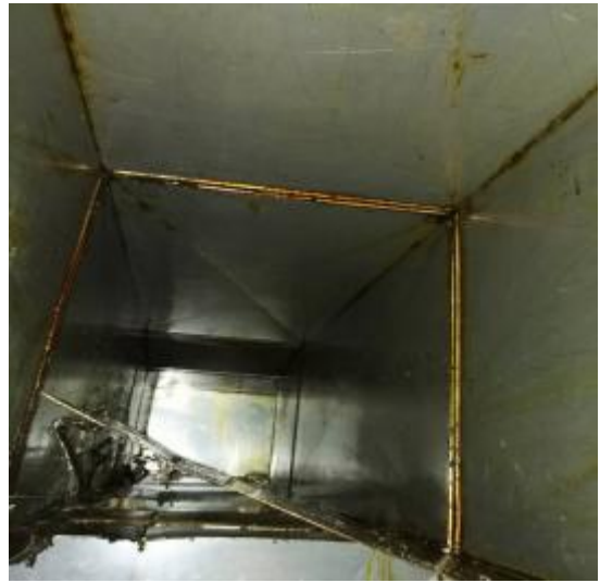
一楼管道清洗后
