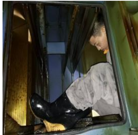
净化器机箱施工中
