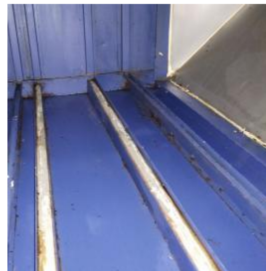
一楼净化器内部清洗后
