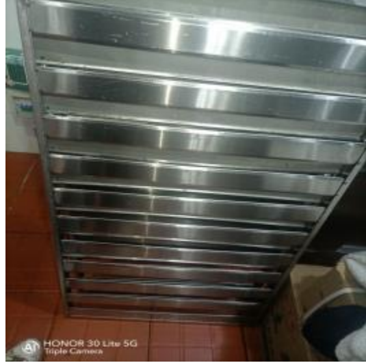
二楼防火板清洗后
