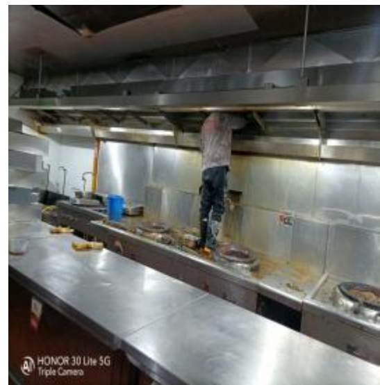
一楼烟罩施工 2
