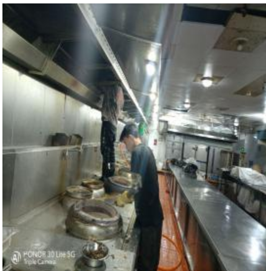
一楼烟罩施工 1
