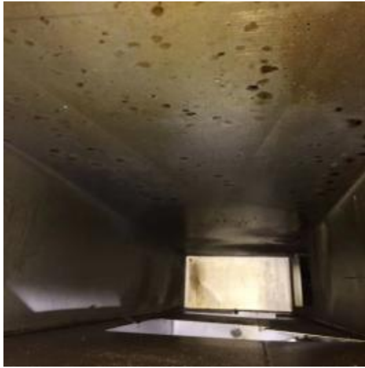
一楼管道清洗前 1
