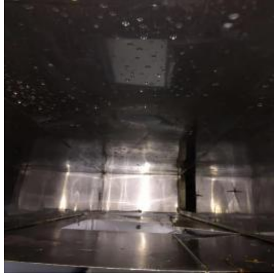
一楼管道清洗后
