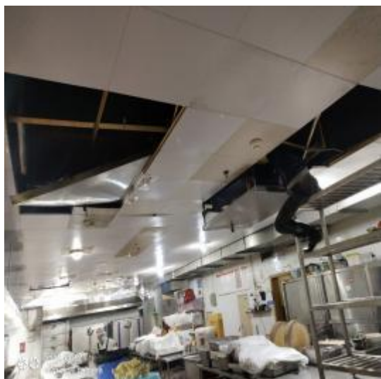
一风机及净化器施工
