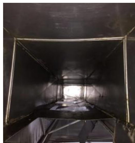
二楼管道清洗后
