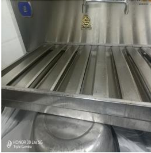
二楼防火板清洗前
