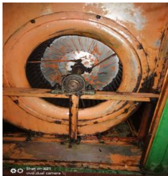
一楼风机清洗后 1
