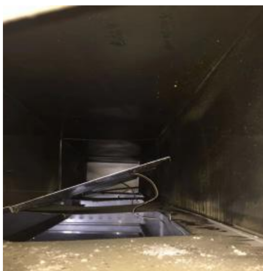
二楼管道清洗前
