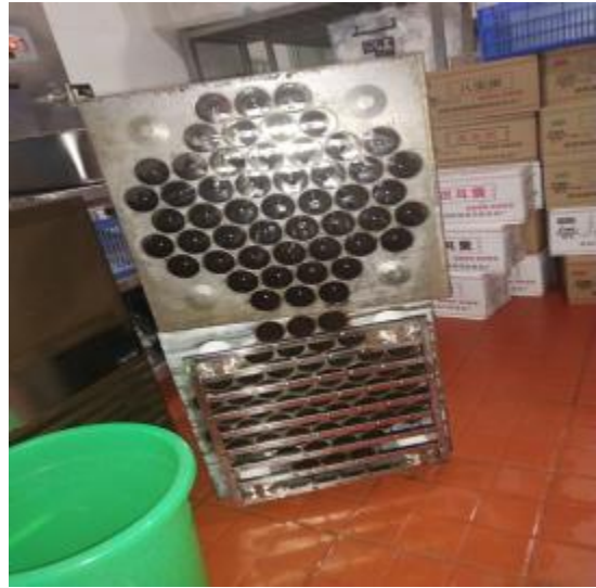
一楼净化器清洗后
