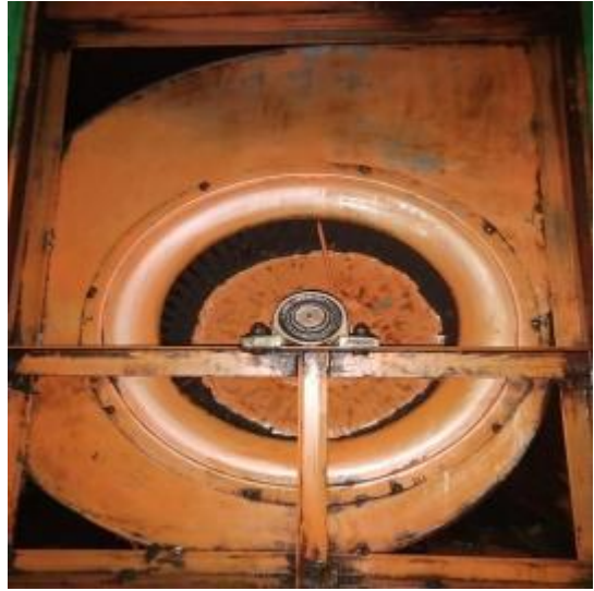
一楼风机清洗后
