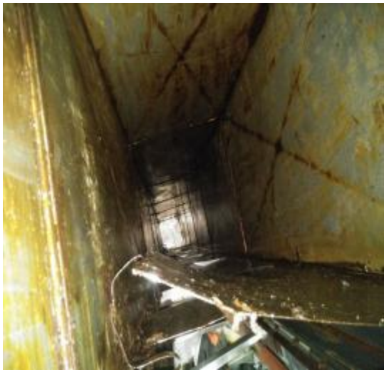
一楼管道清洗后
