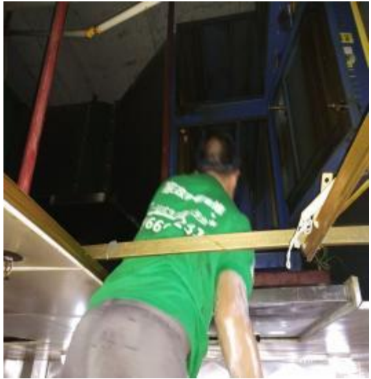
净化器内部施工
