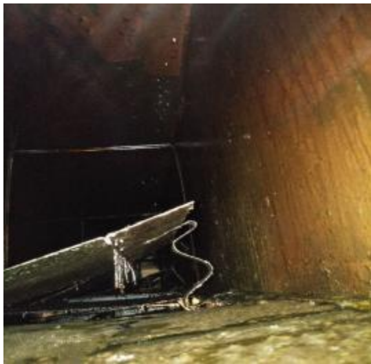
一楼管道清洗前
