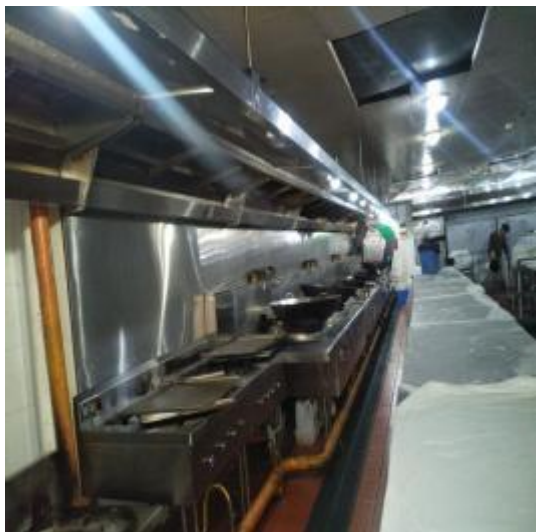
一楼烟罩施工
