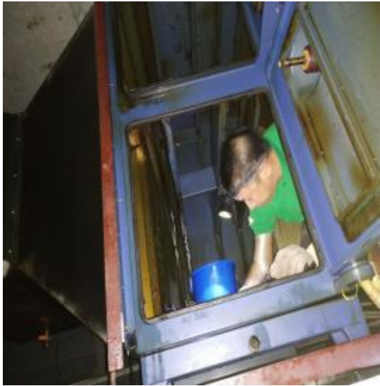
净化器内部施工
