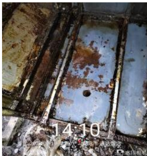
机器机箱清洗后
