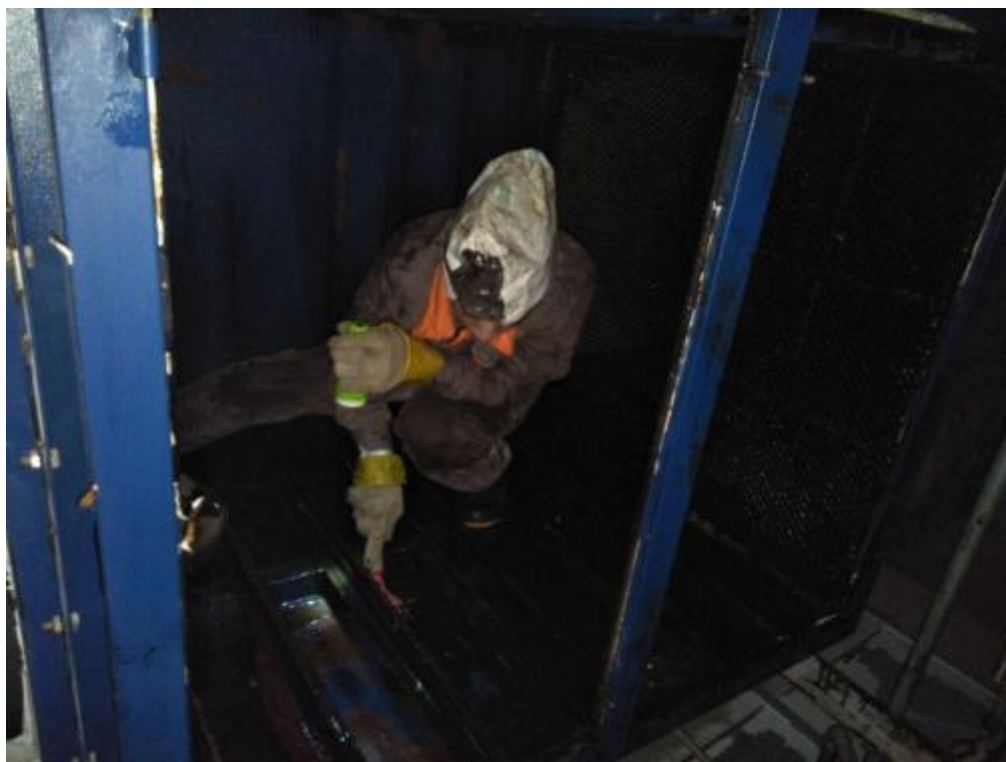
净化器内部施工
