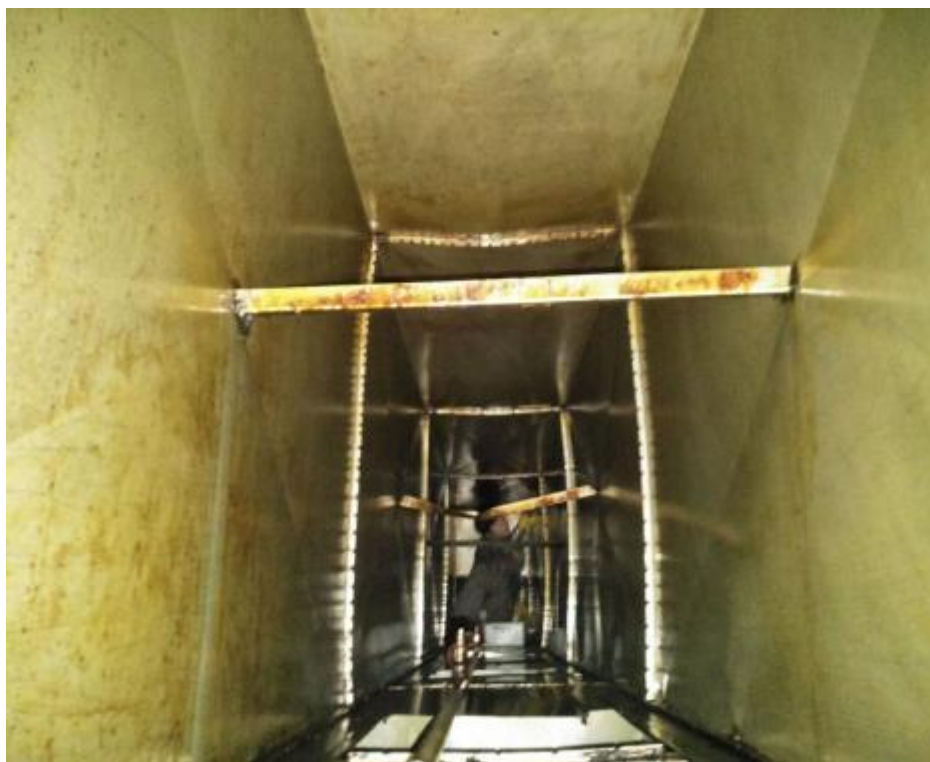
中厨房管道清洗前
