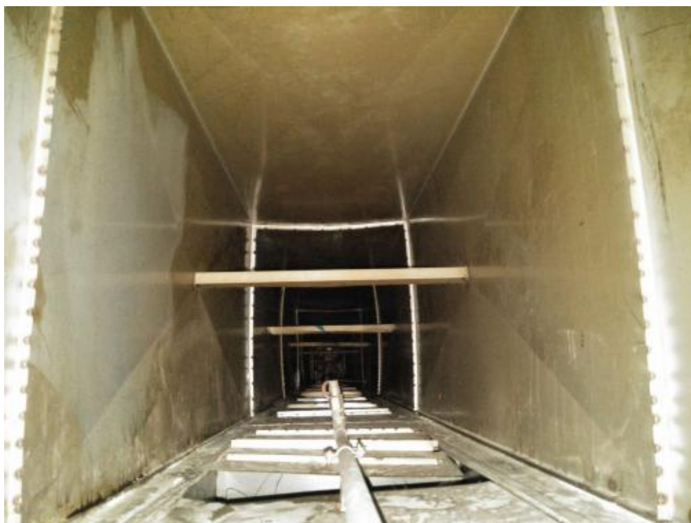
烧腊房管道清洗前
