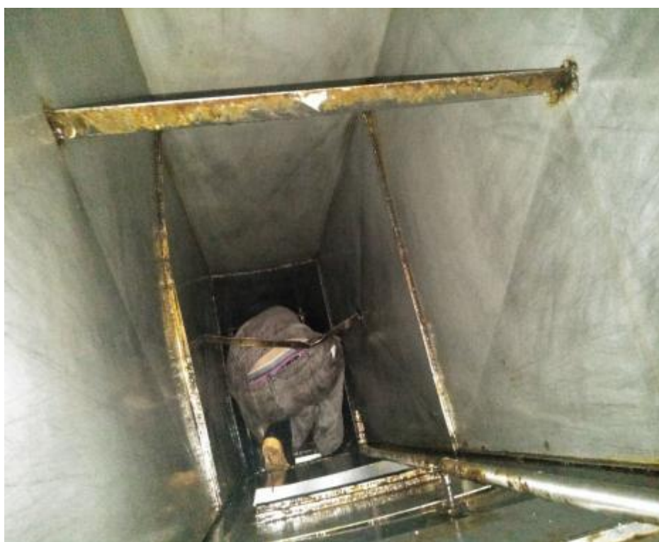
中厨房管道施工中
