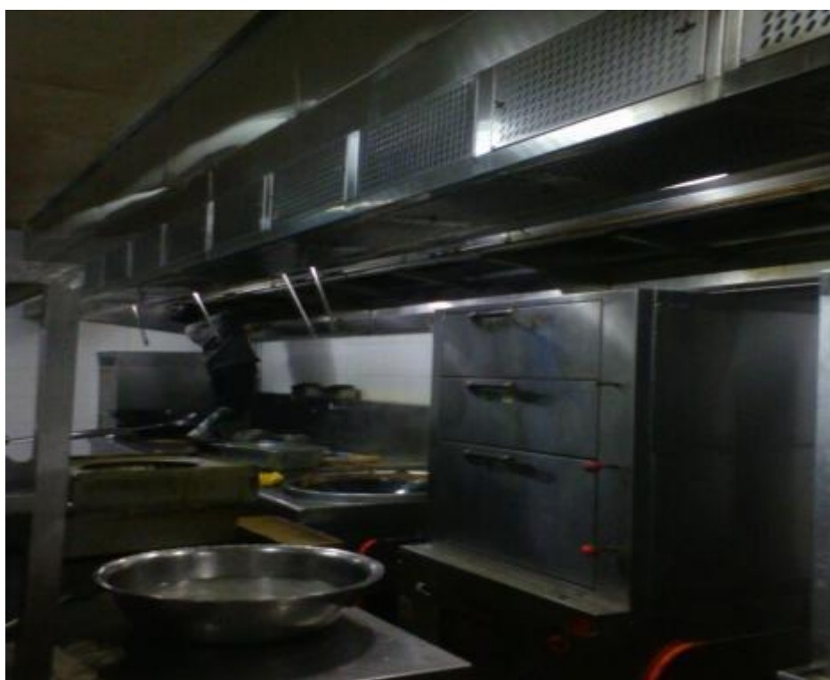
员工厨房烟罩施工中
