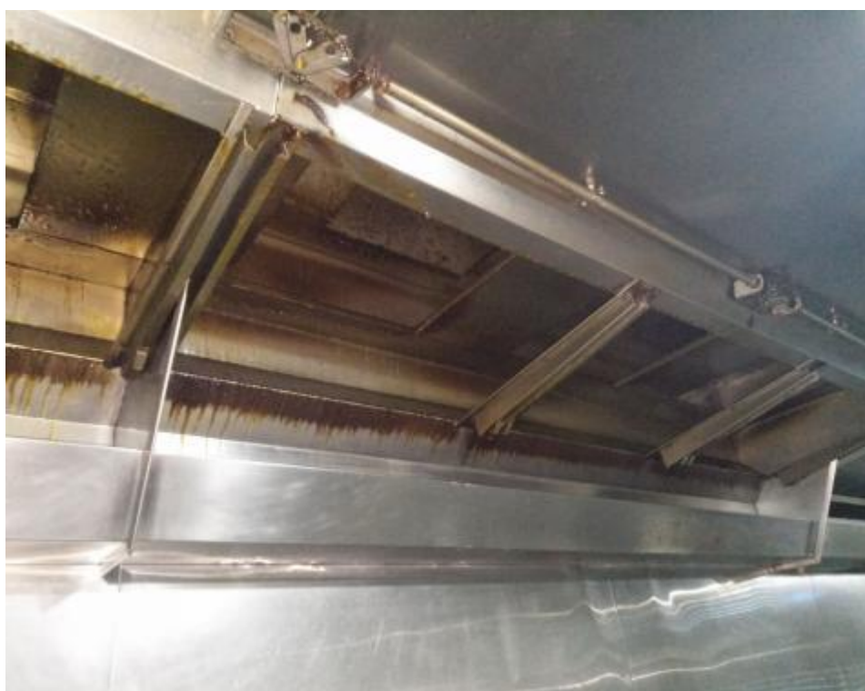
中厨房烟罩清洗前
