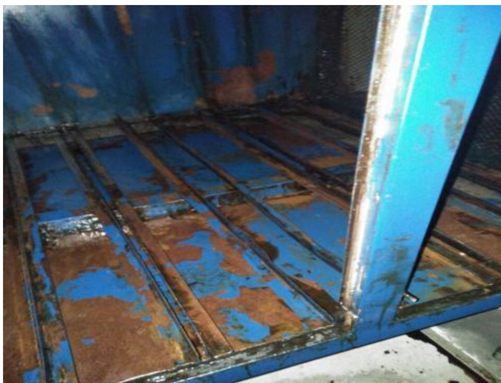
净化器内部清洗后
