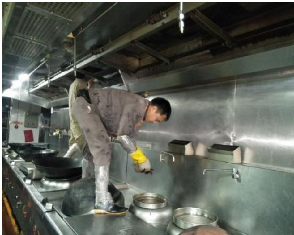
中厨房烟罩施工中
