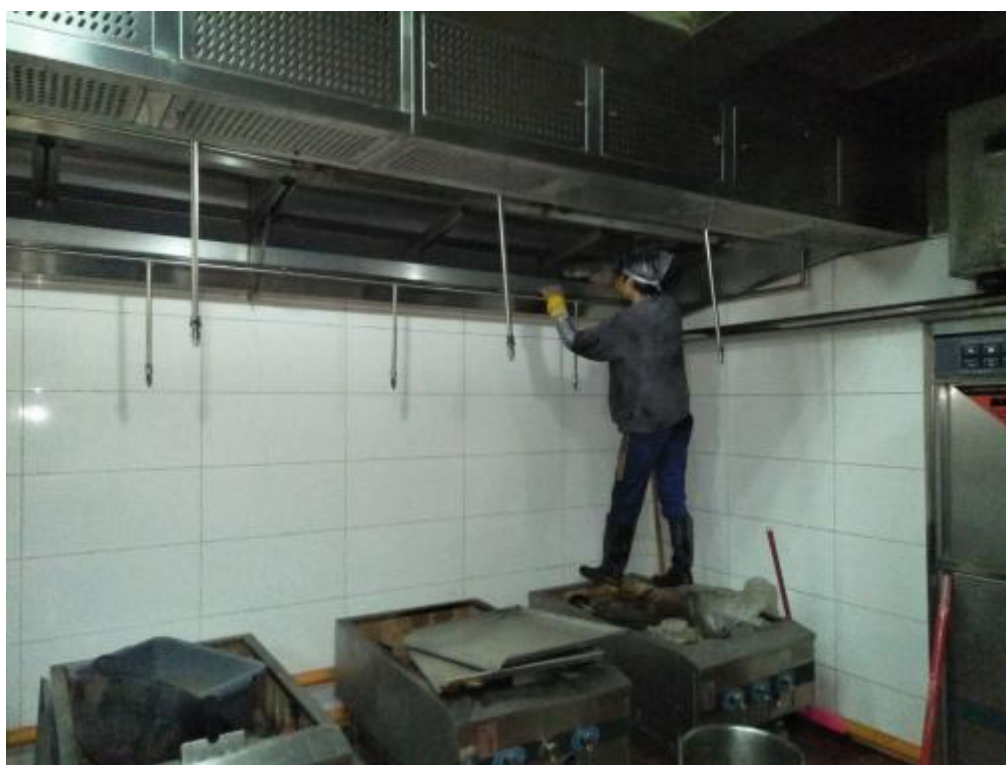
烧腊房烟罩施工中
