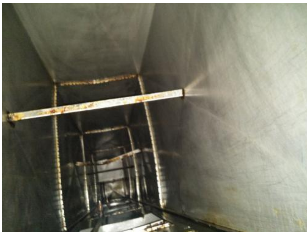
中厨房管道清洗后
