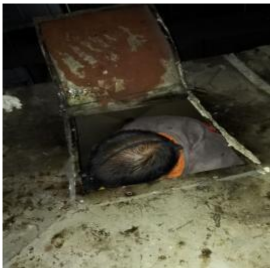
主管道施工中
