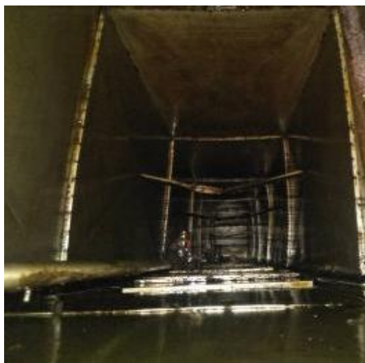
中厨房管道清洗前
