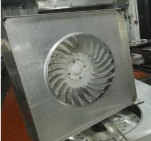
西厨房风扇清洗后
