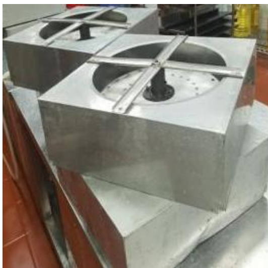
中厨房风扇清洗后
