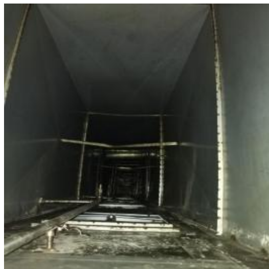
中厨房管道清洗后
