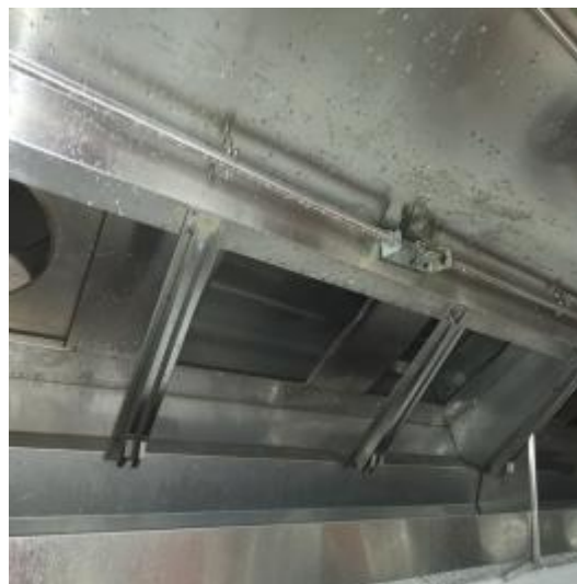
西厨房烟罩清洗后
