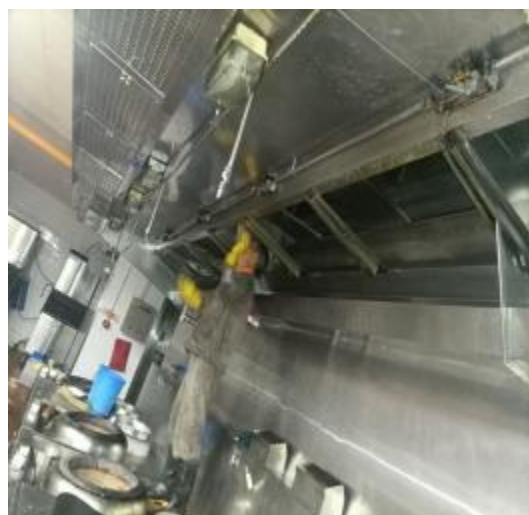
员工厨房烟罩施工
