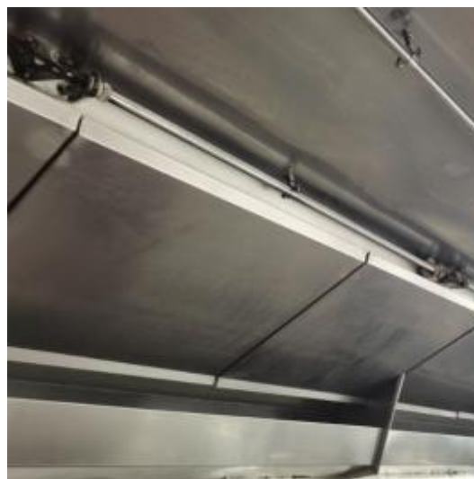
西厨房烟罩清洗后
