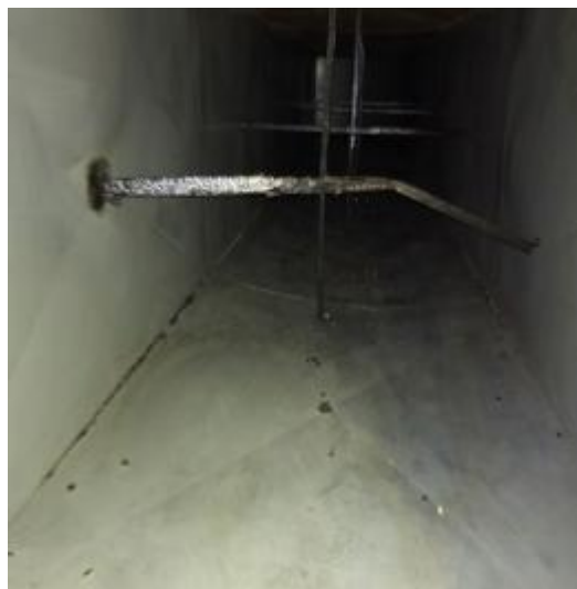
主管道清洗后
