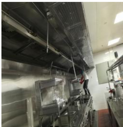
现场卫生打扫中
