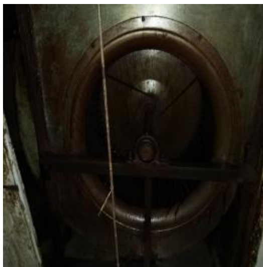
西厨房风机清洗前
