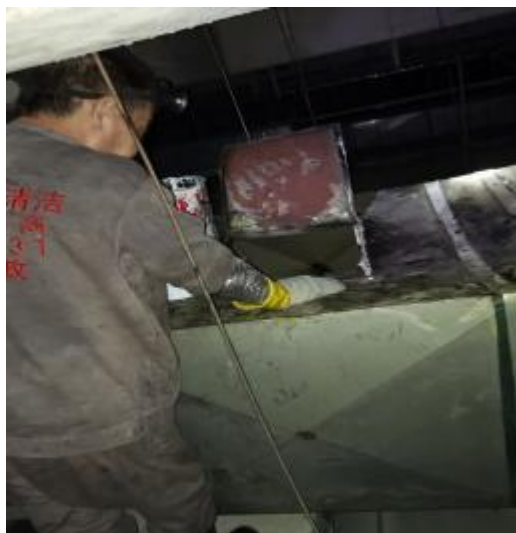
主管道施工中
