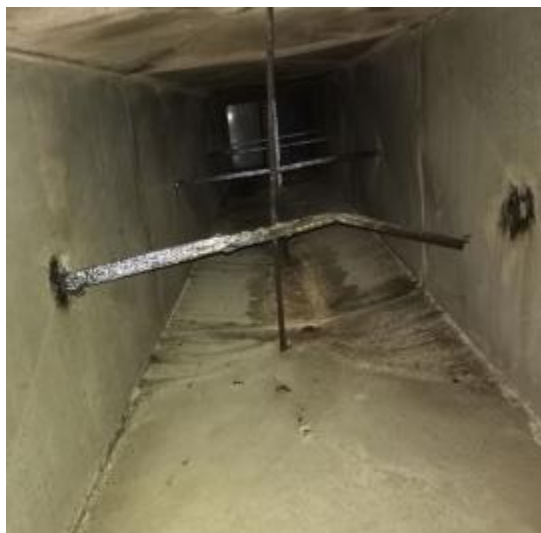
主管道清洗前
