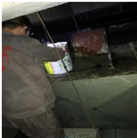
中厨房管道施工中
