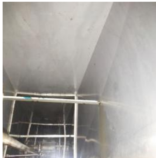
烧腊房管道清洗后
