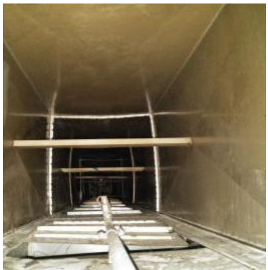
烧腊房管道清洗前
