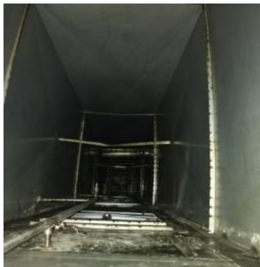
西厨房管道清洗后
