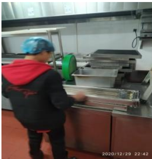
西厨房灯管施工
