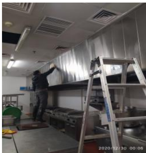
西厨房烟罩施工
