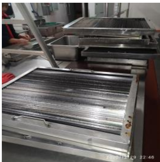
西厨房防火板清洗前
