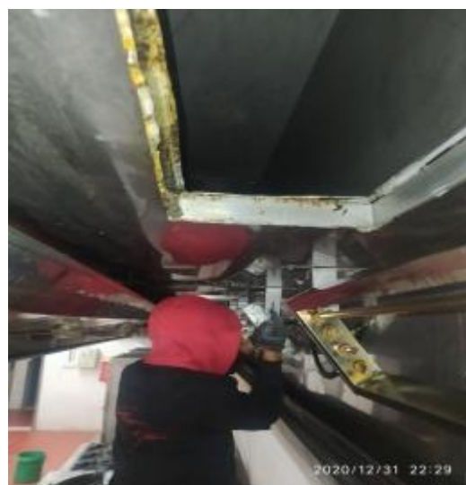
中厨房烟罩施工
