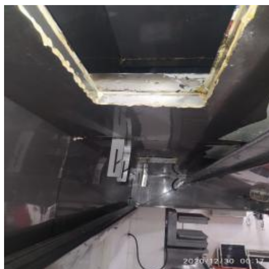
西厨房烟罩清洗后
