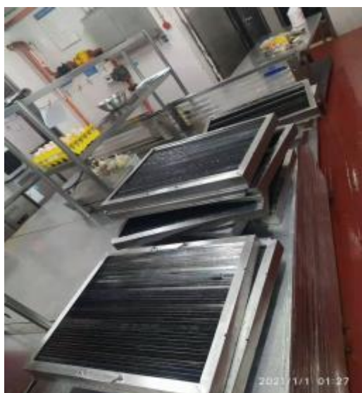
中厨房防火板清洗前
