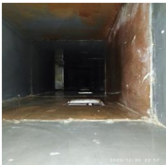
宴会厨房管道清洗前
