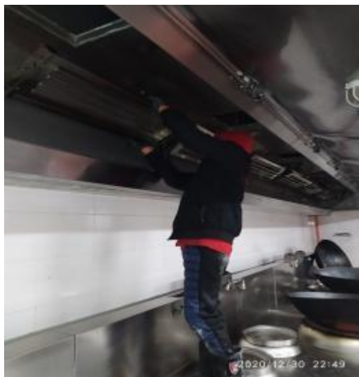
宴会厨房烟罩施工 1
