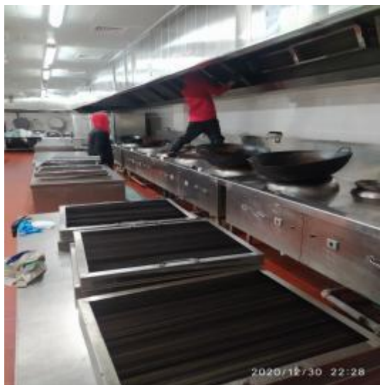
宴会厨房防火板清洗前
