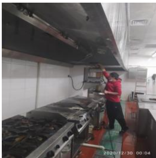
西厨房烟罩施工
