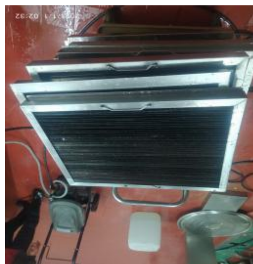
员工厨房防火板清洗后
