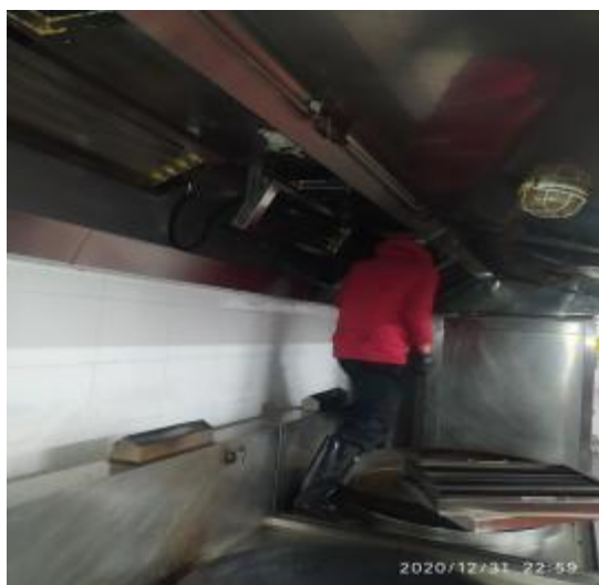
员工厨房烟罩施工
