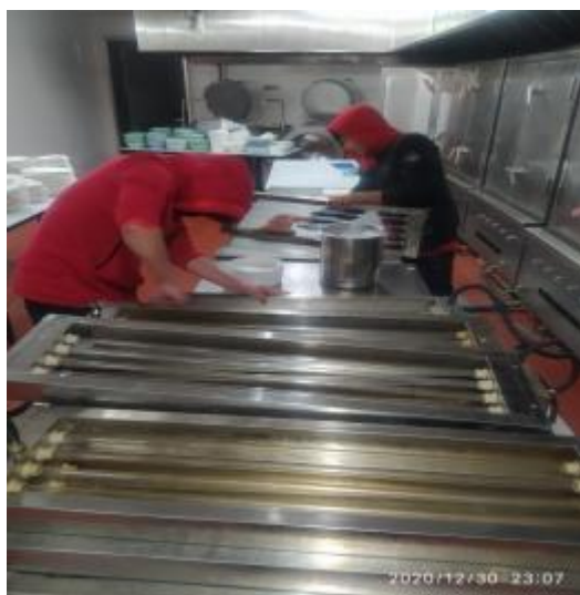
宴会厨房灯管施工
