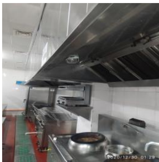
宴会厨房烟罩清洗后
