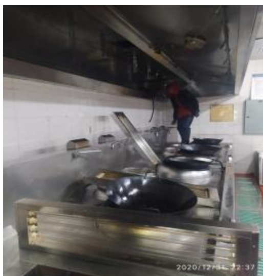
中厨房烟罩施工
