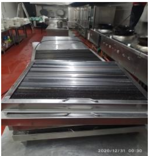
宴会厨房防火板清洗后
