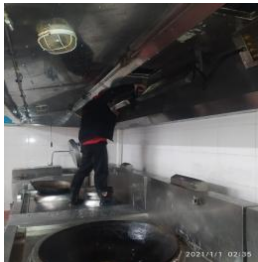
员工厨房烟罩施工
