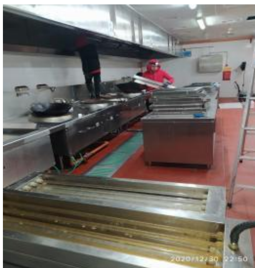
宴会厨房烟罩施工 2
