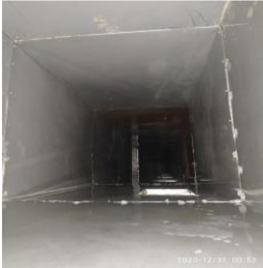
宴会厨房管道清洗后
