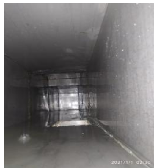
员工厨房管道清洗后
