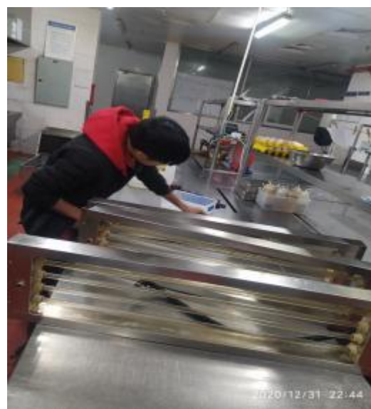
员工厨房灯管施工
