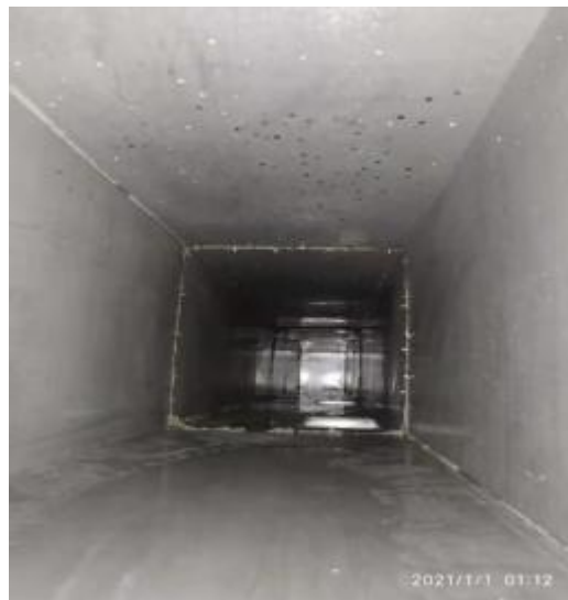
中厨房管道清洗后
