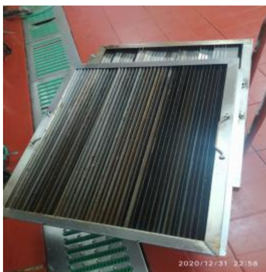
员工厨房防火板清洗前
