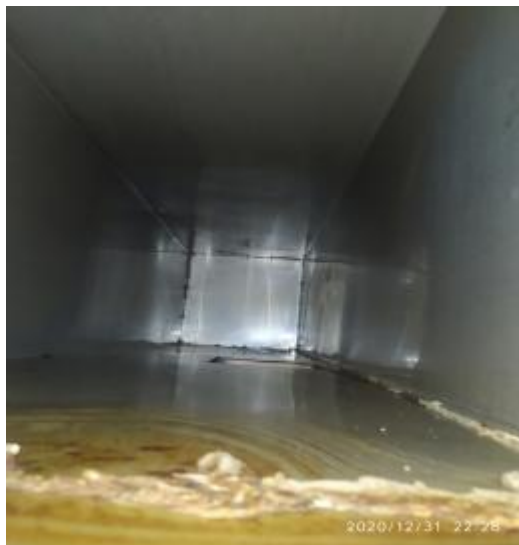
中厨房管道清洗前
