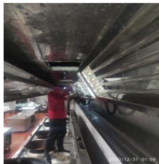
宴会厨房灯管清洗后
