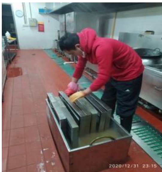
员工厨房防火板清洗中
