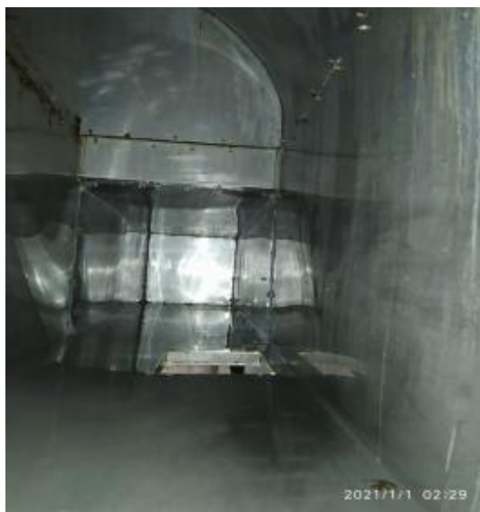
员工厨房管道清洗前
