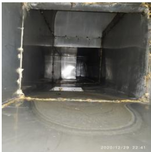
西厨房管道清洗前
