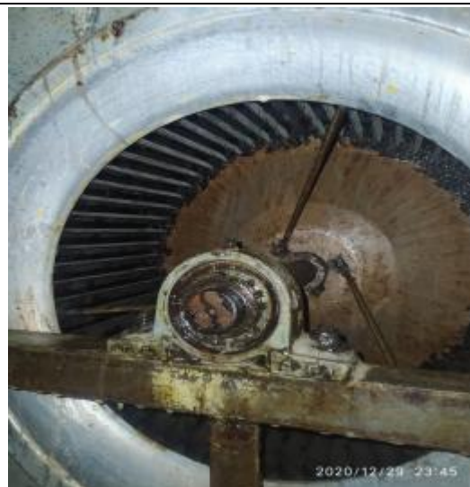
西厨房风机清洗后
