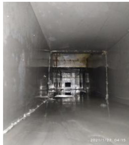
员工厨房管道清洗后
