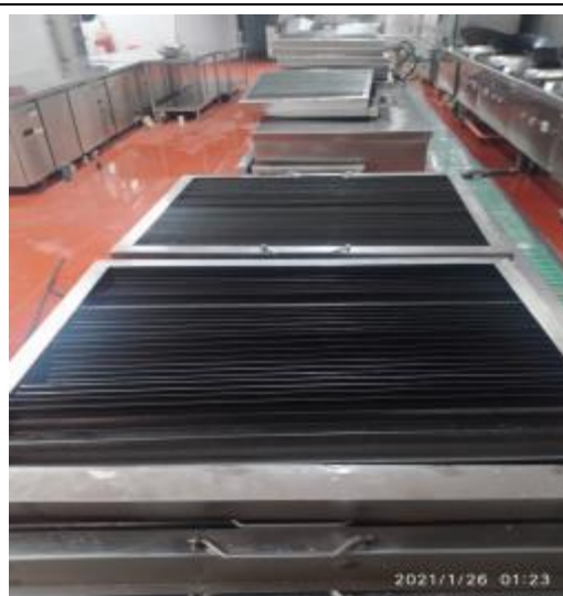
西厨房防火板清洗后
