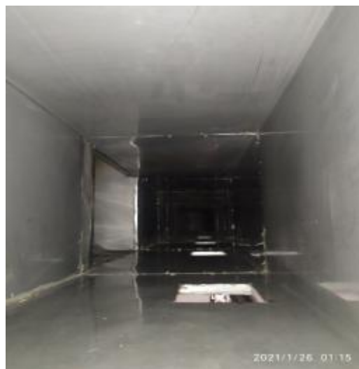
西厨房管道清洗后
