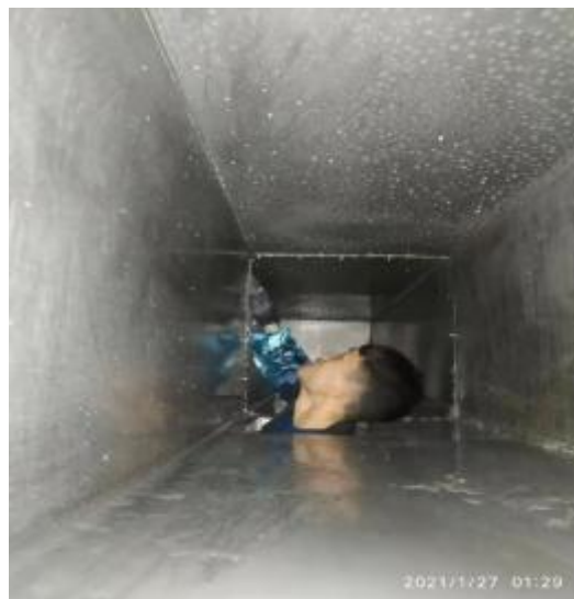
中厨房管道施工
