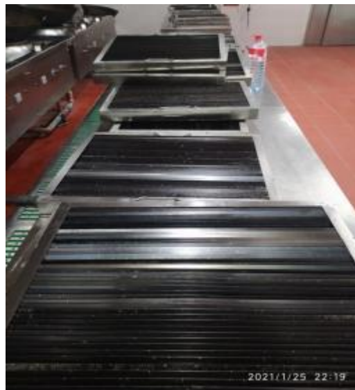
宴会厨房防火板清洗后
