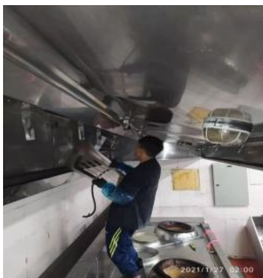
中厨房烟罩施工
