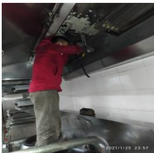
西厨房烟罩施工
