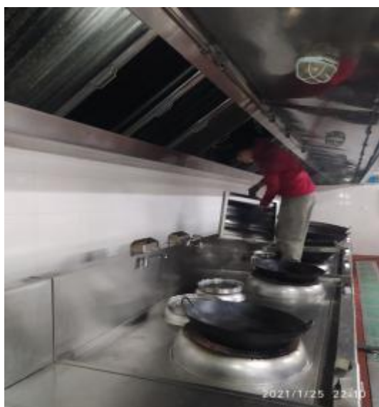
宴会厨房防火板清洗前
