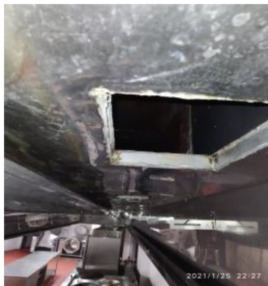
宴会厨房烟罩清洗后
