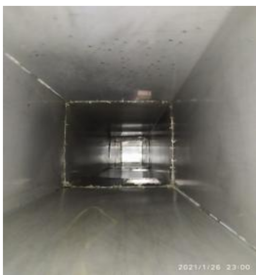
中厨房管道清洗前
