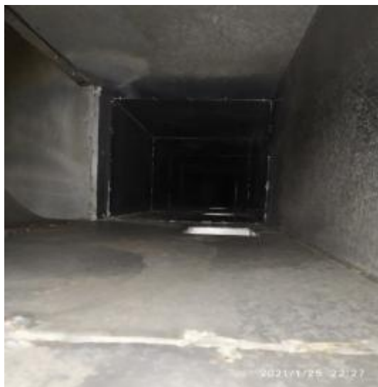
宴会厨房管道清洗前
