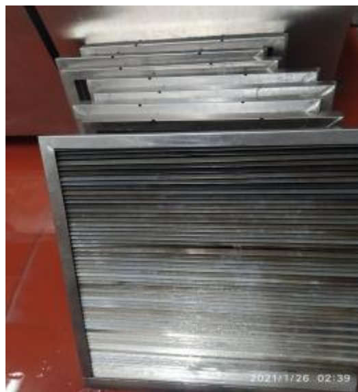
中厨房防火板清洗后
