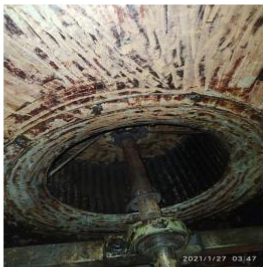
员工厨房风机清洗后
