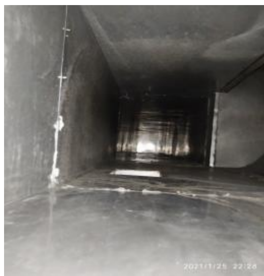
宴会厨房管道清洗后
