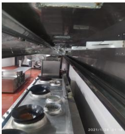
西厨房烟罩清洗后
