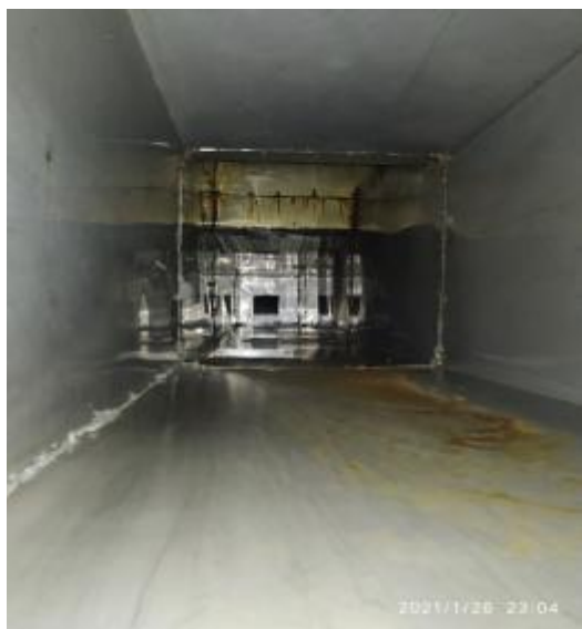
员工厨房管道清洗前
