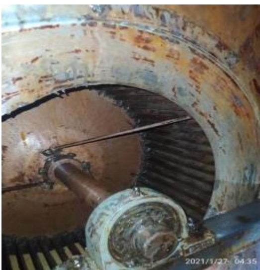
中厨房风机清洗后
