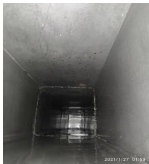
中厨房管道清洗后
