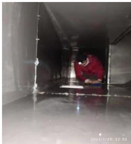
宴会厨房管道施工
