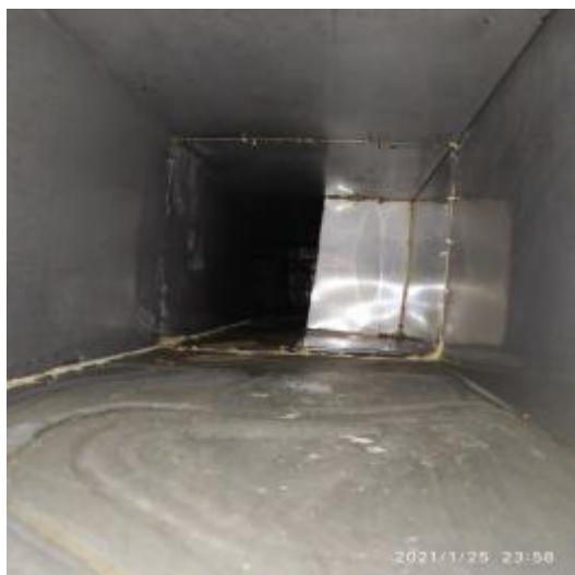
西厨房管道清洗前
