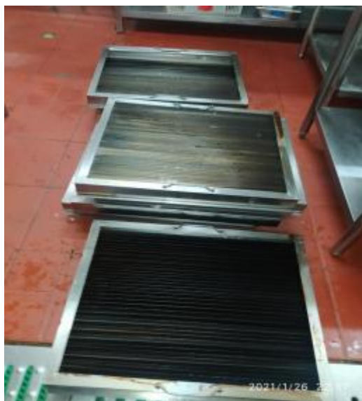
中厨房防火板清洗前
