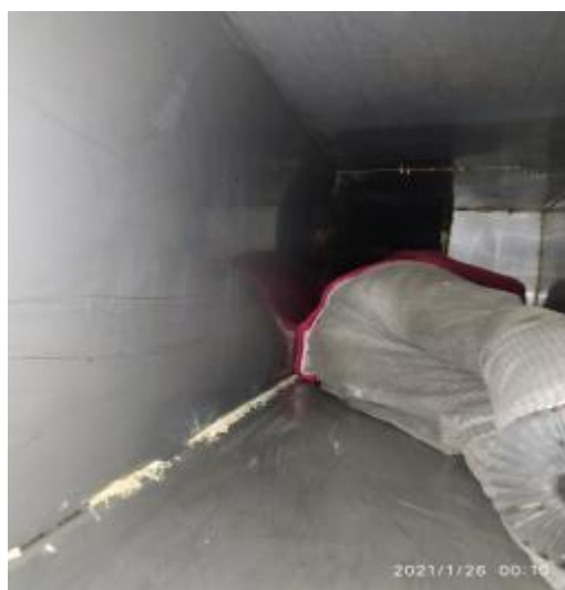
西厨房烟罩施工
