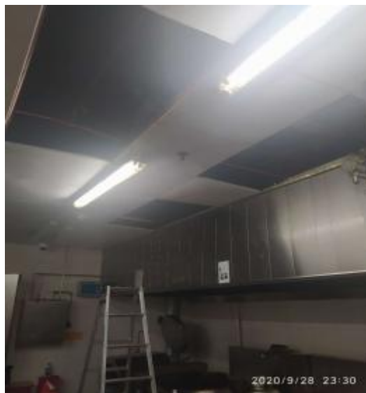
员工厨房风机施工中
