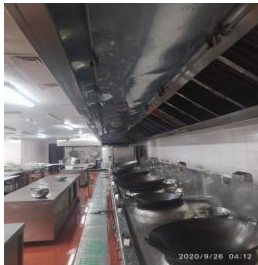
宴会厨房烟罩清洗后
