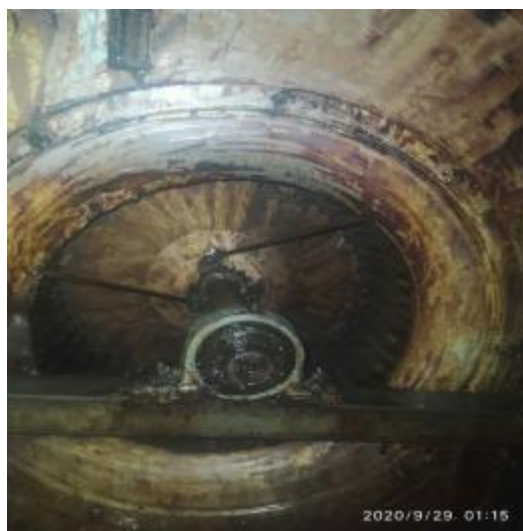
员工厨房风机清洗后
