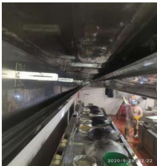
宴会厨房烟罩施工 2
