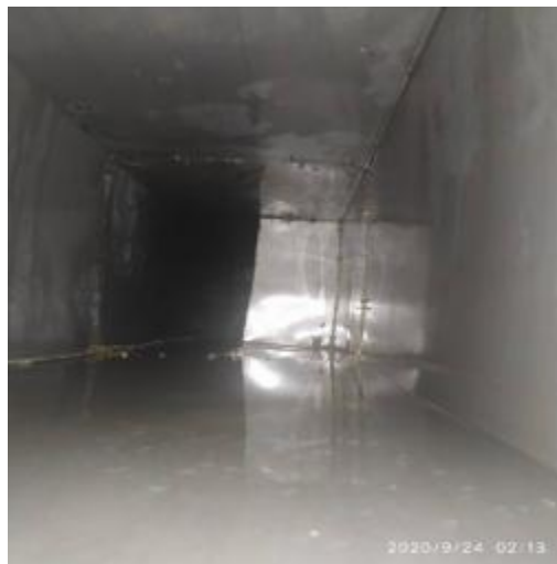
西厨房管道清洗后
