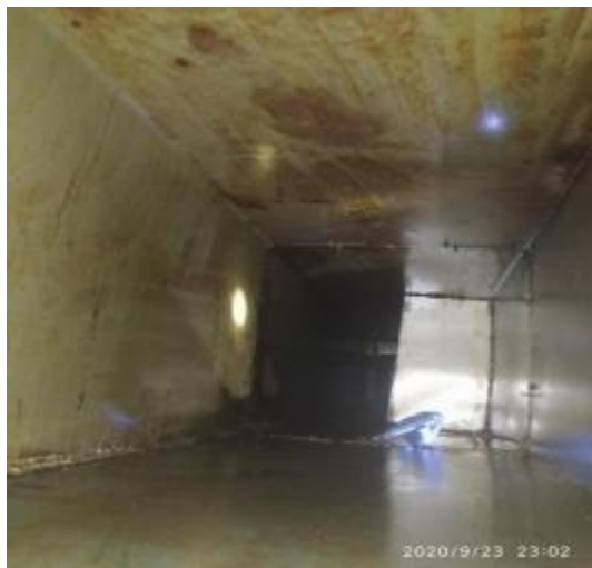
西厨房管道清洗前
