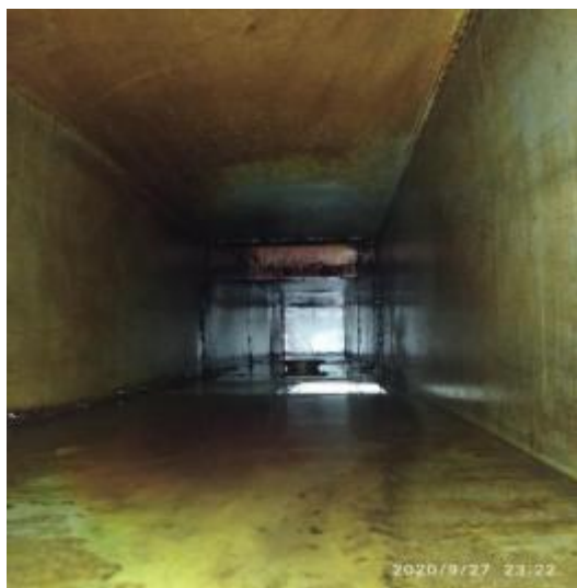
中厨房管道清洗前
