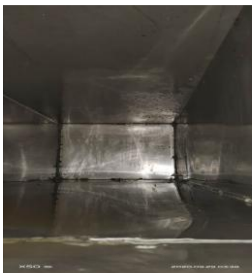
员工厨房管道清洗后
