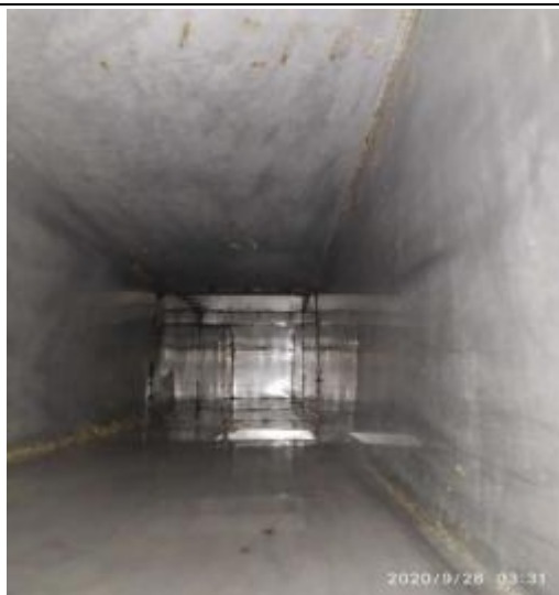
中厨房管道清洗后
