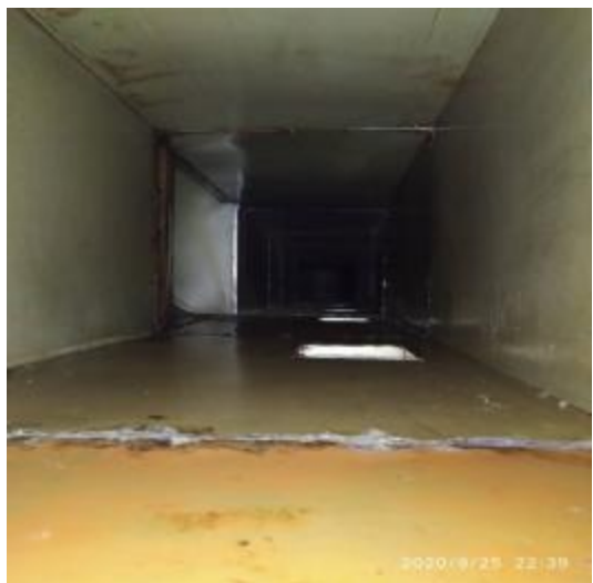
宴会厨房管道清洗前
