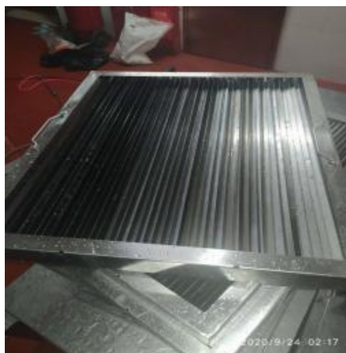
西厨房防火板清洗后
