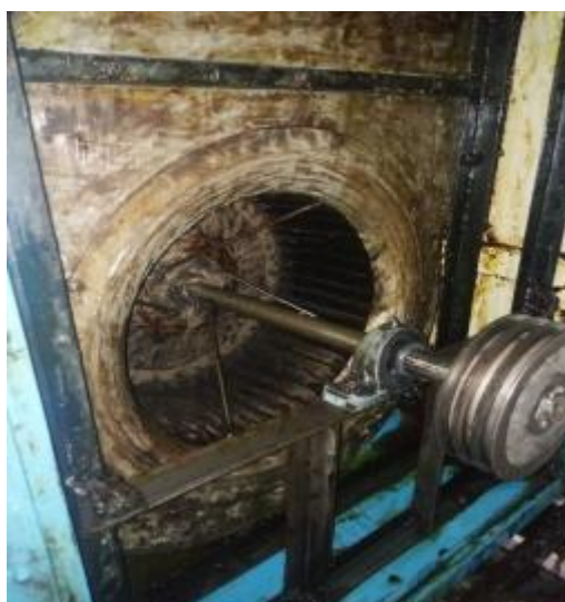
中厨房风机清洗后
