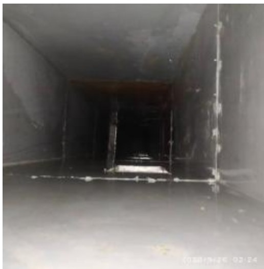
宴会厨房管道清洗后
