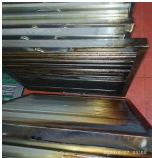
中厨房防火板清洗前
