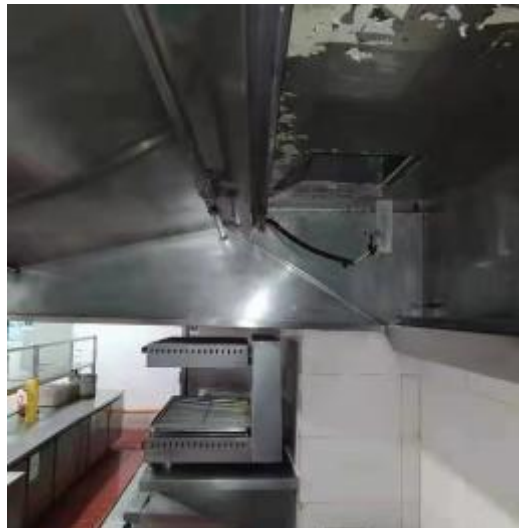
西厨房烟罩清洗后
