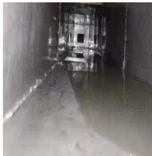
员工厨房管道清洗后
