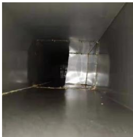
宴会厨房管道清洗前
