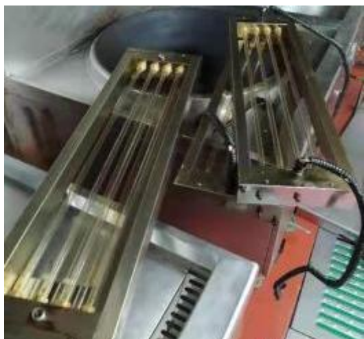
西厨灯管清洗前
