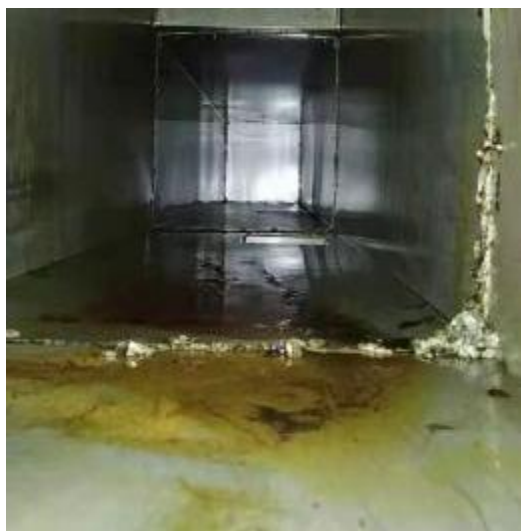
中厨房管道清洗前
