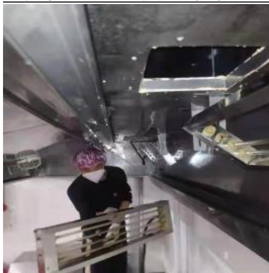
宴会厨房烟罩清洗中
