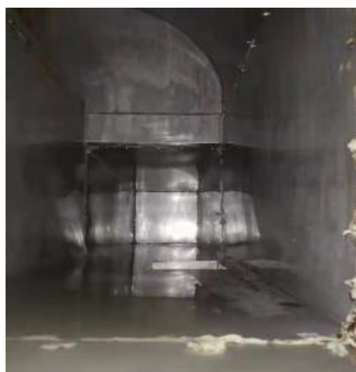
中厨房管道清洗后
