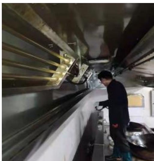
中厨房烟罩施工中
