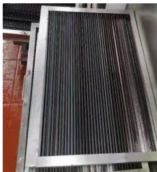
员工厨房防火板清洗后
