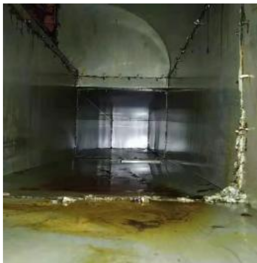
中厨房管道清洗前
