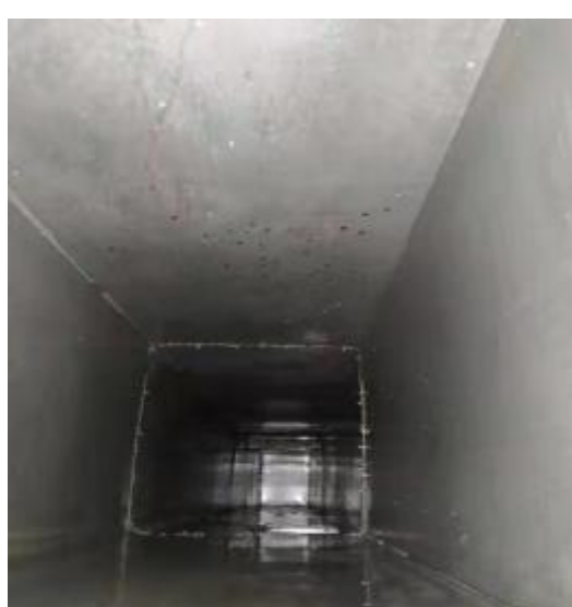
西厨房管道清洗后
