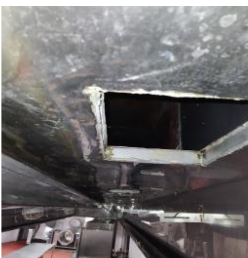
宴会厨房烟罩清洗后
