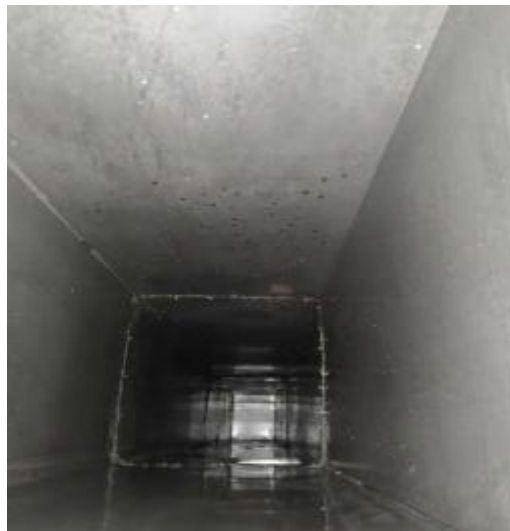
中厨房管道清洗后
