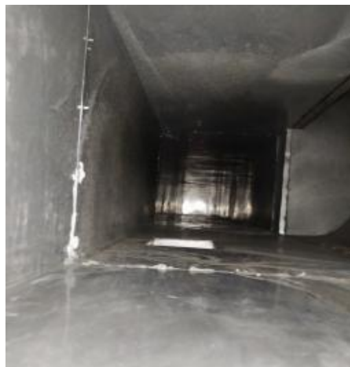
宴会厨房管道清洗后
