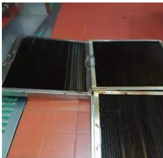
宴会厨房防火板清洗前
