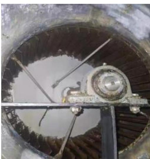
中厨房风机清洗后
