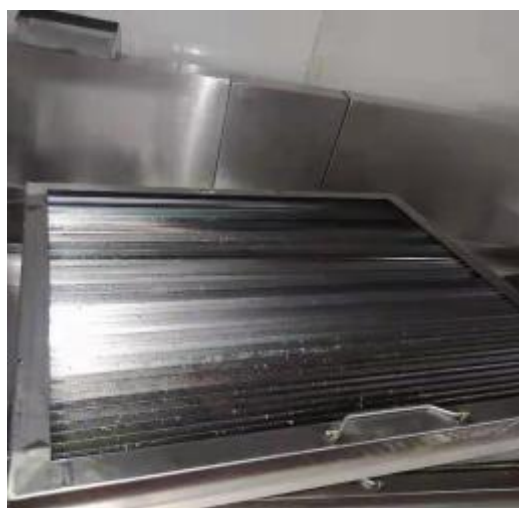
宴会厨房防火板清洗后
