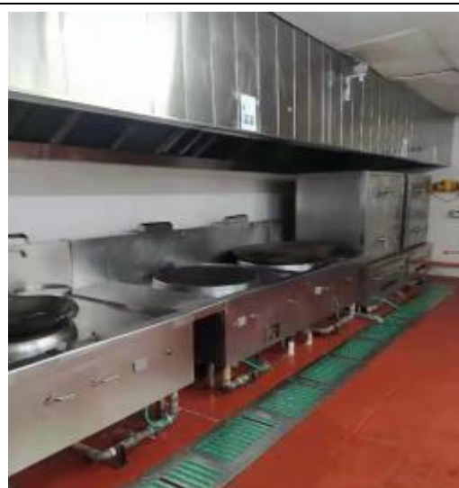
宴会厨房整体烟罩清洗后
