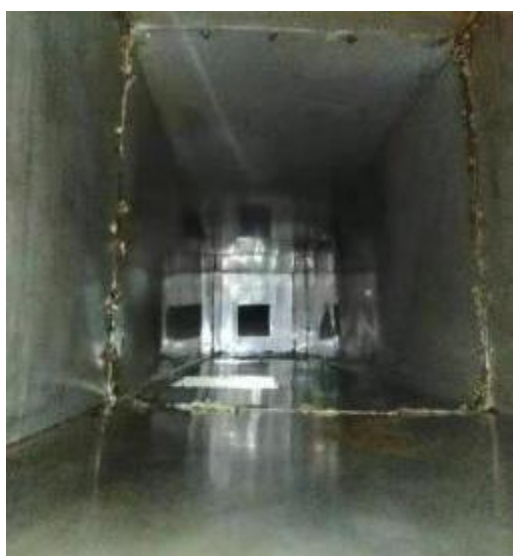
西厨房管道清洗前
