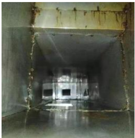
员工厨房管道清洗前
