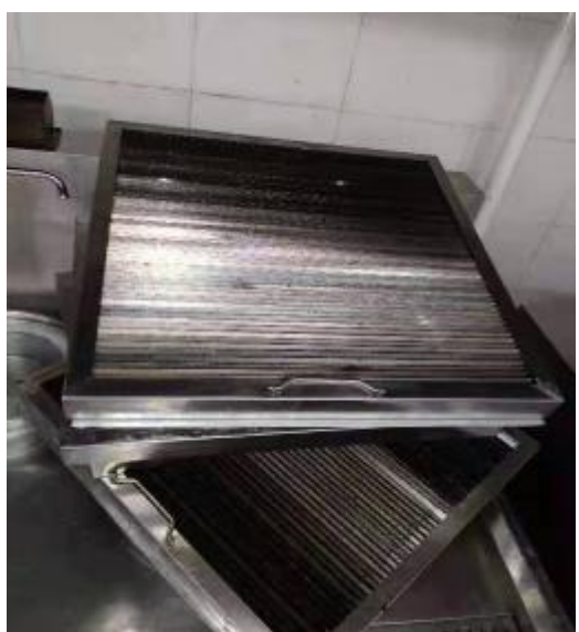
员工厨房防火板清洗前
