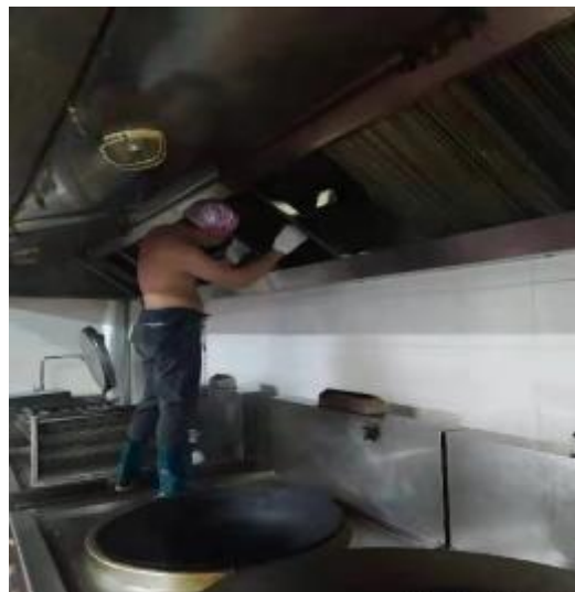
中厨房烟罩施工中
