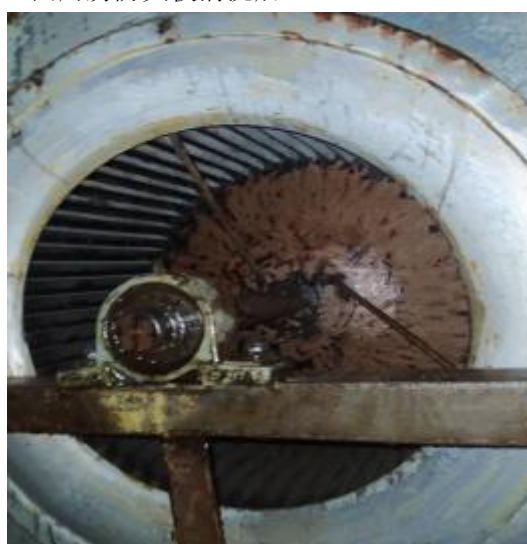
西厨风机清洗后
