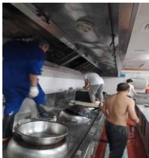
宴会厨房烟罩施工中
