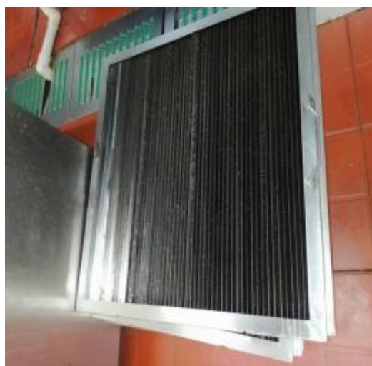
西厨房防火板清洗后
