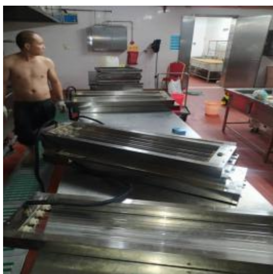
宴会厨房灯管施工中
