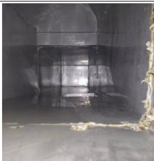
员工厨房管道清洗后
