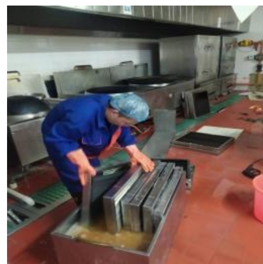
员工厨房防火板清洗中
