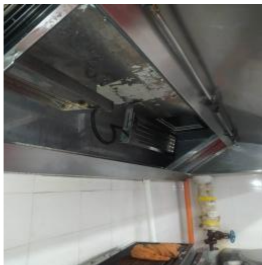
西厨房烟罩清洗后
