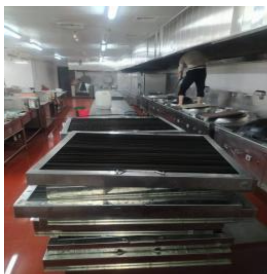
宴会厨房防火板清洗后
