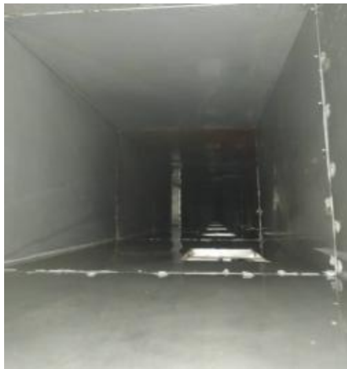
宴会厨房管道清洗后
