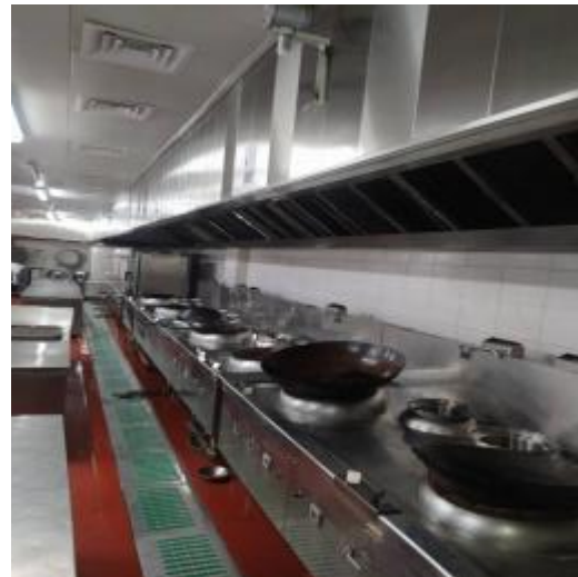
宴会厨房整体烟罩清洗后
