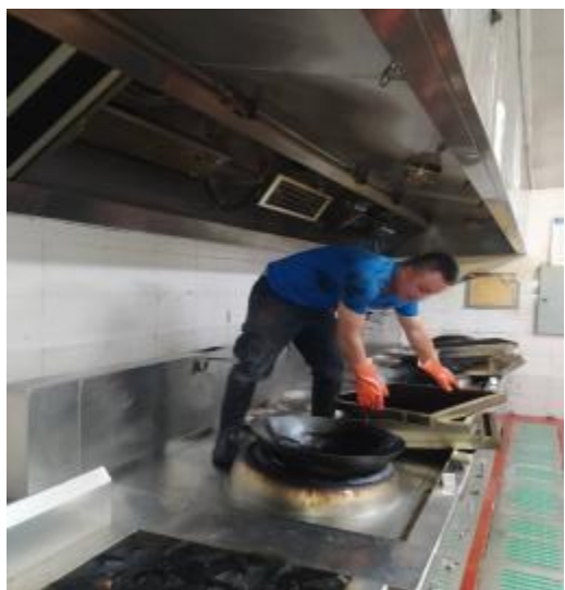
中厨房烟罩施工中
