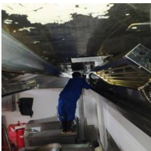
员工厨房烟罩施工中
