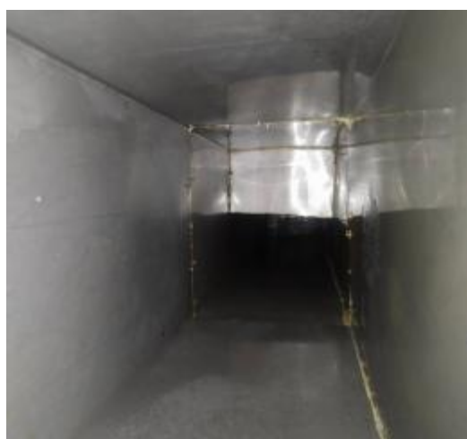
西厨房管道清洗后
