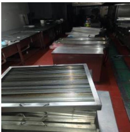
宴会厨房防火板清洗前
