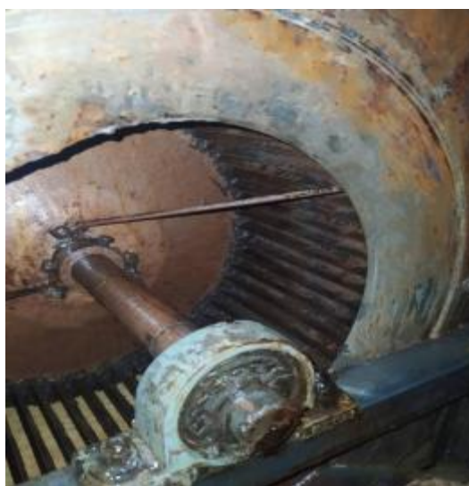
中厨房风机清洗后
