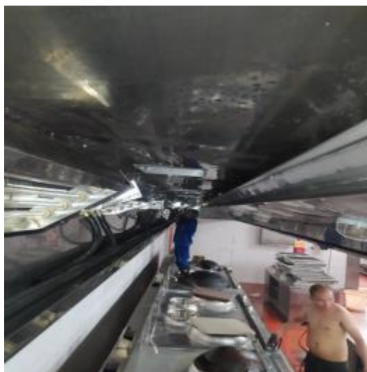
宴会厨房烟罩清洗前
