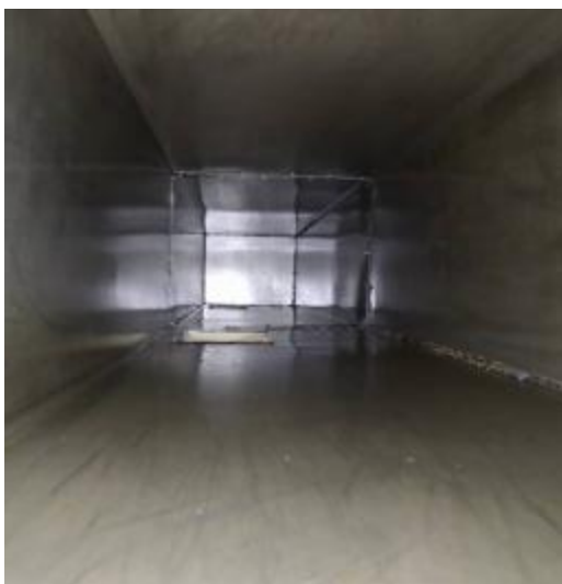
中厨房管道清洗后
