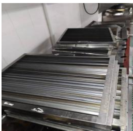
西厨房防火板清洗前
