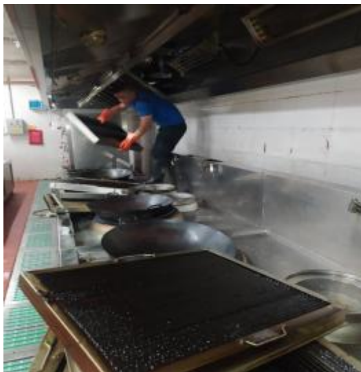
中厨房烟罩施工中
