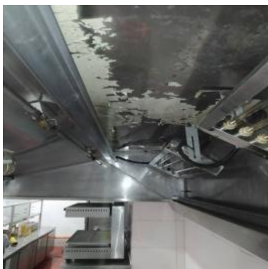
西厨房烟罩清洗中
