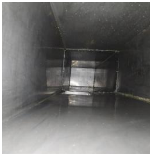
中厨房管道清洗
