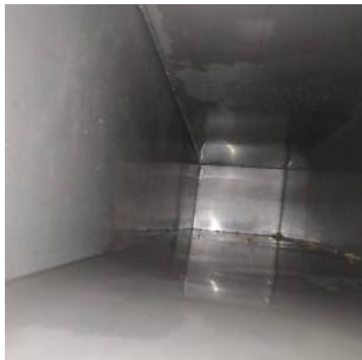
西厨房管道清洗后
