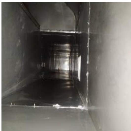
宴会厨房防火板清洗前
