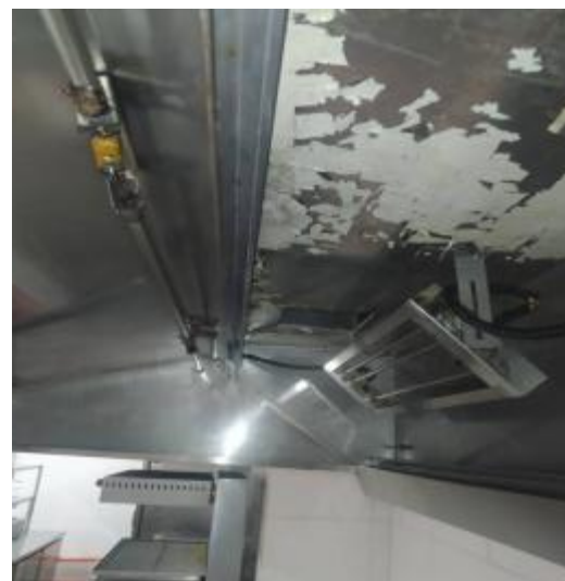
西厨房烟罩清洗后
