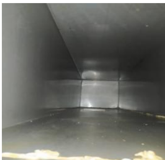
西厨房管道清洗前
