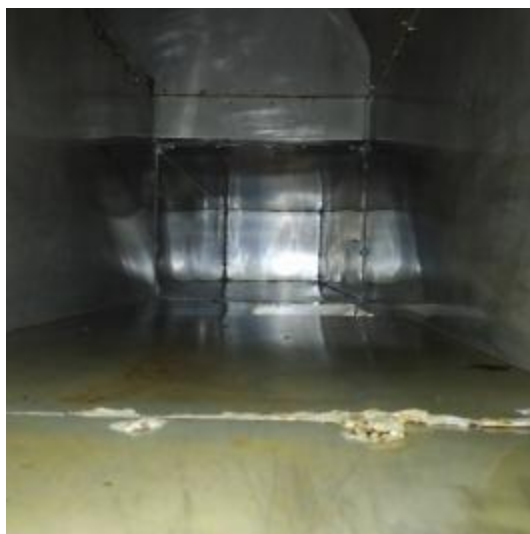
员工厨房管道清洗前
