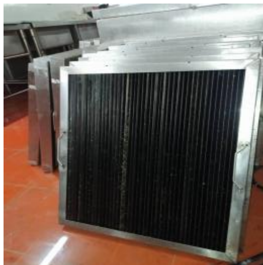
宴会厨房防火板清洗后
