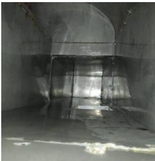
员工厨房管道清洗后
