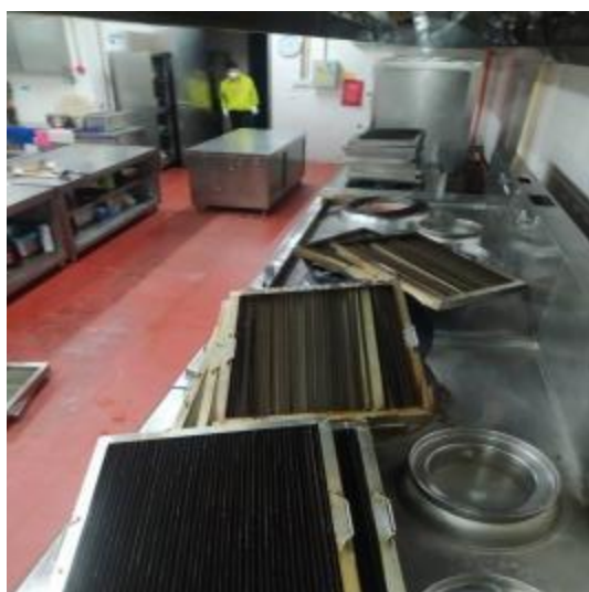
中厨房烟罩防火板施工中
