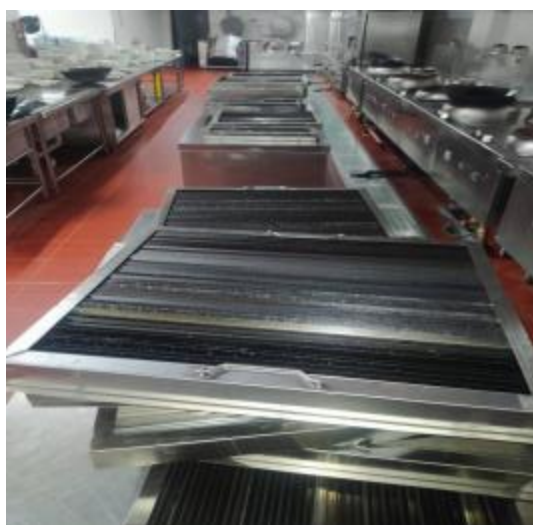
宴会厨房防火板清洗前
