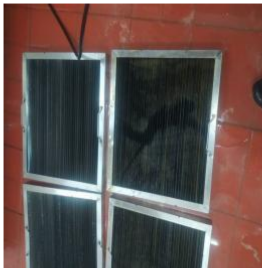
西厨房防火板清洗后
