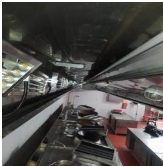
宴会厨房烟罩清洗中
