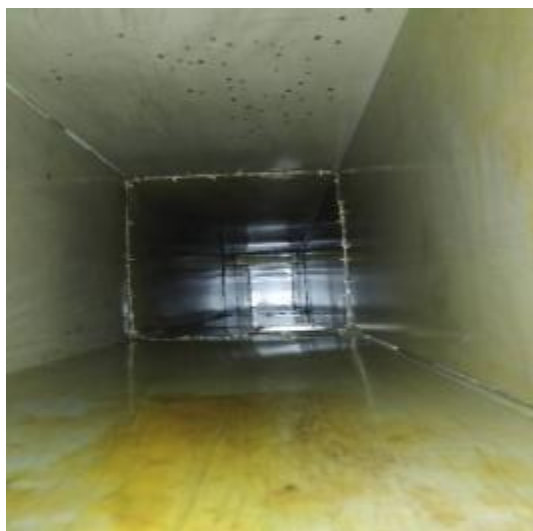
中厨房管道清洗前
