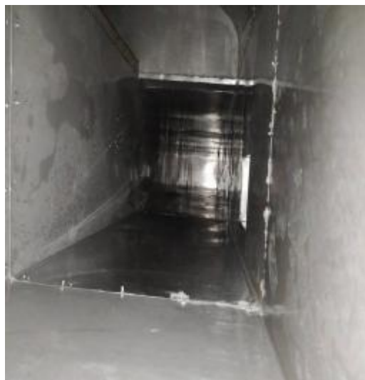
宴会厨房管道清洗后
