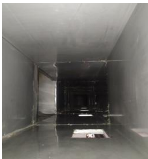
西厨房管道清洗后
