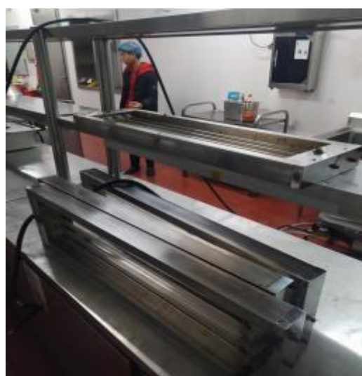
西厨房灯管清洗后
