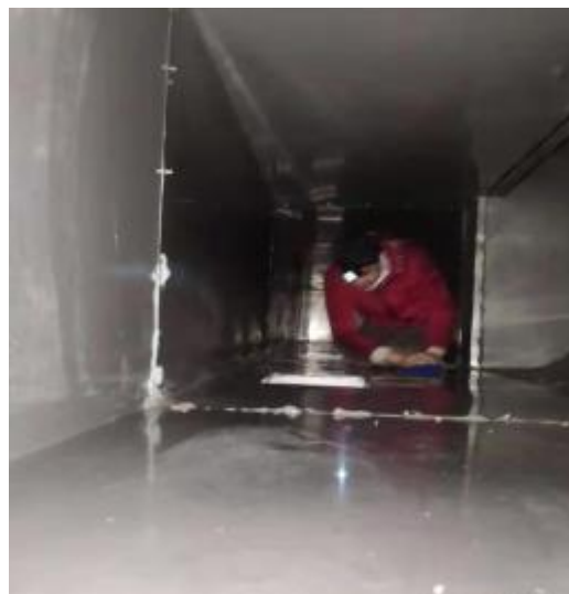
宴会厨房管道施工
