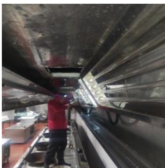
宴会厨房烟罩施工中
