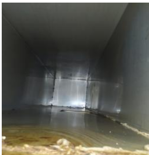
中厨房管道清洗前
