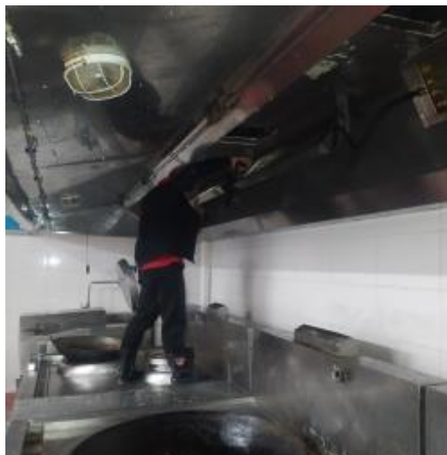
员工厨房烟罩清洗中
