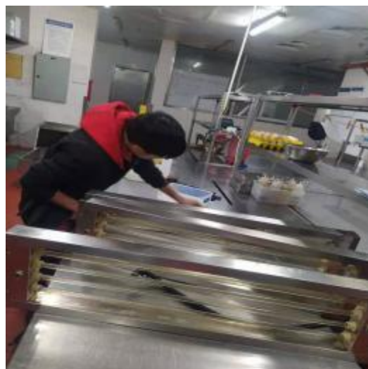
中厨房灯管道清洗中
