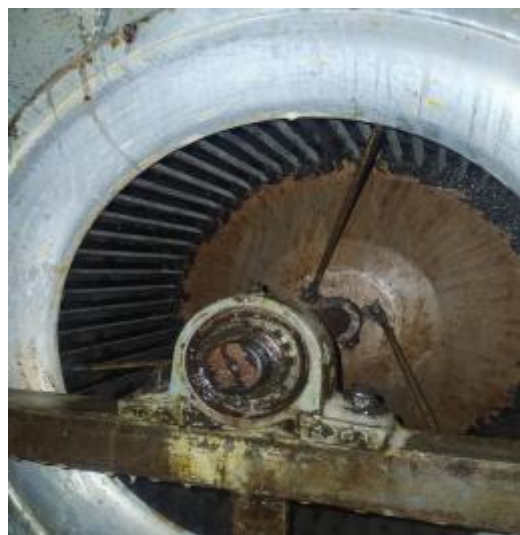
西厨房风机清洗后
