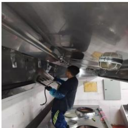
中厨房烟罩施工
