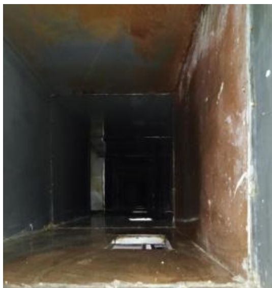
宴会厨房管道清洗前
