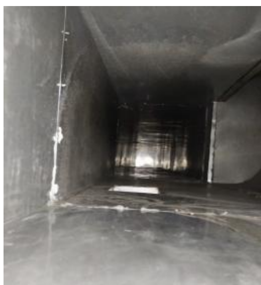
宴会厨房管道清洗后
