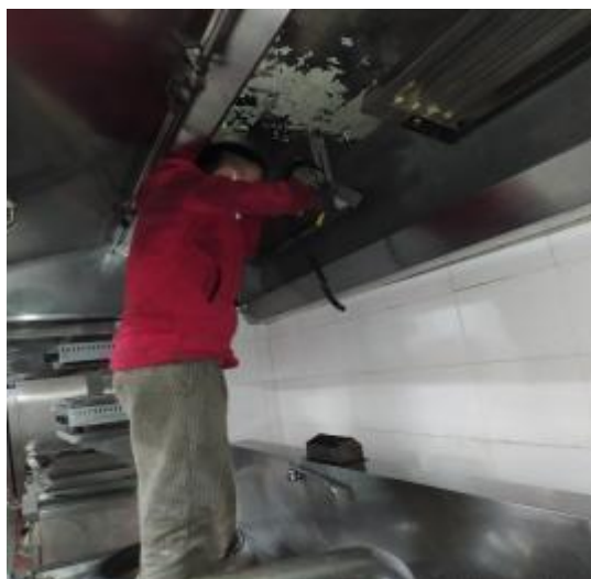
西厨房烟罩施工
