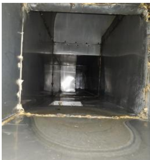
西厨房管道清洗前
