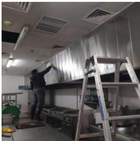
西厨房烟罩清洗中
