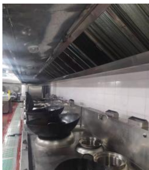
宴会厨房烟罩清洗前
