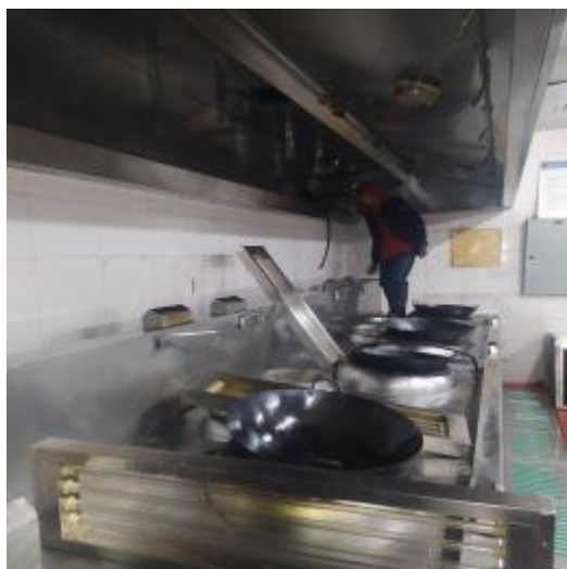
中厨房烟罩施工中
