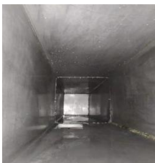
中厨房管道清洗后
