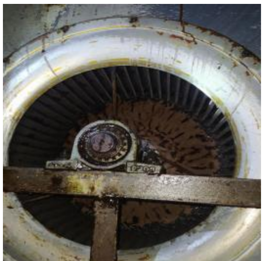
西厨房风机清洗前
