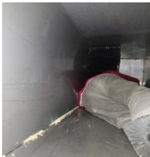
西厨房烟罩施工
