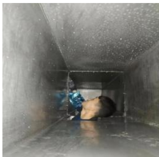
中厨房管道施工
