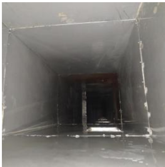
员工厨房管道清洗前
