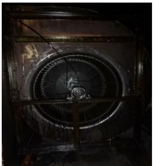
员工厨房风机清洗前
