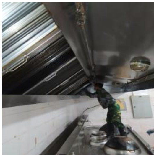
中厨房烟罩施工中
