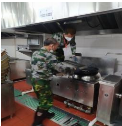
西厨房烟罩清洗中
