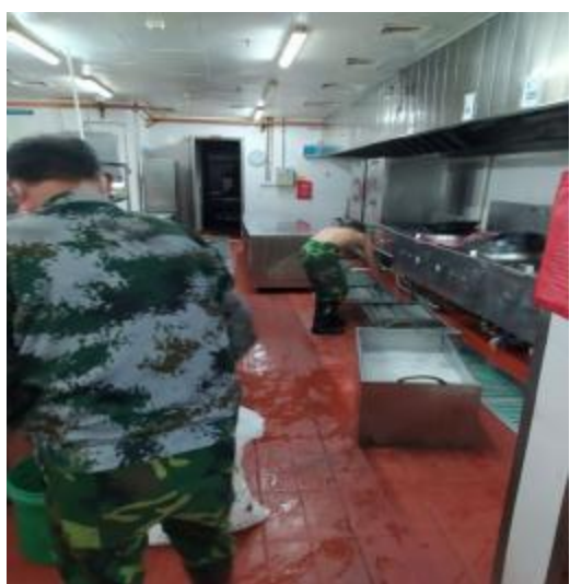
中厨房烟罩施工中
