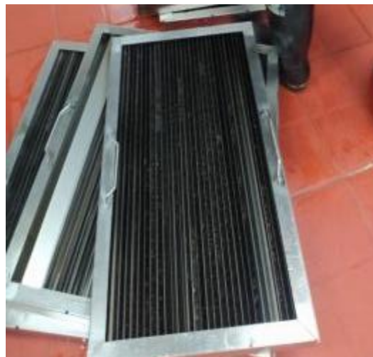
西厨房防火板清洗后
