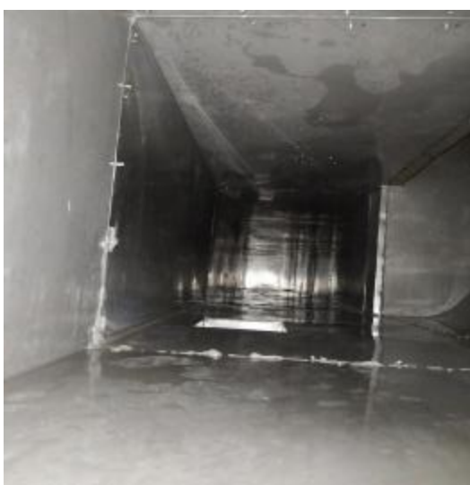
宴会厨房灯管清洗后
