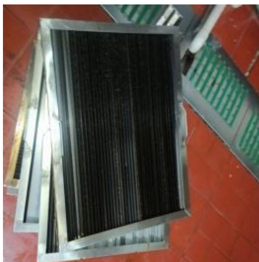
中厨房防火板清洗前
