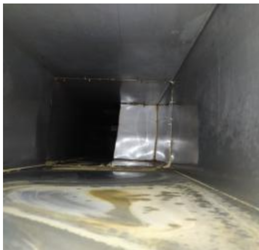
西厨房管道清洗前
