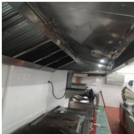
西厨房烟罩清洗后
