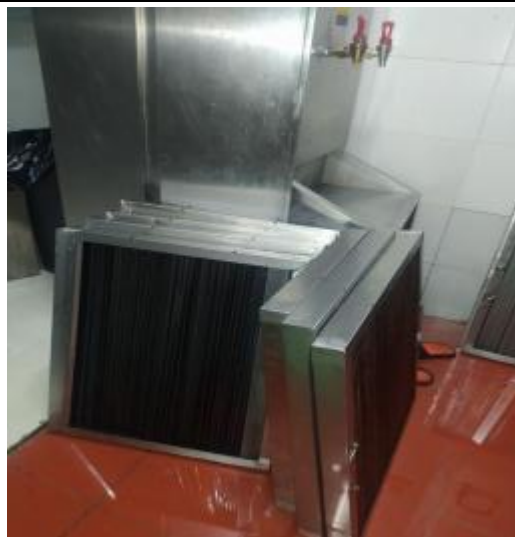
员工厨房防火板清洗后
