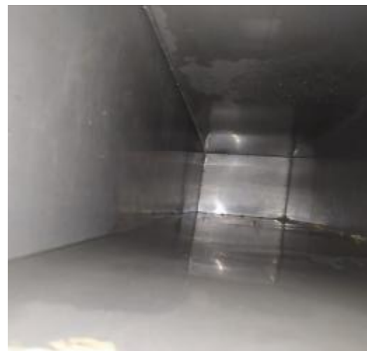
西厨房管道清洗后
