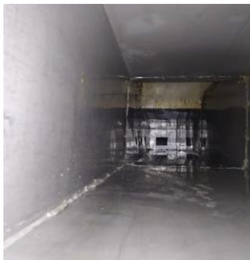
中厨房管道清洗后
