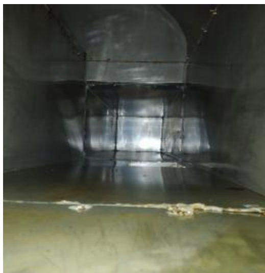
员工厨房管道清洗前
