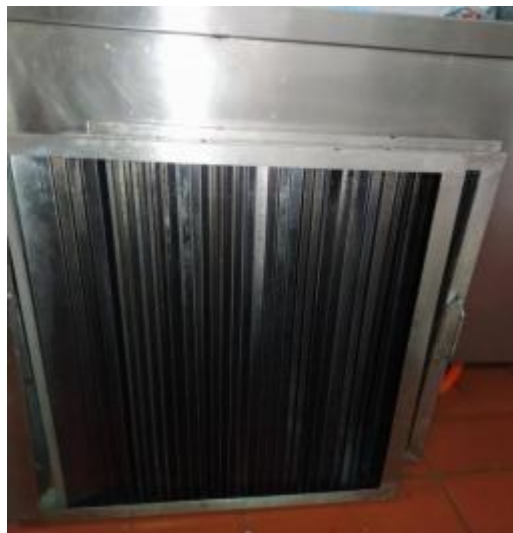
中厨房防火板清洗后
