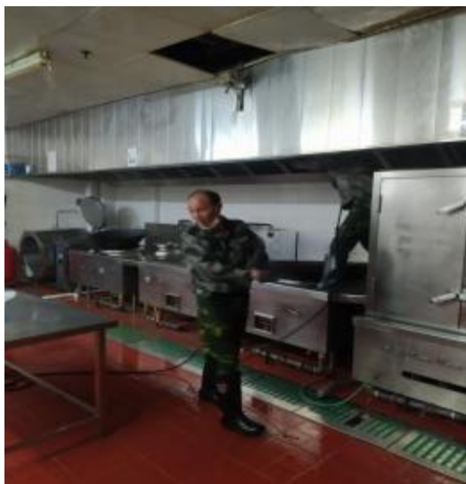
员工厨房烟罩清洗中
