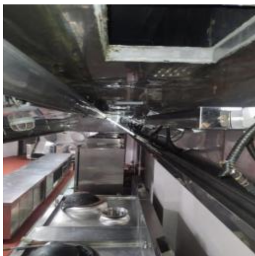
宴会厨房烟罩清洗前
