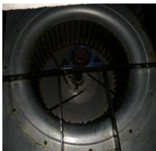
西厨风机清洗后
