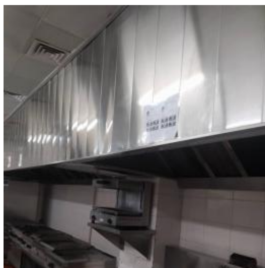
西厨房烟罩清洗后
