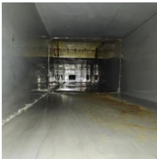
中厨房管道清洗前
