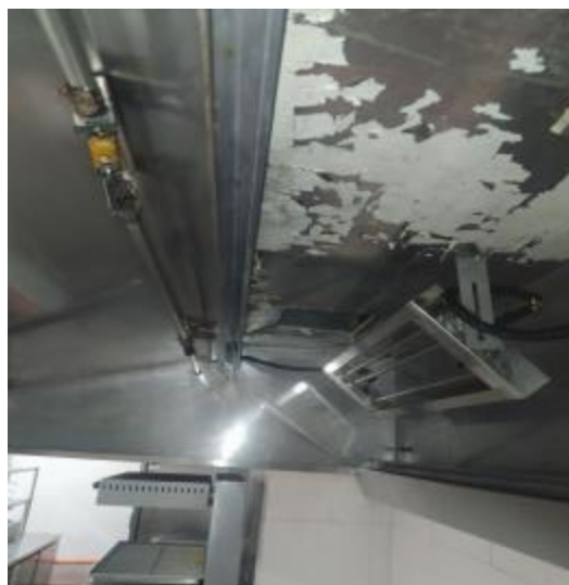
西厨房烟罩清洗后
