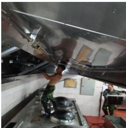
中厨房烟罩施工中
