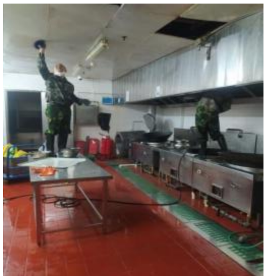
员工厨房烟罩清洗中
