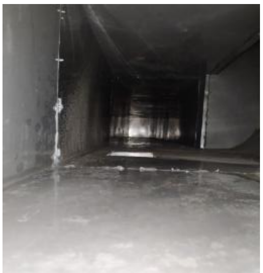
宴会厨房灯管清洗前
