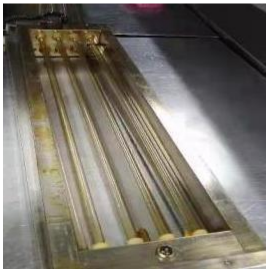
宴会厨房灯管清洗前
