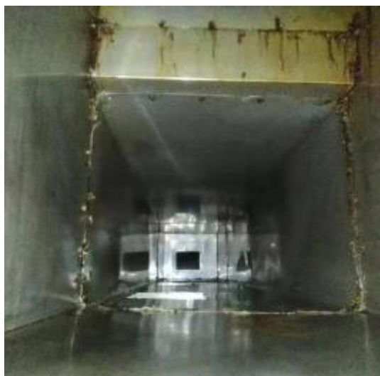
宴会厨房管道清洗前
