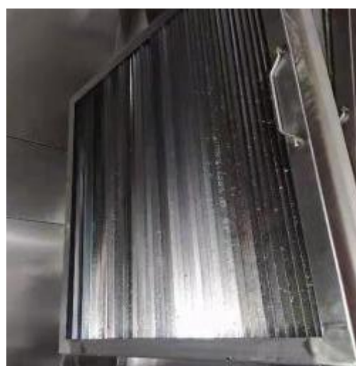
宴会厨房防火板清洗后
