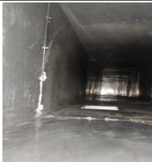
宴会厨房管道清洗后
