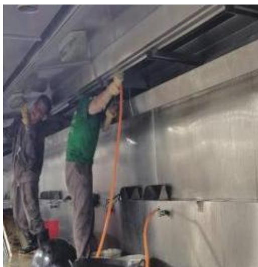
中厨房烟罩施工中
