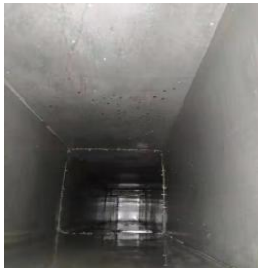
西厨房管道清洗后
