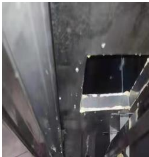
宴会厨房烟罩清洗后
