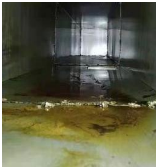
西厨房管道清洗前
