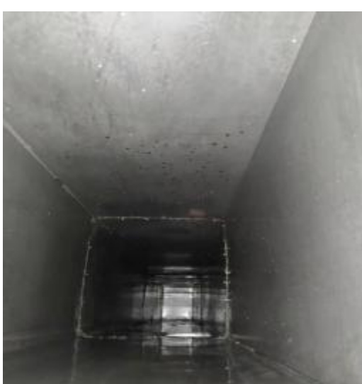
中厨房管道清洗后
