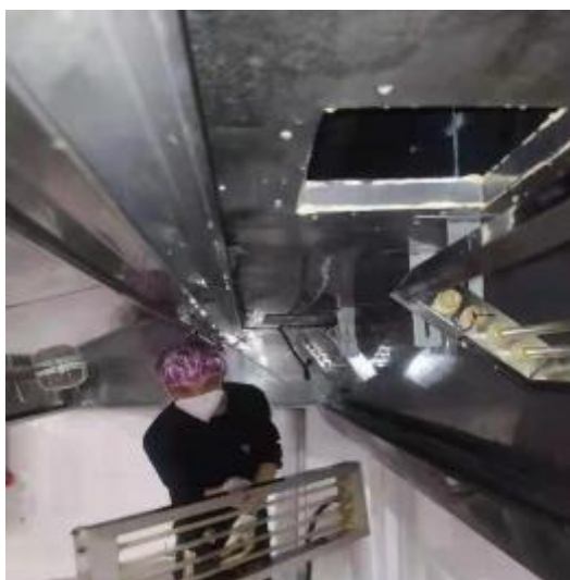
中厨房烟罩施工中
