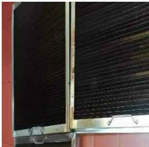
中厨房防火板清洗前
