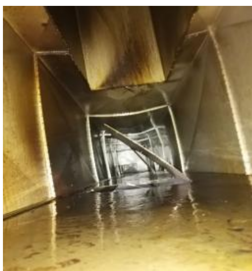
中厨房管道清洗前
