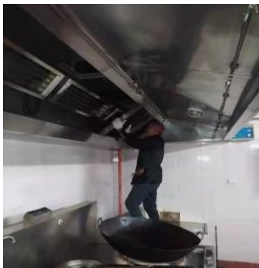
宴会厨房烟罩清洗中
