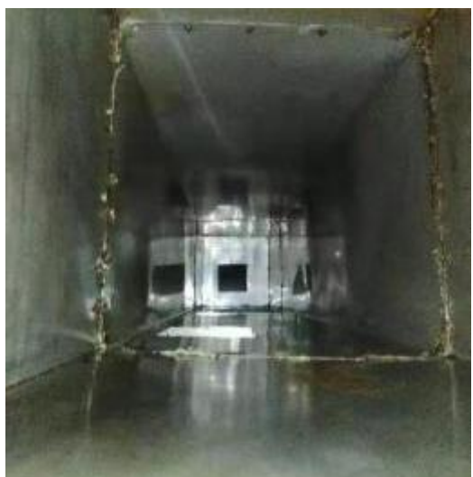
员工厨房管道清洗前
