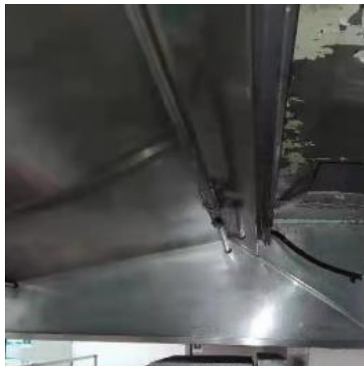
西厨房烟罩清洗后
