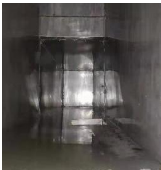
中厨房管道清洗后
