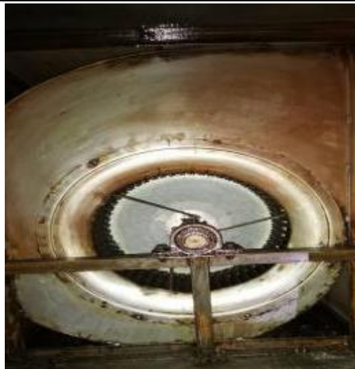
中厨房风机清洗后
