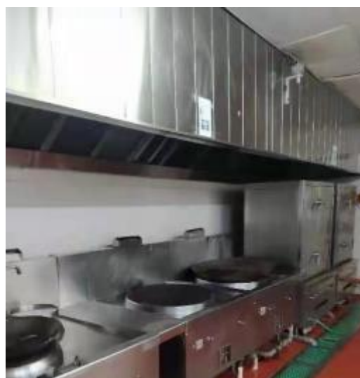
宴会厨房整体烟罩清洗后
