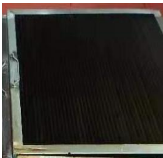
宴会厨房防火板清洗前
