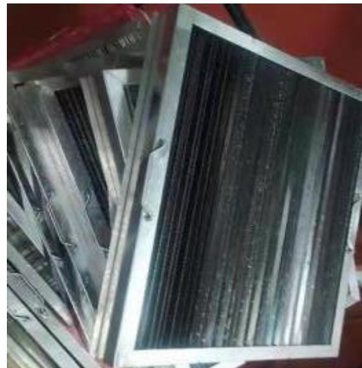
西厨房防火板清洗后
