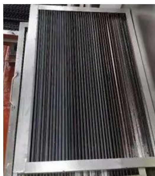
员工厨房防火板清洗后
