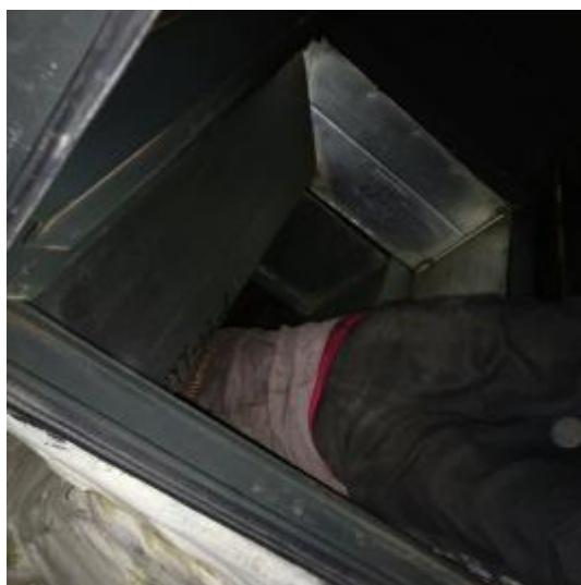
风机管道施工中
