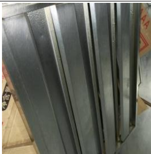
防火板清洗后
