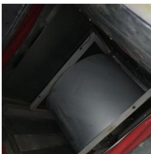
风机管道清洗后
