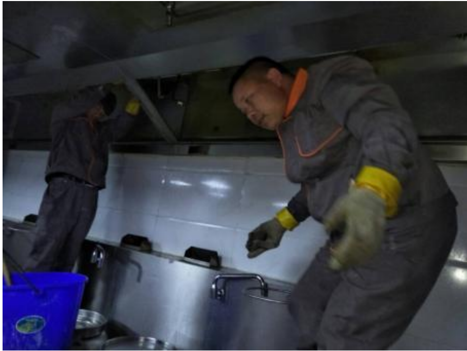
烧腊间烟罩施工中
