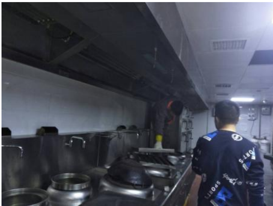
宴会厨房烟罩施工中
