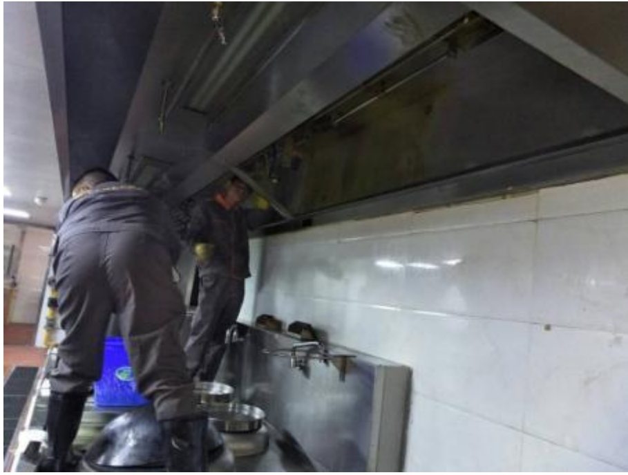
中厨房烟罩施工中
