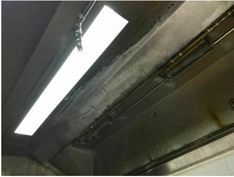
西厨房烟罩清洗后
