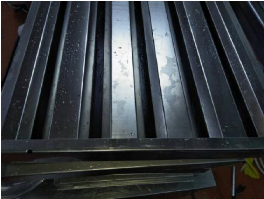
中厨房挡板清洗后
