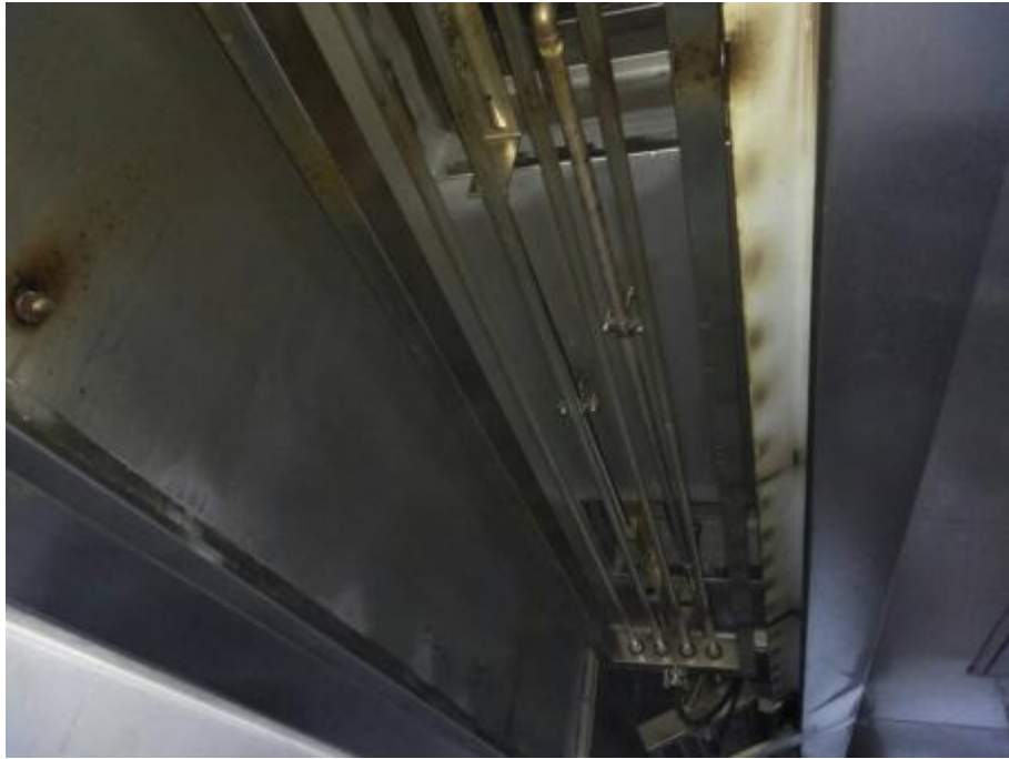
宴会厨房烟罩清洗前
