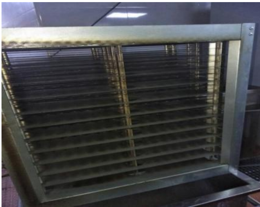
宴会厨房净化器清洗前
