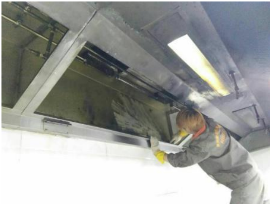
西厨房烟罩施工中
