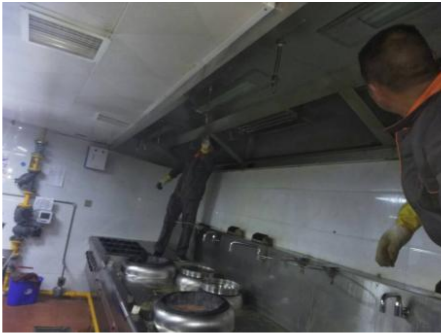
21 楼厨房烟罩施工中
