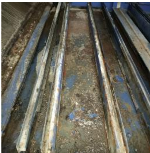
净化器机箱清洗前
