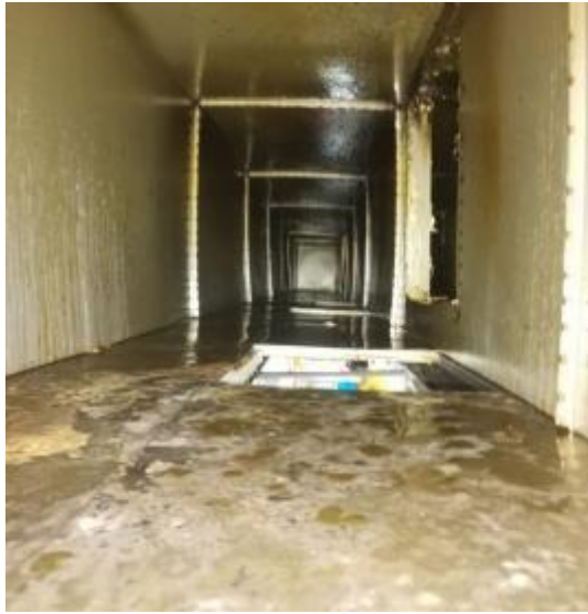
明档管道清洗前
