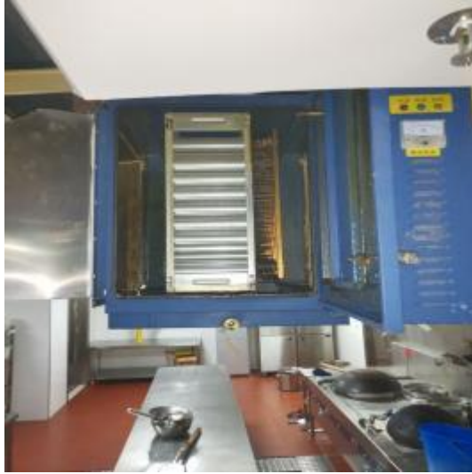
净化器施工中
