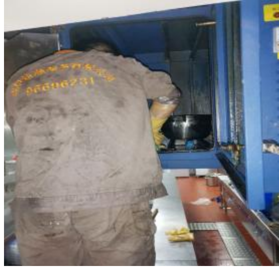
净化器机箱施工中
