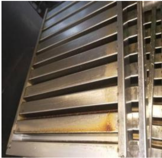
防火板清洗前
