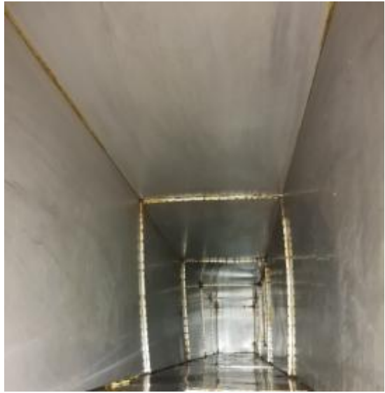
明档管道清洗后
