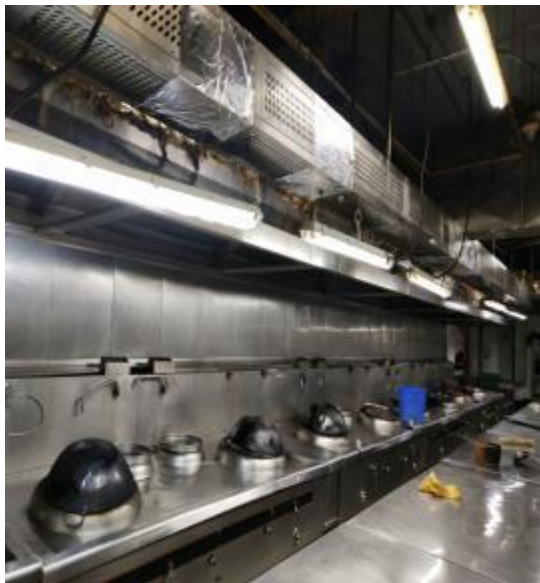
烟罩施工清洗前
