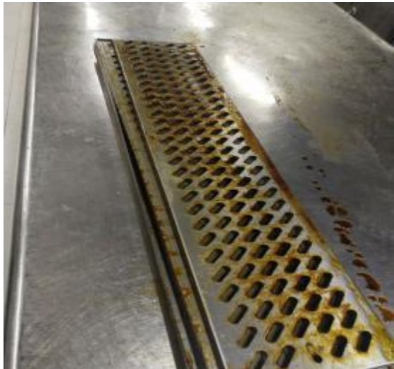
新风管清洗前
