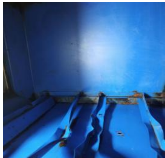
净化器内部清洗后
