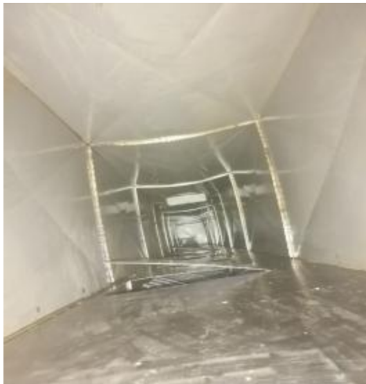
管道清洗前后
