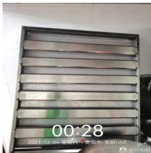
防火板清洗后
