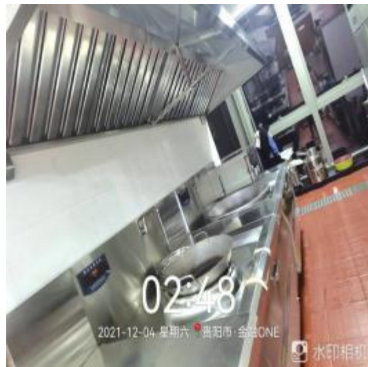
厨房整体清洗后
