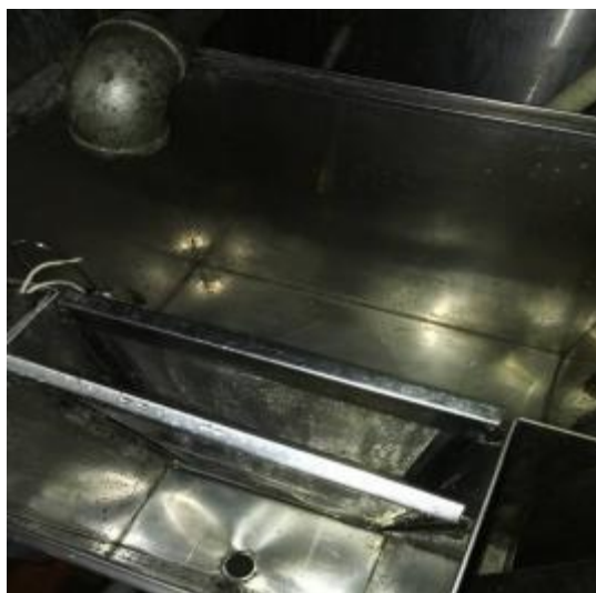
运水控制箱箱清洗后
