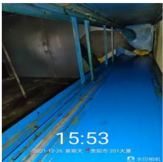
净化器机箱施工中
