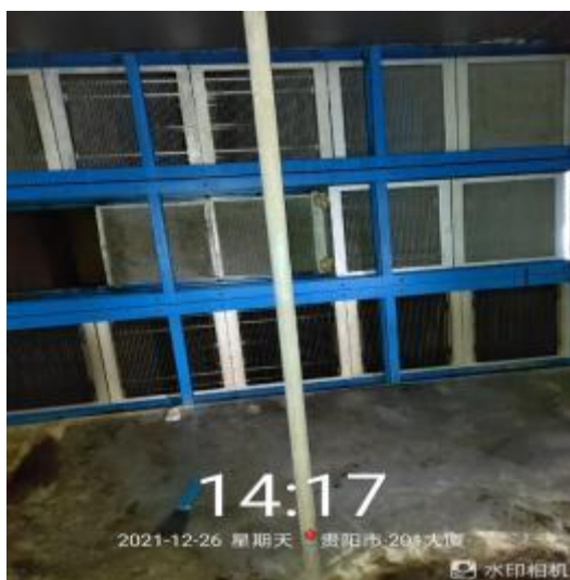
净化器施工中
