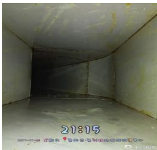
横向管道清洗后
