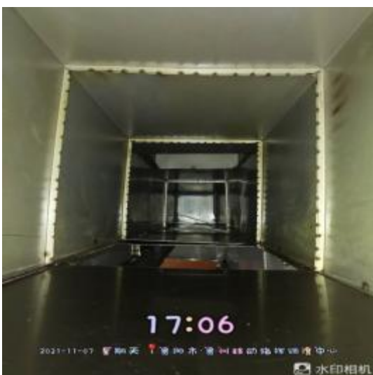
2楼管道清洗后
