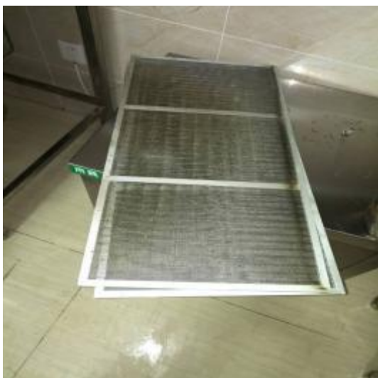
2楼过滤网清洗后
