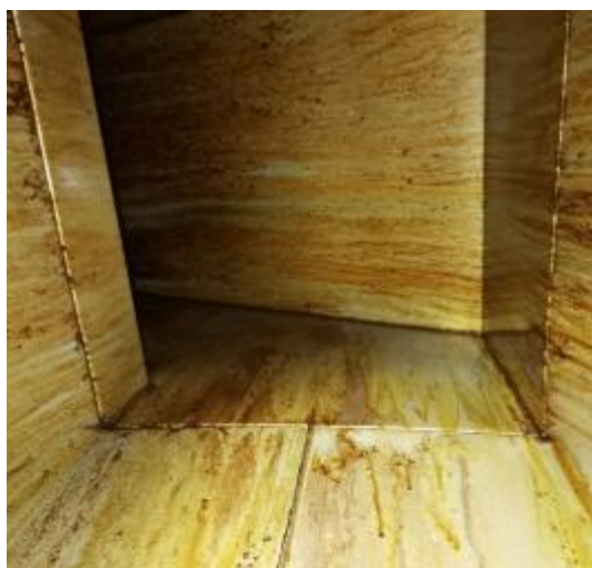
横向管道清洗前
