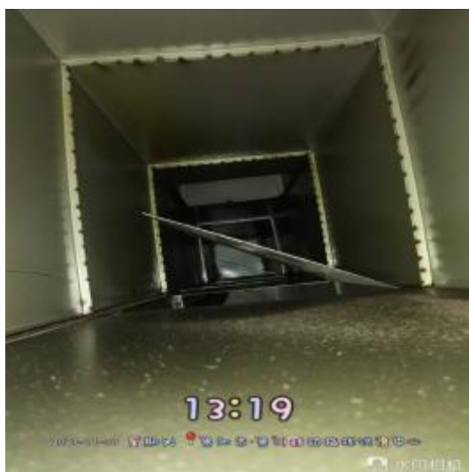
2楼管道清洗前
