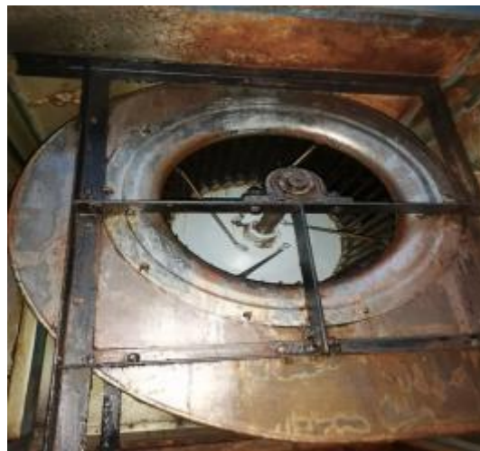
风机管道内部清洗后
