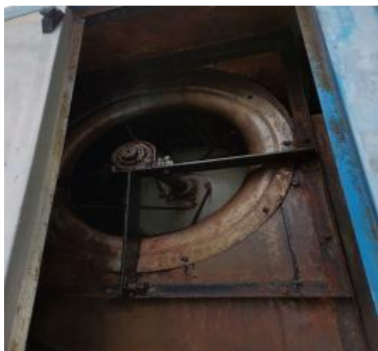
风机管道内部清洗前
