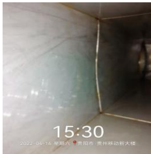
2楼管道清洗后
