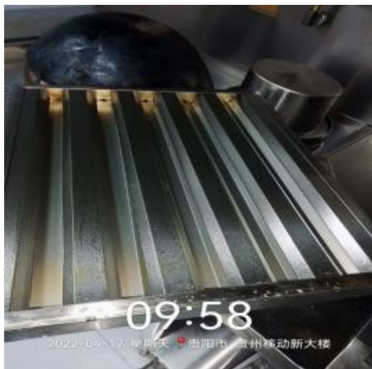
3楼防火板清洗前
