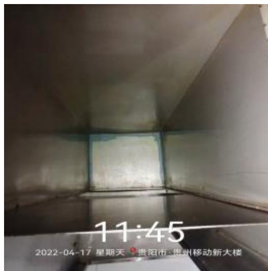
3楼管道施工后
