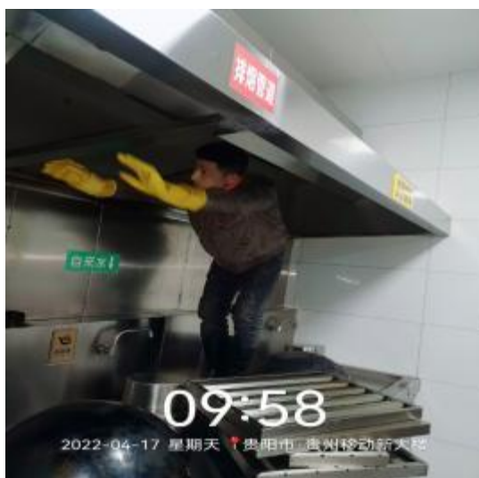
3楼防火板清洗中
