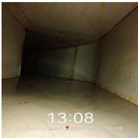
2楼管道清洗前
