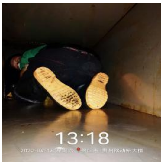
2楼管道风机清洗中
