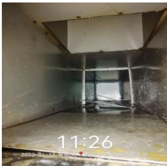
3楼管道清洗前
