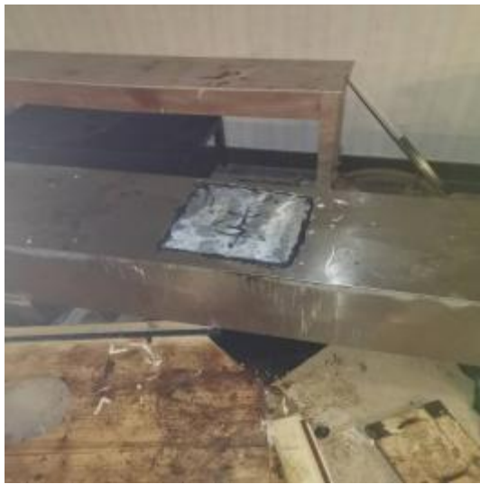
管道外观施工中
