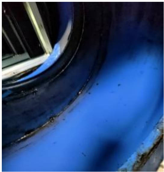
风机机箱清洗后
