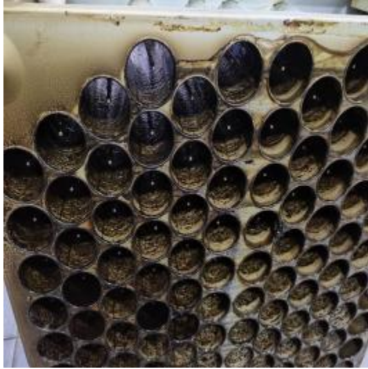
净化器施工中
