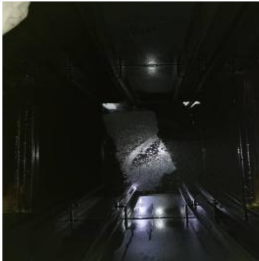
净化器机箱清洗前
