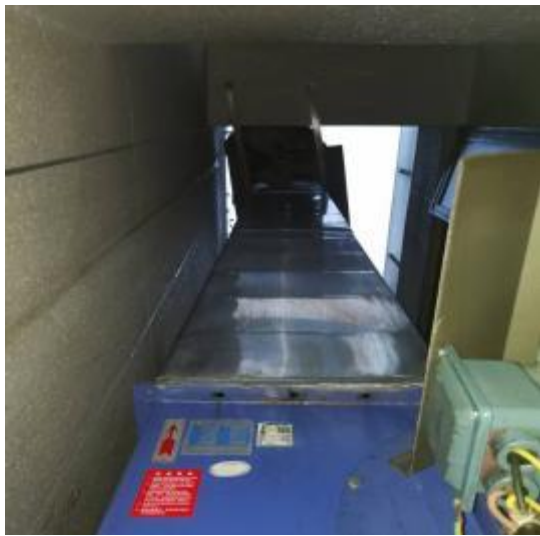
管道外观清洗后工后
