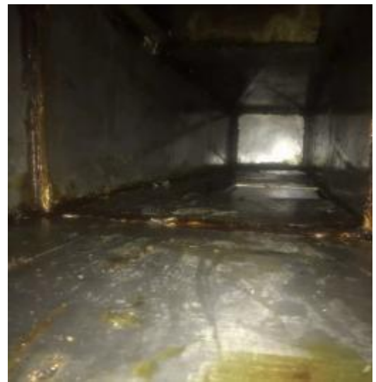
鱼天天管道清洗后
