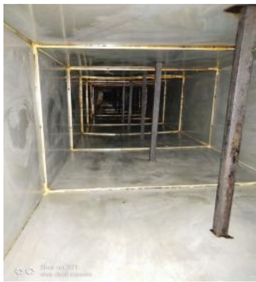
主管道清洗后 2
