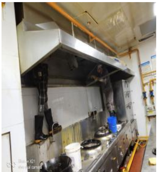
松烟楼烟罩施工
