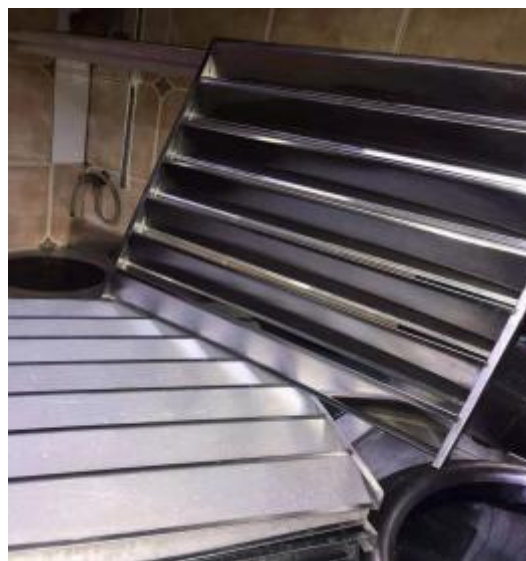
米馥防火板清洗后
