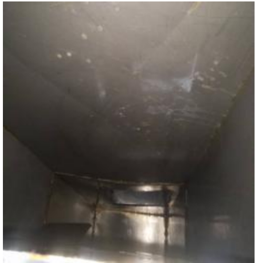
珑栖管道清洗后
