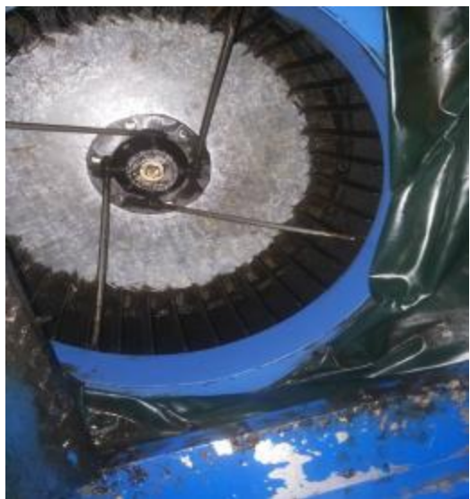
裕丰豆米火锅风机清洗后
