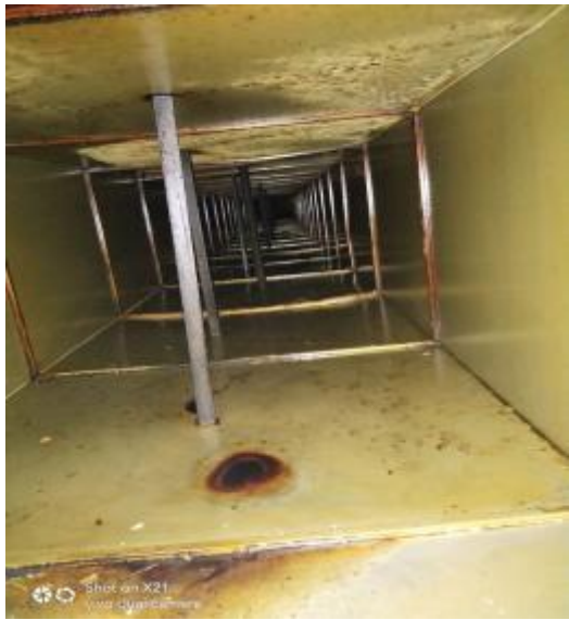
主管道清洗前 2
