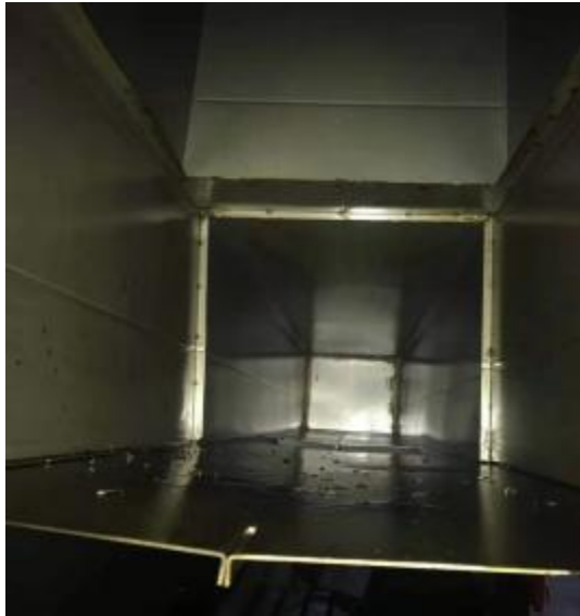
心艾餐厅管道清洗前
