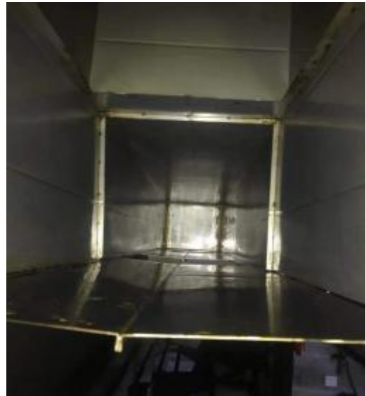
心艾餐厅管道清洗后
