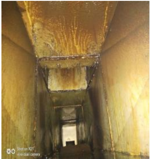
松烟楼管道清洗前
