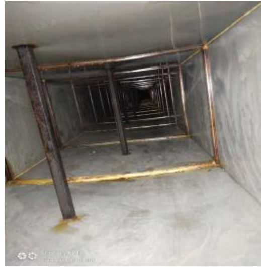
主管道清洗后 1
