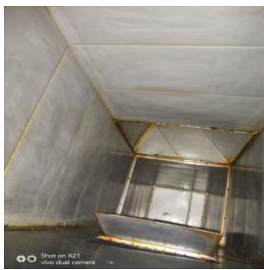
米馥管道清洗后
