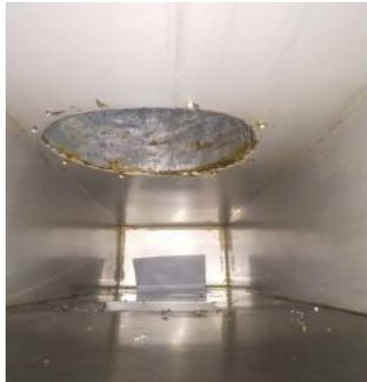
裕丰豆米火锅管道清洗后
