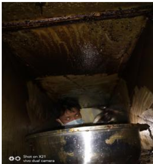
松烟楼管道施工
