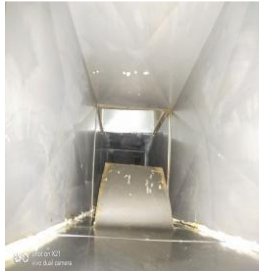
松烟楼管道清洗后
