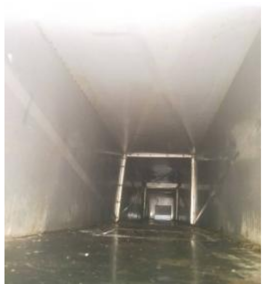
桥香园管道清洗后
