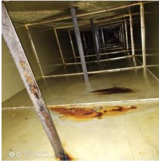
主管道清洗前 1
