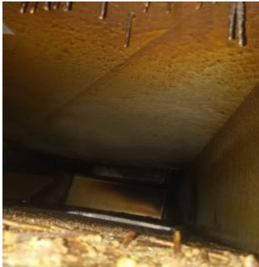
珑栖管道清洗前
