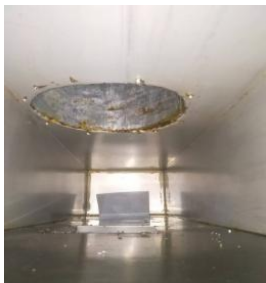
海鲜遇上面管道清洗后
