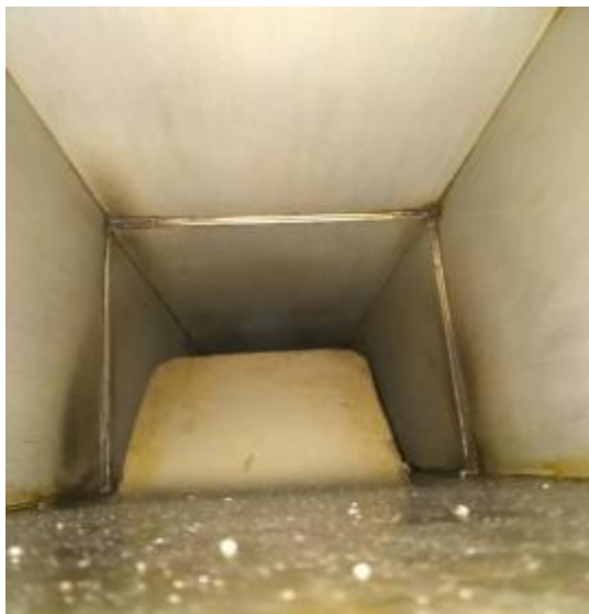
阅小串管道清洗前
