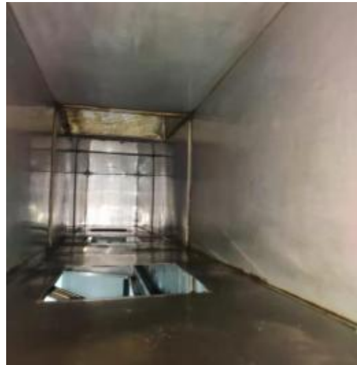
阅小串管道清洗后
