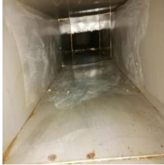
主管道清洗后 6
