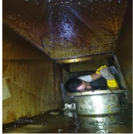
松烟楼管道施工中
