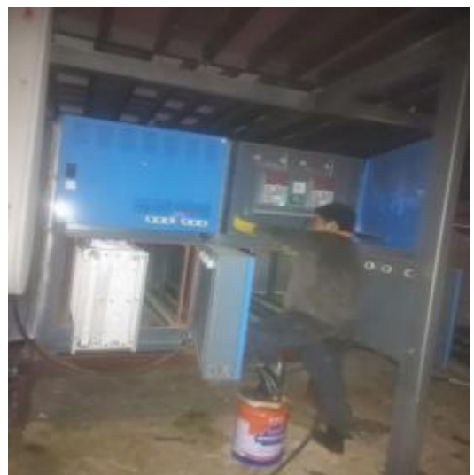
净化器机箱施工中
