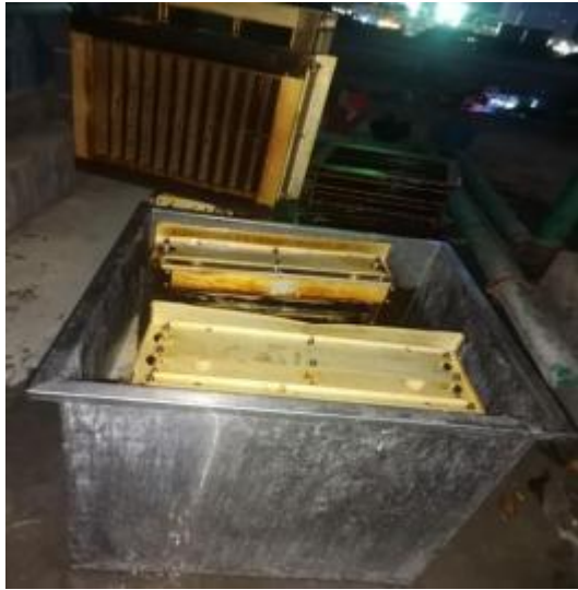
净化器施工中
