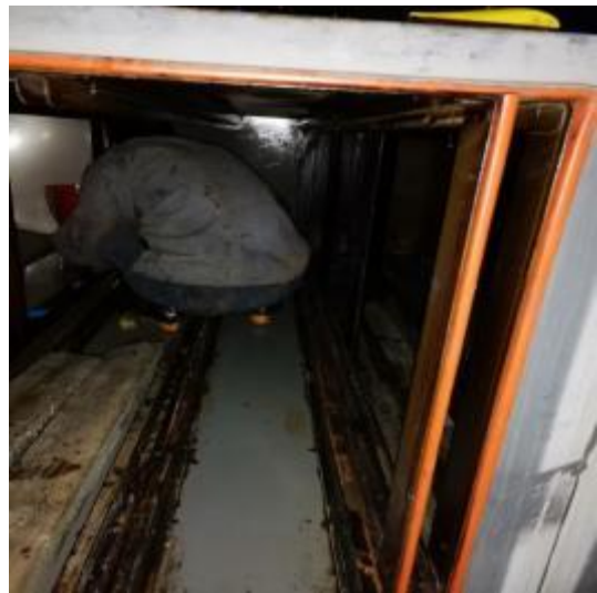
净化器内部施工中
