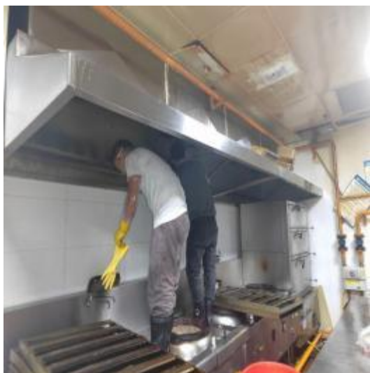
松烟楼烟罩施工中
