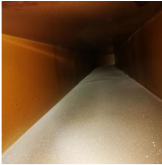
主管道清洗前 3
