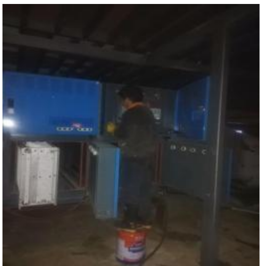
净化器机箱施工中
