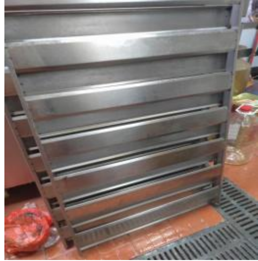
松烟楼防火板清洗后
