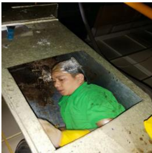
主管道施工中
