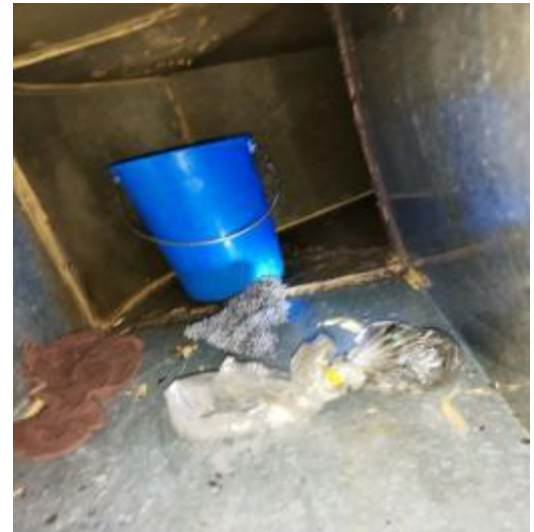
主管道施工中
