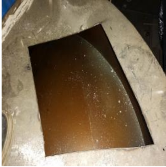
主管道施工中
