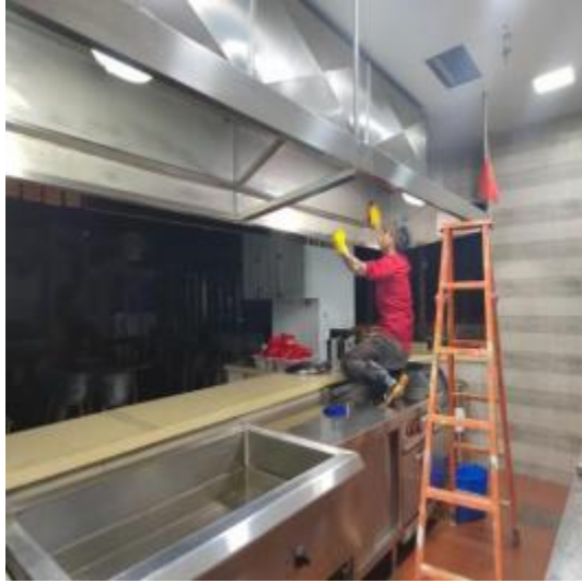
松烟楼烟罩施工中
