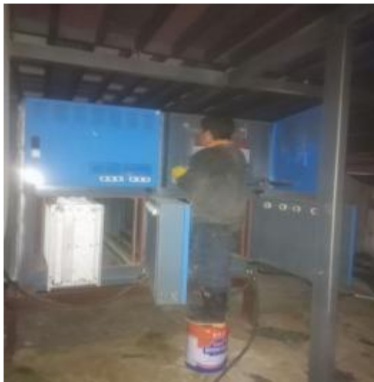
净化器机箱施工中
