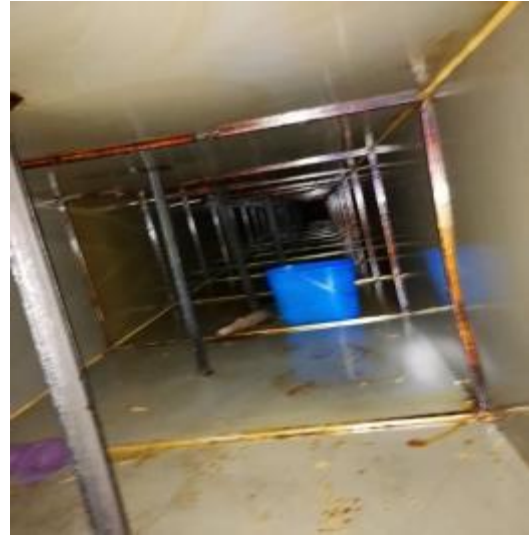
主管道施工中
