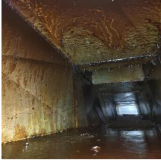
松烟楼管道清洗前
