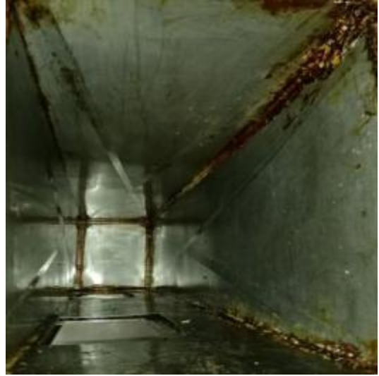
鱼夭夭管道清洗后
