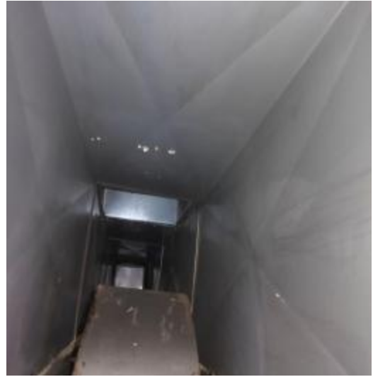
松烟楼管道清洗后
