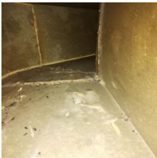
主管道清洗前 2
