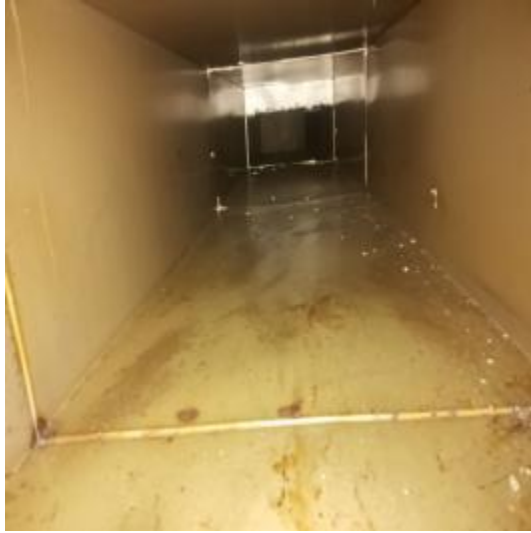
商场主管道清洗前 6
