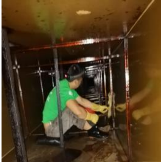
主管道施工中
