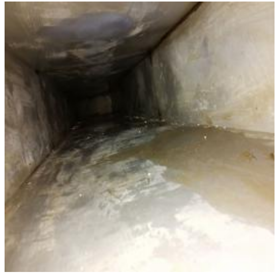
主管道清洗后 3
