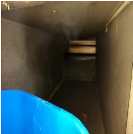
主管道施工中
