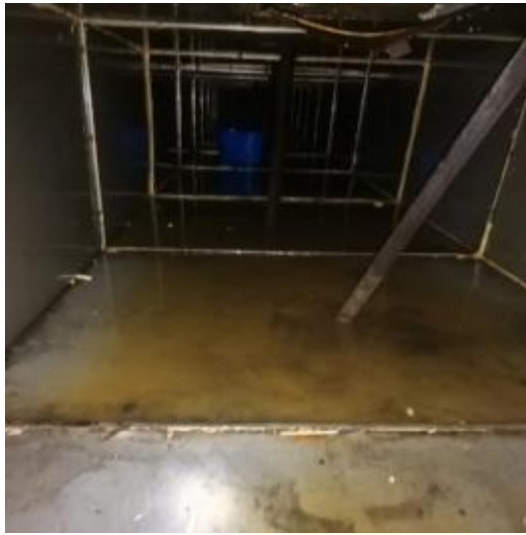
商场主管道清洗前 4
