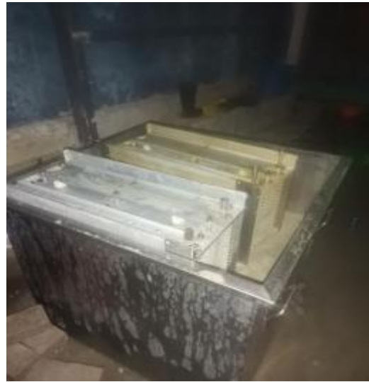
净化器施工中
