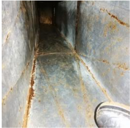
主管道清洗后 1
