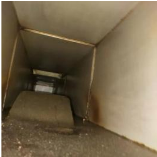
阅小串管道清洗前
