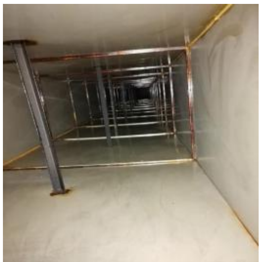
主管道清洗后 5
