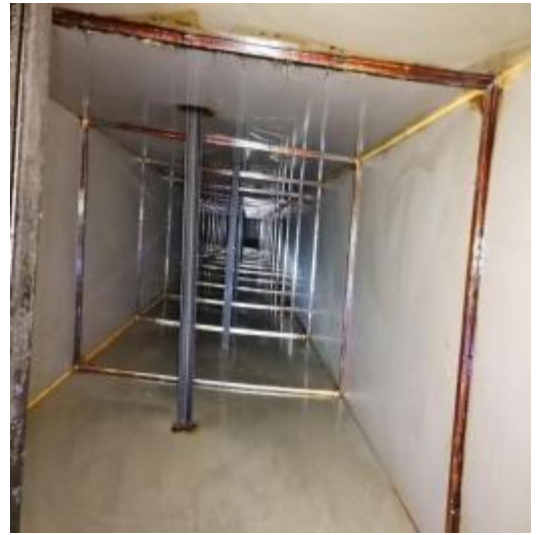
商场主管道清洗后 4
