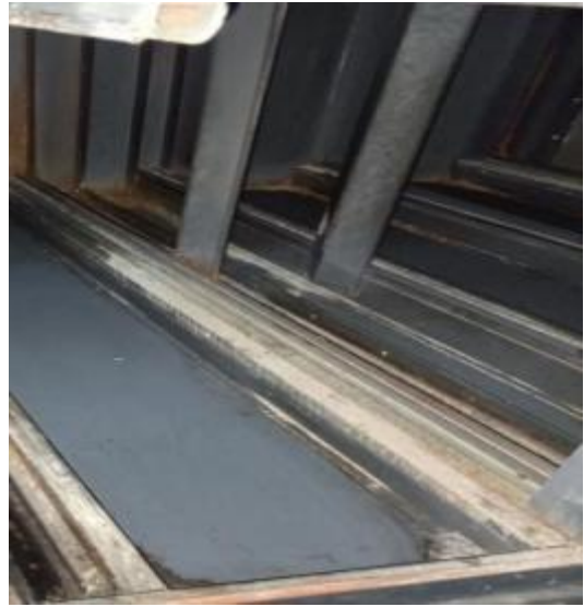
净化器内部清洗后 3
