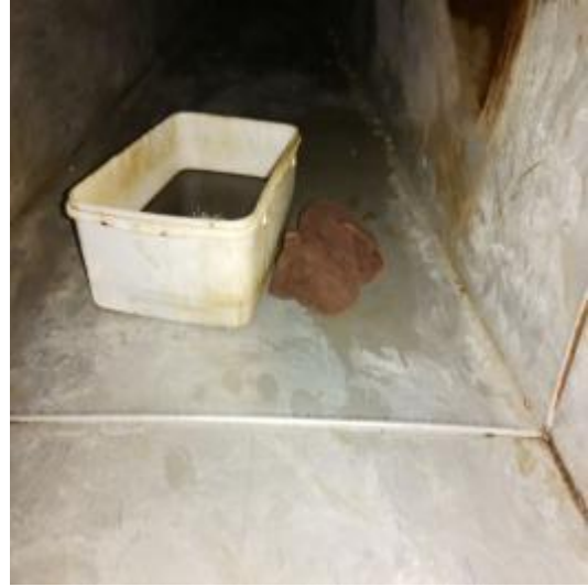
主管道施工中
