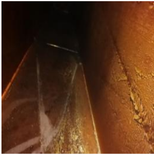
主管道清洗前 1
