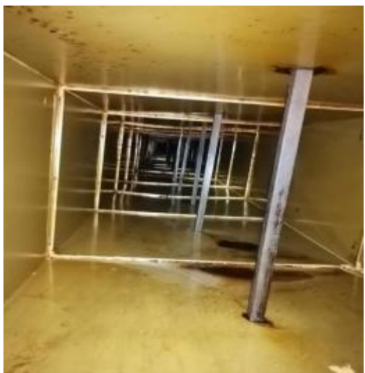
主管道清洗前 5
