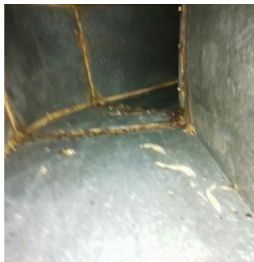
主管道清洗后 2
