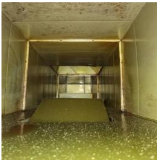
米馥管道清洗前
