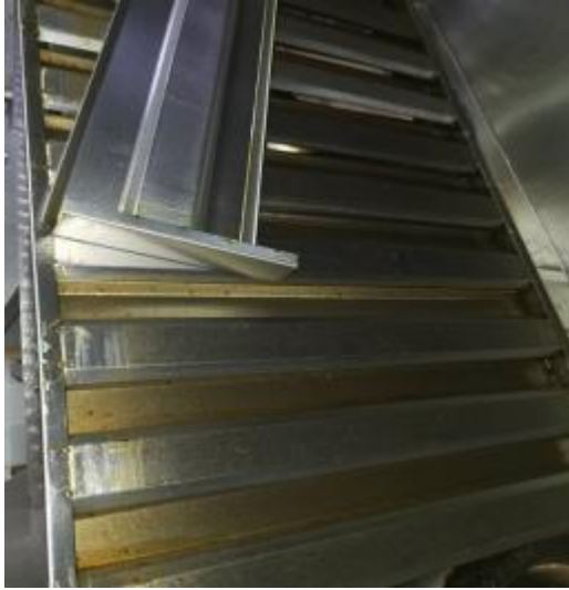
防火板清洗前
