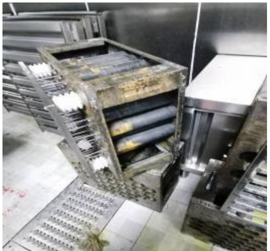
净化器施工中
