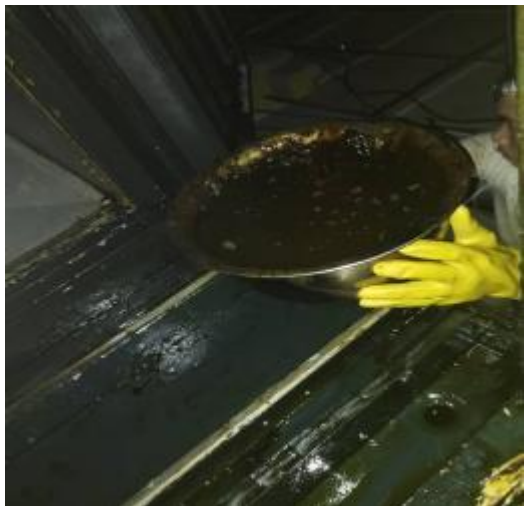
净化器机箱施工中
