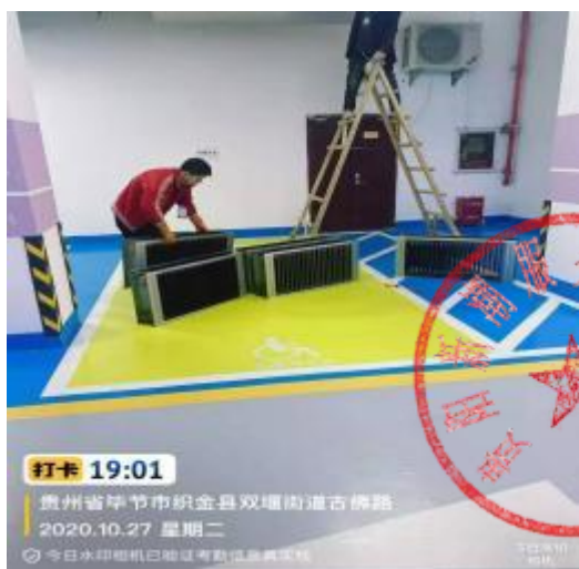
中厨房，员工厨房，烧烤房净化器施工
