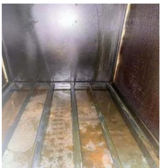
中厨房净化器机箱清洗前
