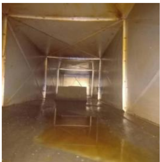
西厨房管道清洗前
