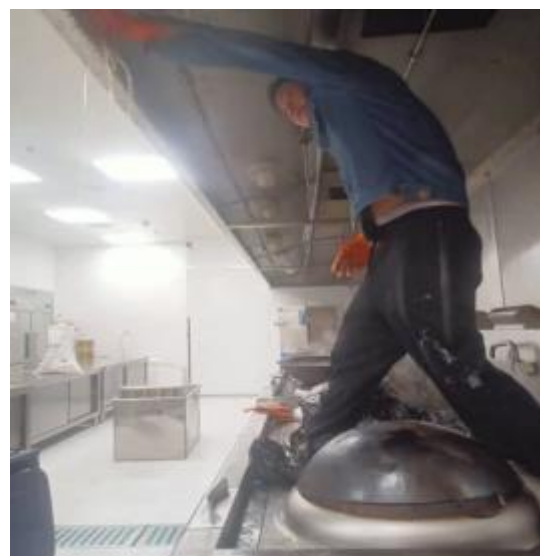
西厨房烟罩施工 2
