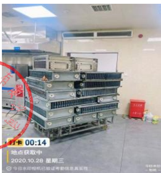
中厨房，员工厨房，烧烤房净化器清洗后
