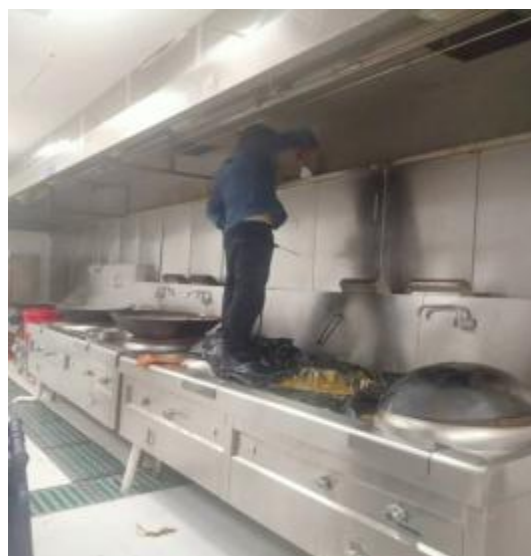
西厨房烟罩施工 1
