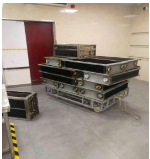
中厨房，员工厨房，烧烤房净化器清洗前
