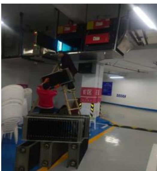
中厨房，员工厨房，烧烤房净化器施工
