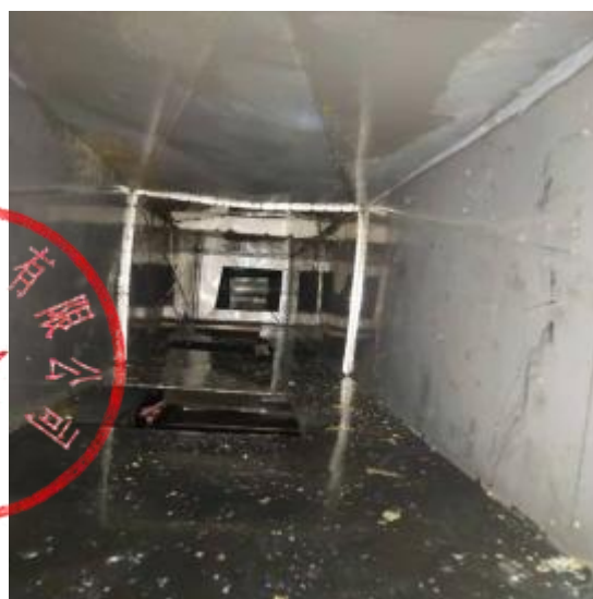
中厨房管道清洗后
