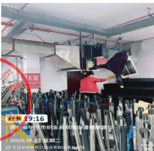
中厨房，员工厨房，烧烤房净化器施工
