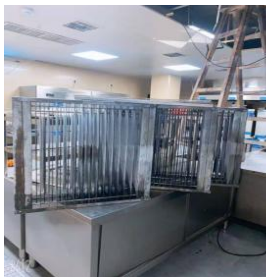
员工厨房净化器清洗后
