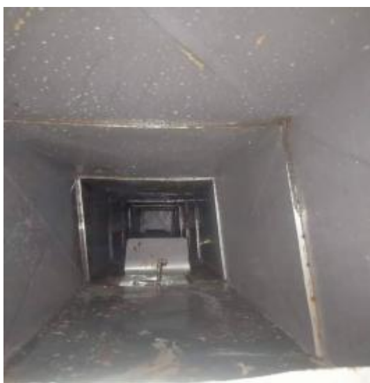
西厨房管道清洗后
