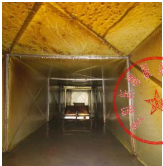
中厨房管道清洗前
