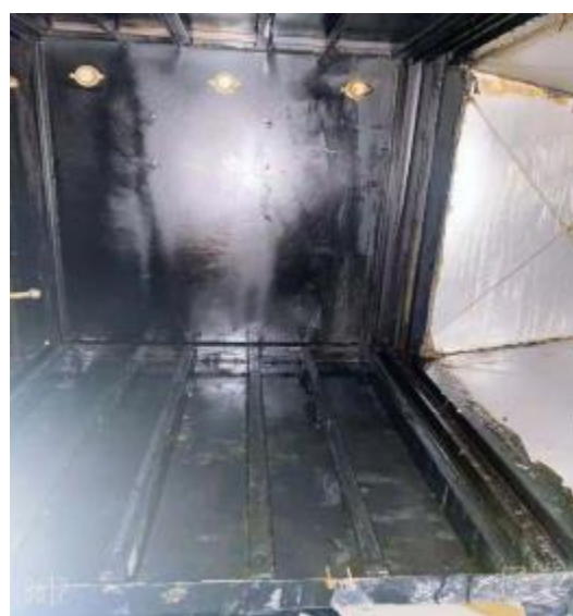
中厨房净化器机箱清洗后
