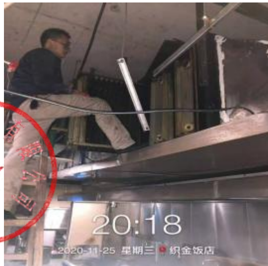
员工厨房净化器施工
