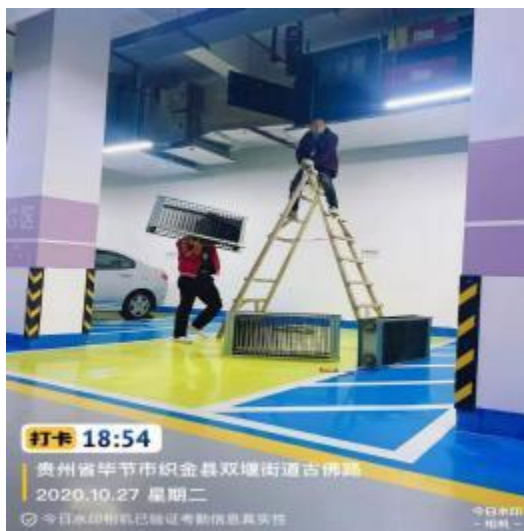
中厨房，员工厨房，烧烤房净化器施工
