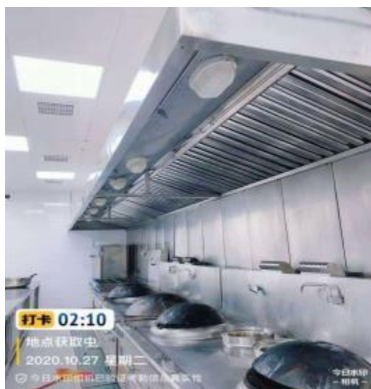
西厨房烟罩清洗后 1
