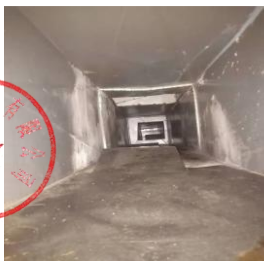
员工厨房管道清洗后
