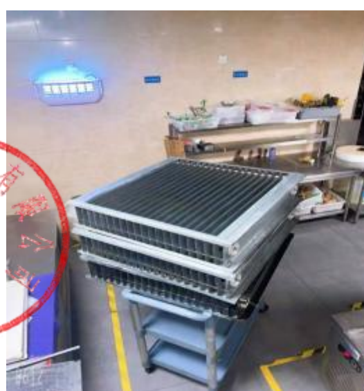
中厨房净化器清洗后
