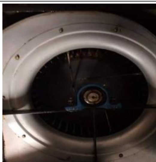
中厨房风机清洗后
