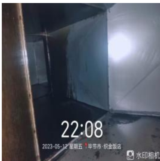
西厨房管道清洗前
