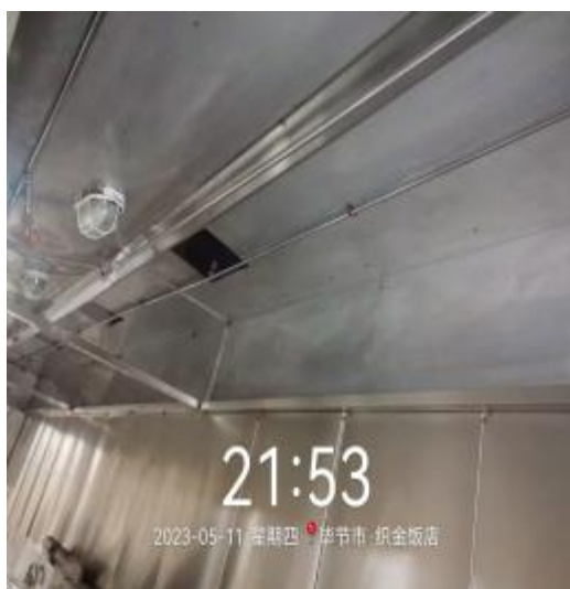
宴会厨房烟罩清洗后
