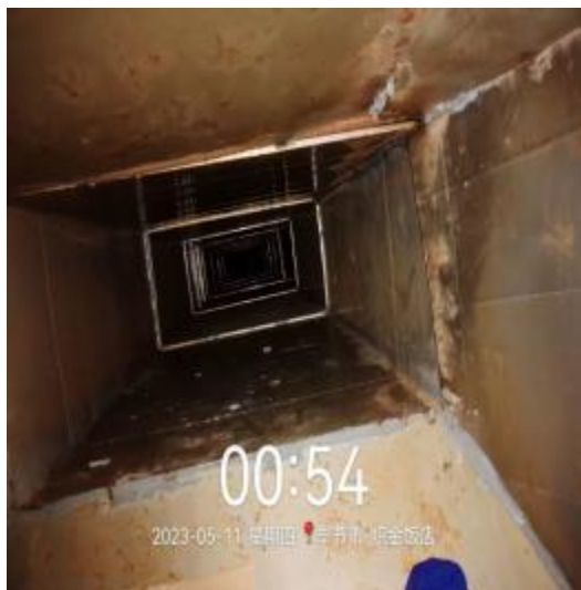
宴会厨房管道清洗前
