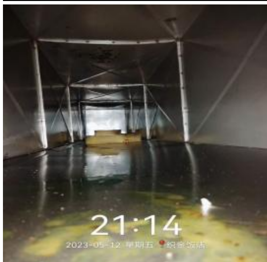
西厨房管道清洗前
