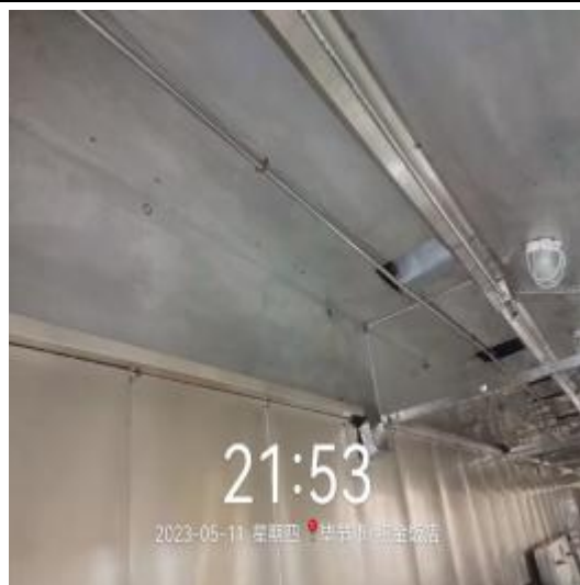
宴会厨房烟罩清洗后
