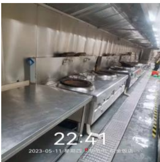
宴会厨房烟罩清洗后
