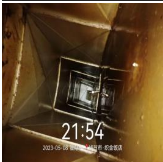
中厨房管道清洗前
