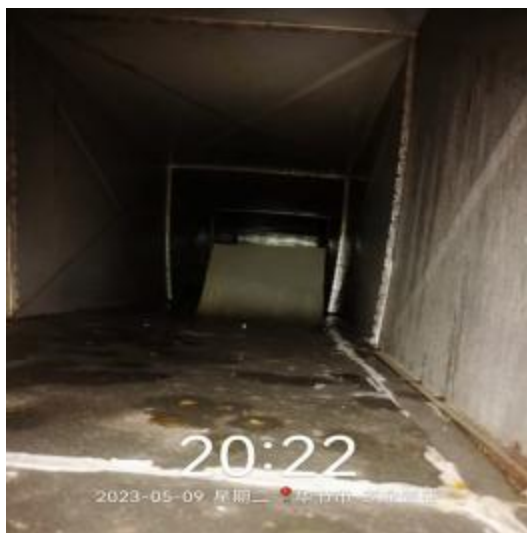
员工厨房管道清洗前
