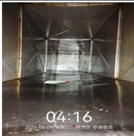
中厨房管道清洗后
