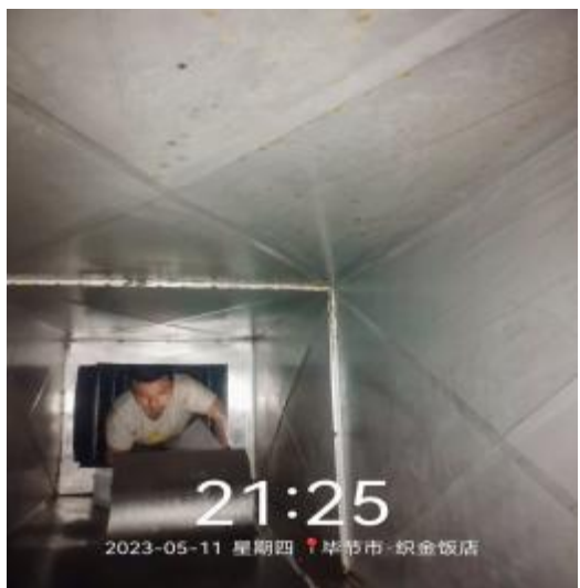
宴会厨房管道清洗前
