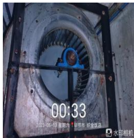
西厨房风机清洗后
