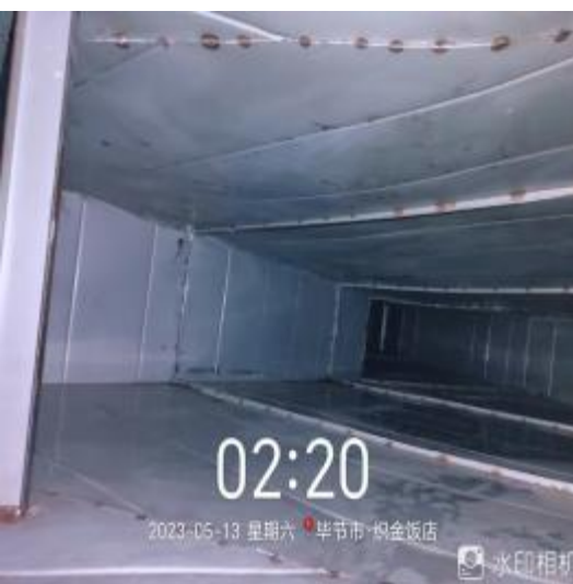
主管道清洗后
