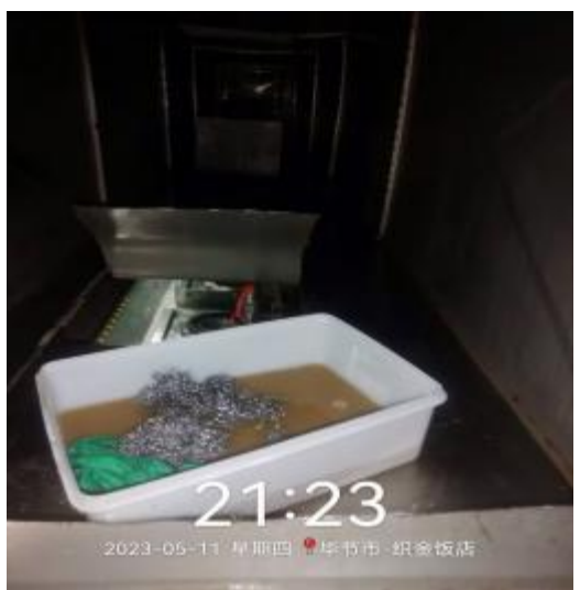
宴会厨房管道清洗中
