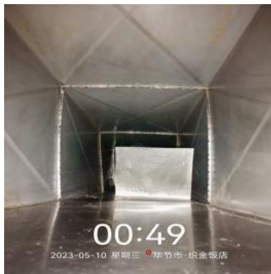
员工厨房管道清洗后
