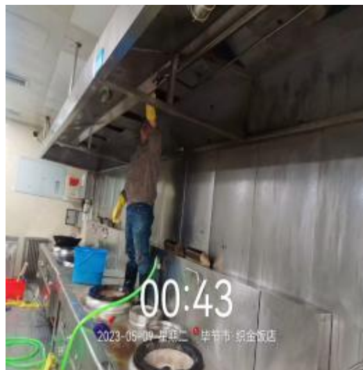
中厨房烟罩清洗中
