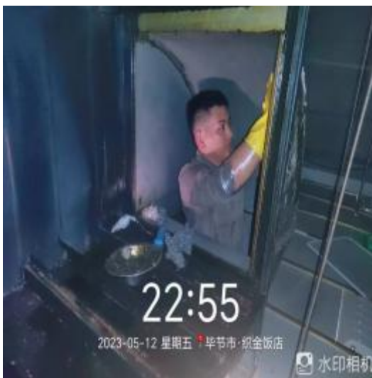
宴会厨房管道清洗后
