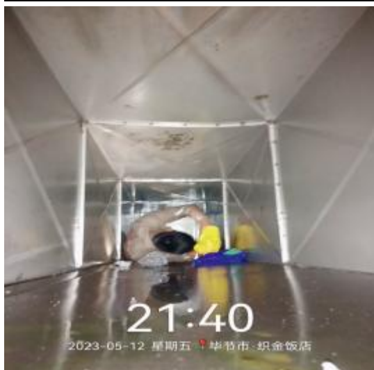
西厨房管道清洗中
