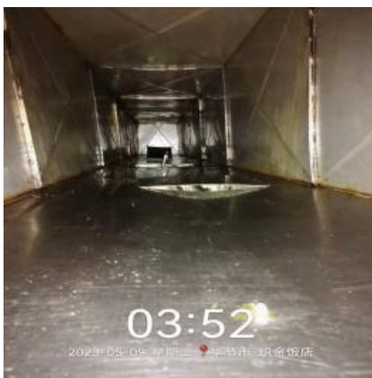
中厨房管道清洗后
