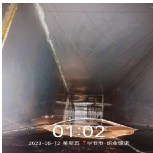
西厨房管道清洗后
