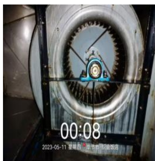
宴会厨房风机清洗后
