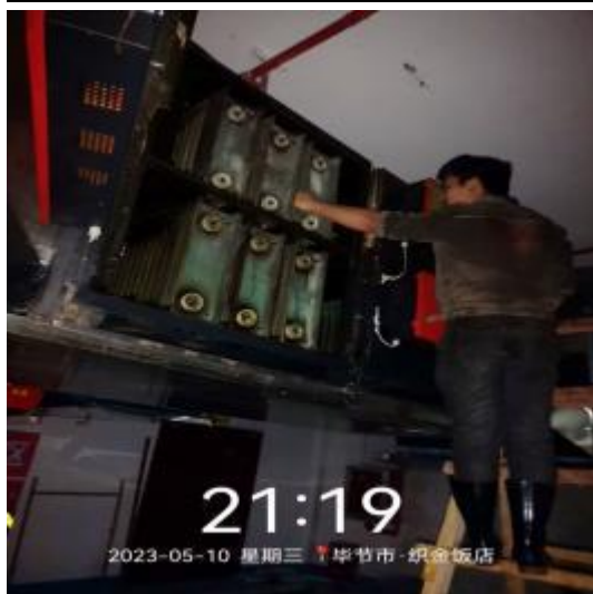
中厨房净化器施工中
