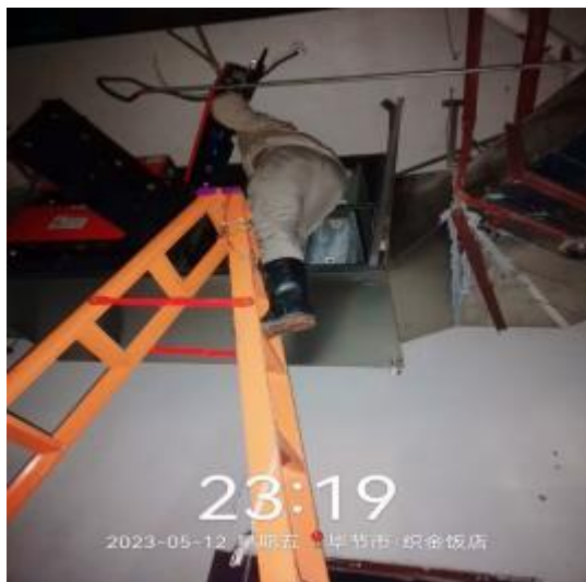
西厨房净化器施工中
