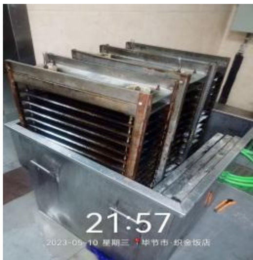
宴会厨房净化器清洗前
