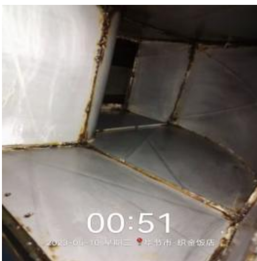
员工厨房管道清洗后
