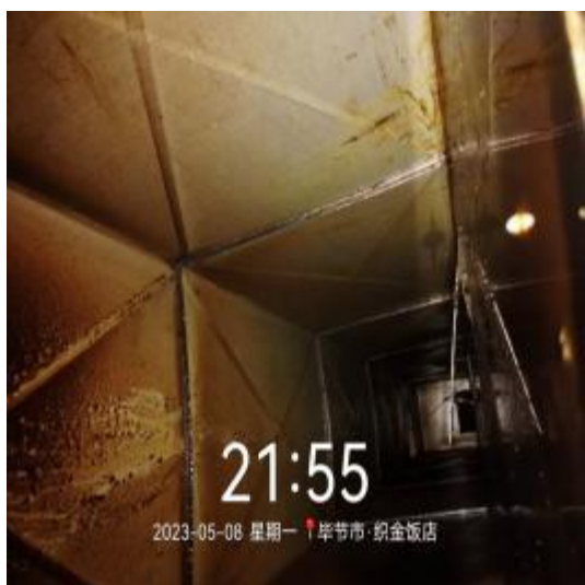
中厨房管道清洗前
