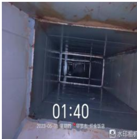
宴会厨房管道清洗后
