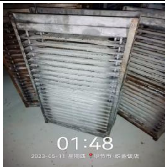
中厨房净化器清洗后
