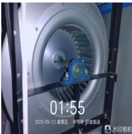
员工厨房风机清洗后
