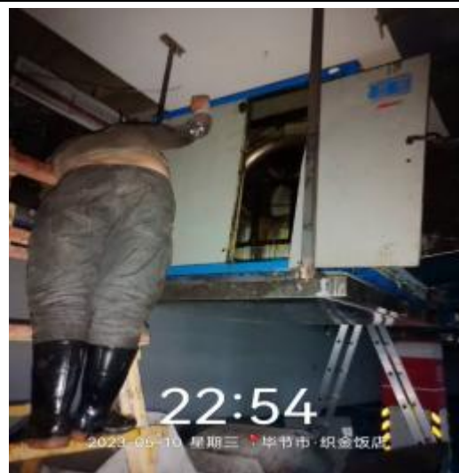
中厨房风机施工中
