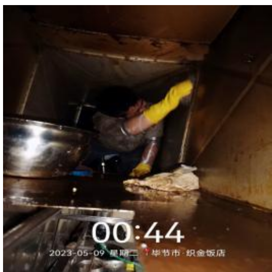
中厨房管道清洗中
