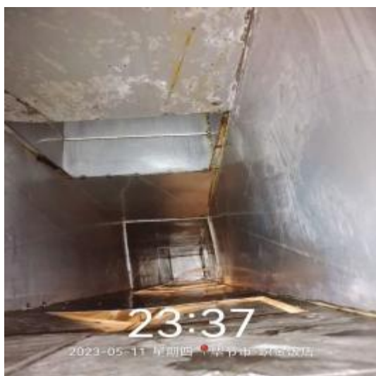
西厨房管道清洗前
