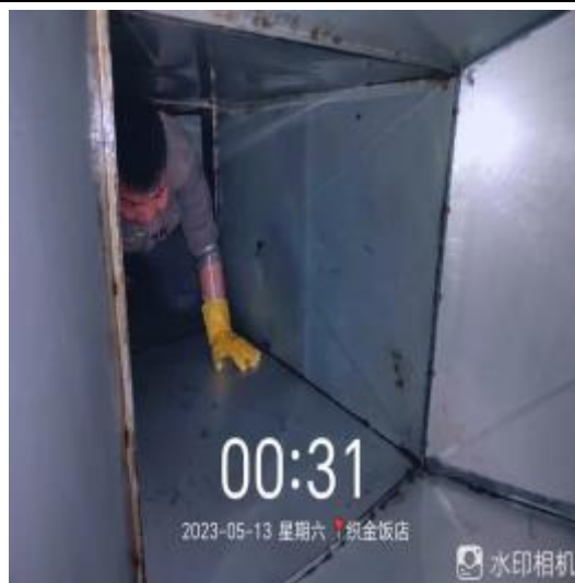
西厨房管道清洗中
