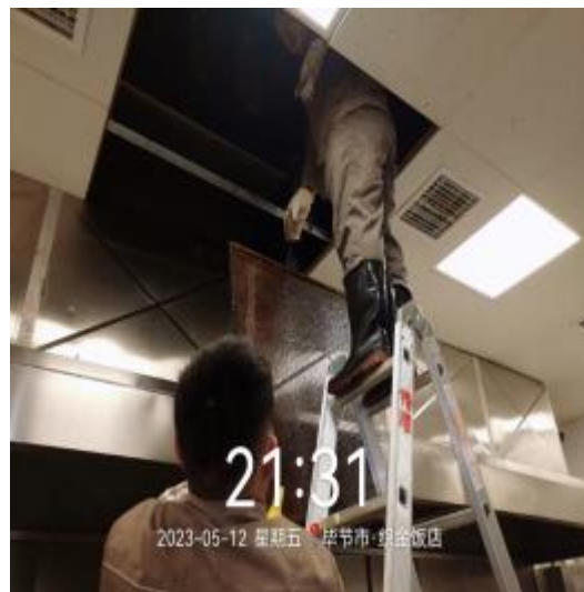
西厨房净化器施工中
