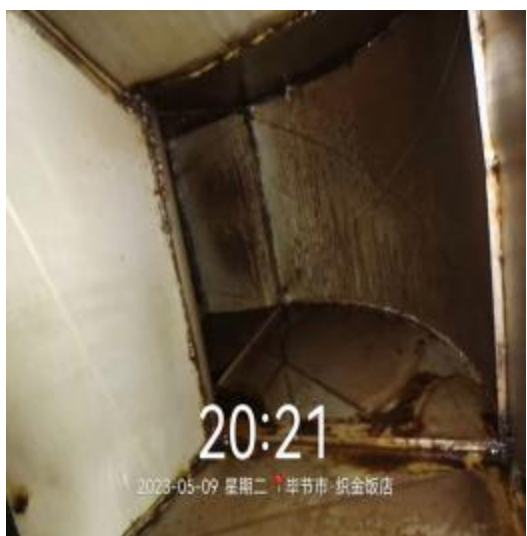
员工厨房管道清洗前
