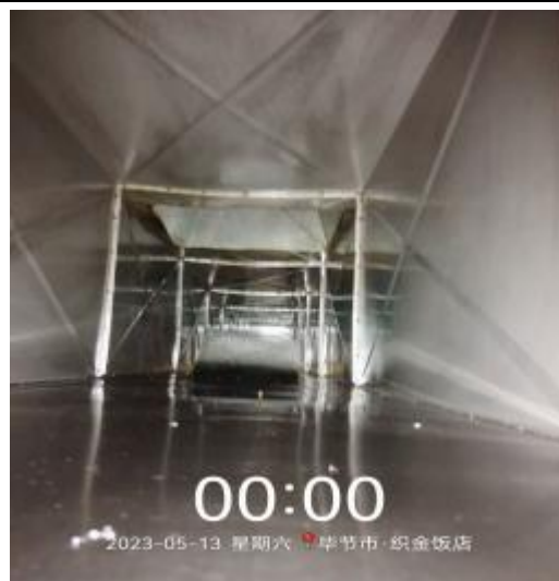
西厨房管道清洗后
