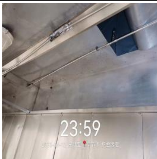
西厨房烟罩清洗后
