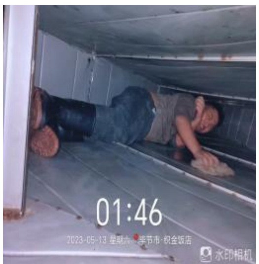
主管道清洗中
