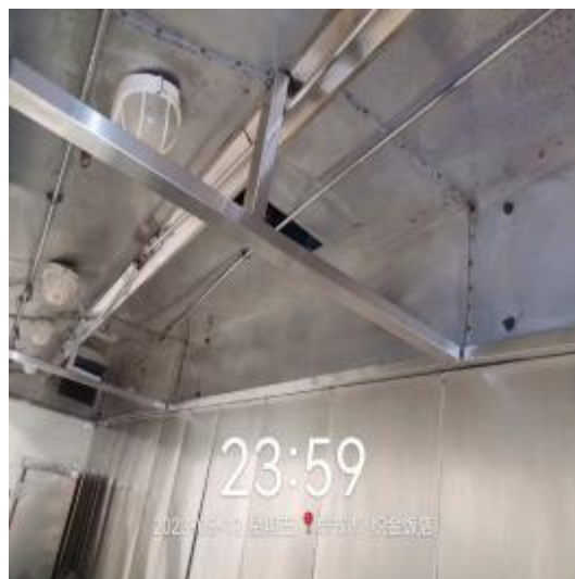
西厨房烟罩清洗后 2
