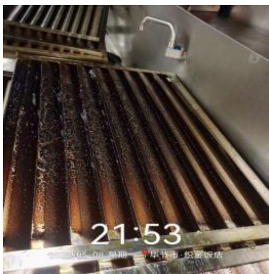
防火板清洗前
