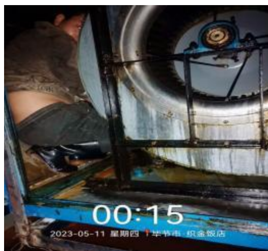
宴会厨房风机清洗中
