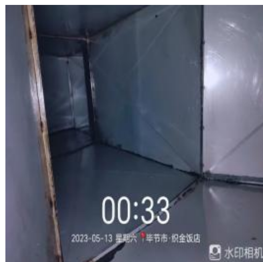
西厨房管道清洗后
