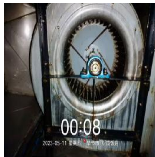
中厨房风机清洗后
